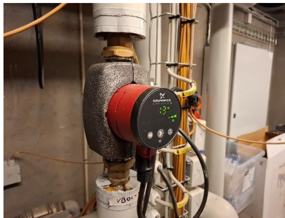
Cirkulationspumpe
