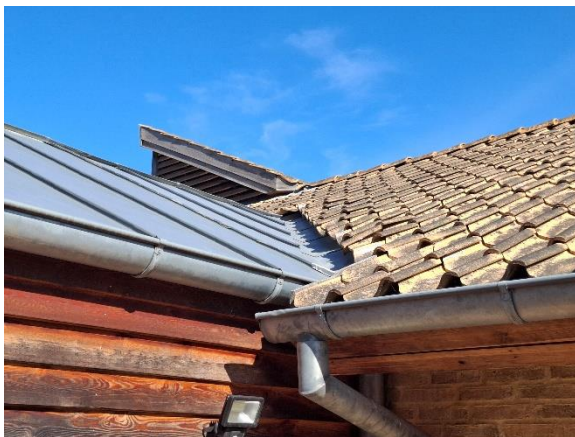
Tagrender, skotrender og nedløb i zink er uden mangler.
