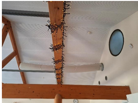
Indblæsningspose i køkken
