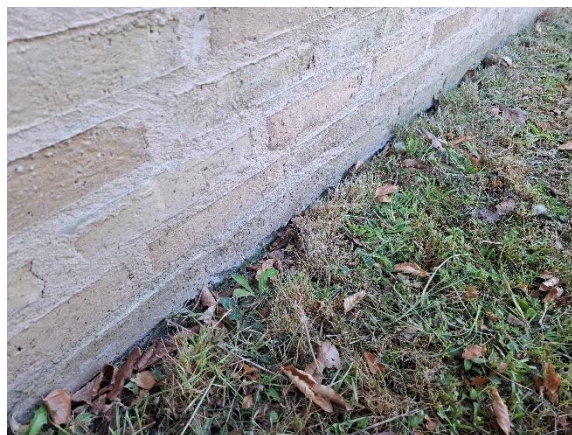
Terræn ført over sokkel som skaller af i pudsede flader.
