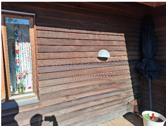
Let ydervæg med ubehandlede træbeklædning.
