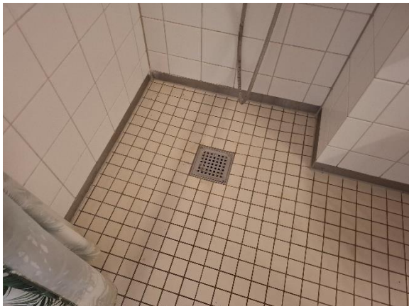
Gulvafløb i badeværelse
