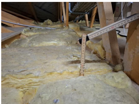
Isolering målt til ca. 350 mm.
