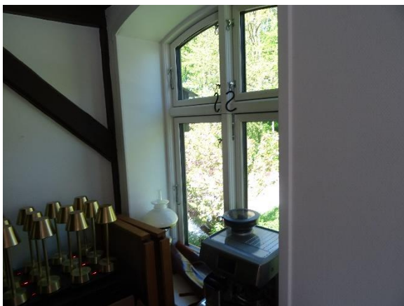
Gavl på 1. sal der er indvendigt isoleret
