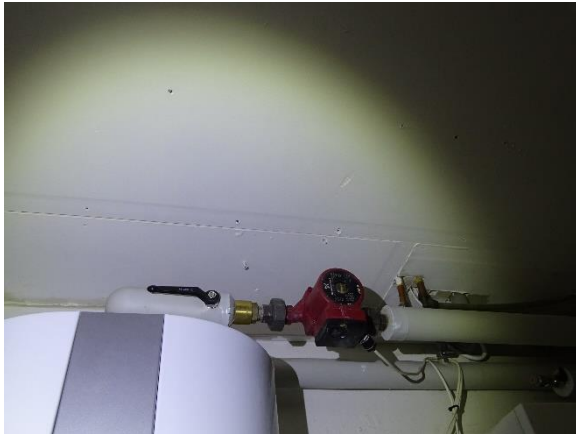
Pumpe over varmtvandsbeholder
