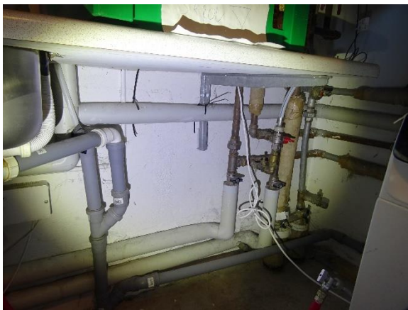
Afløb i fyrrum tilslutning med tape
