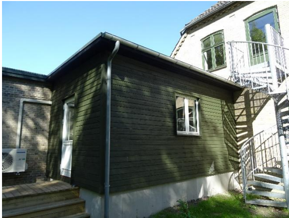
Tilbygning i let konstruktion mod syd
