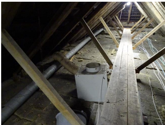
Frakoblet boksventilator
