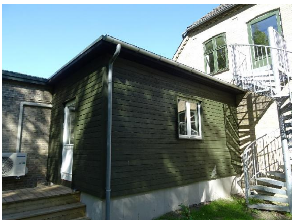
Tilbygning i let konstruktion mod syd
