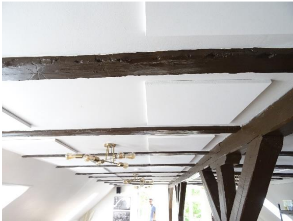
Belysning i serveringsrum
