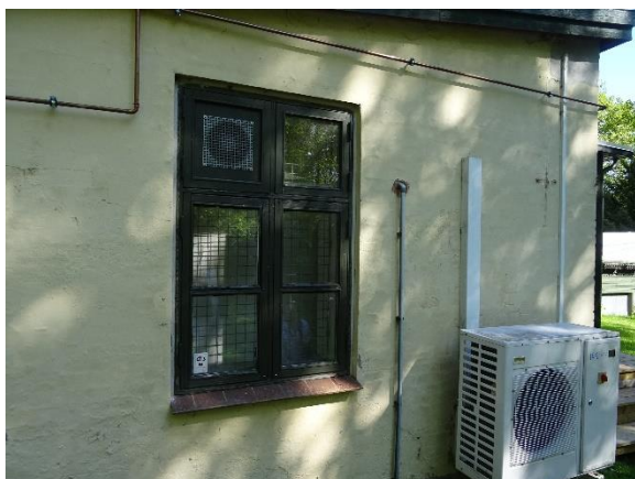
Ældre vindue med termorude i lager
