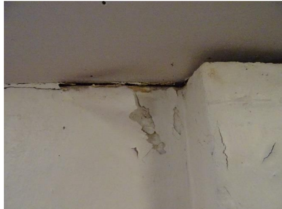
Væg/loft i lagerlokale
