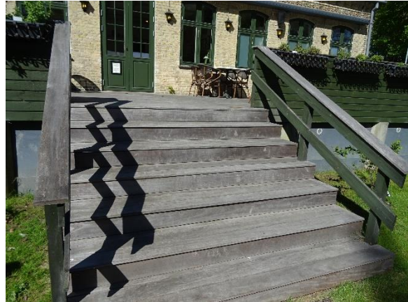
Terrassetrappe på bagsiden.
