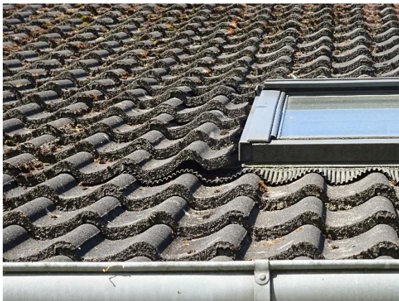
Tag ved tagvindue inddækning
