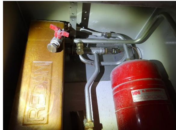
Veksler og ekspansionsbeholder
