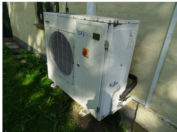
Kondensator for køleanlæg til køle/fryserum
