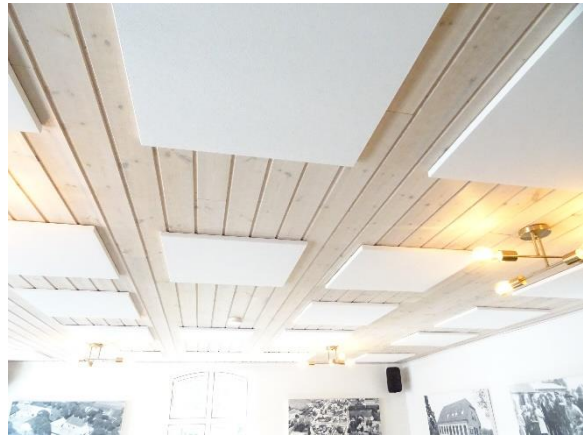
Belysning i serveringsrum
