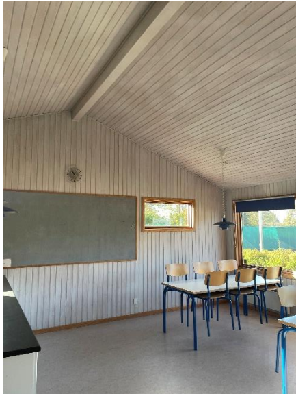
Snit af loft, væg og gulvflader
