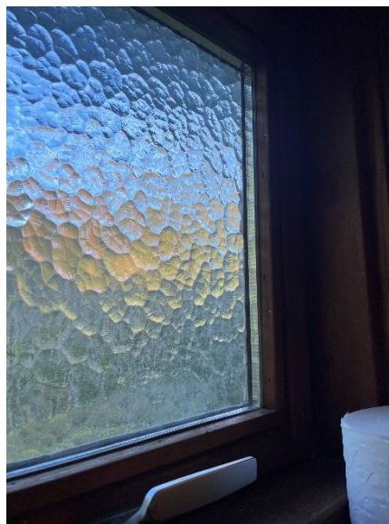
2 lags energirude fra 2005 i omklædning herre
