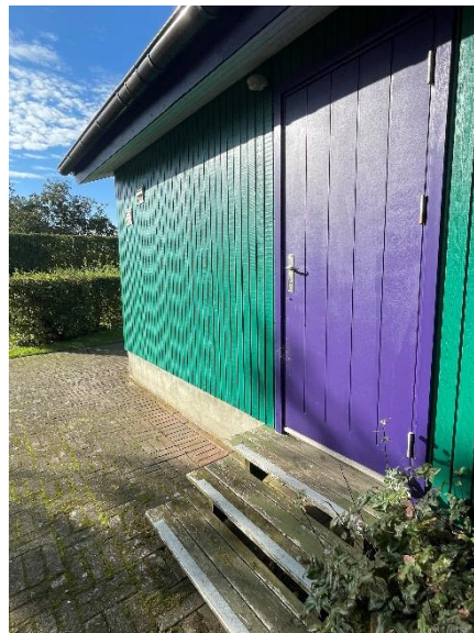
Massiv nyere hoveddør set udefra
