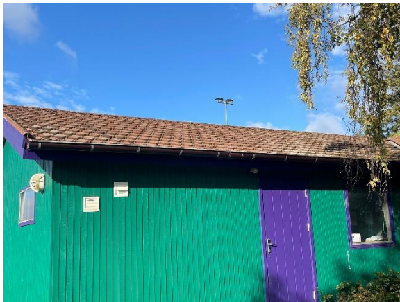
Taget set fra indgangsfacaden
