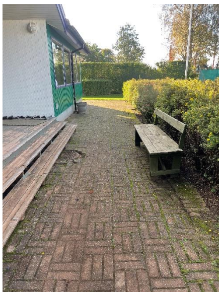
Belægning foran bygningen
