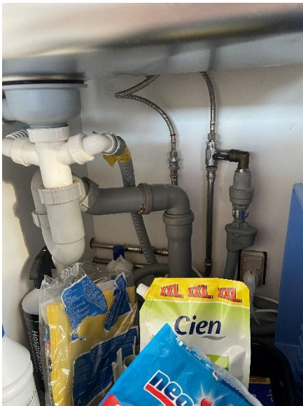
Afløb under håndvask i køkken.
