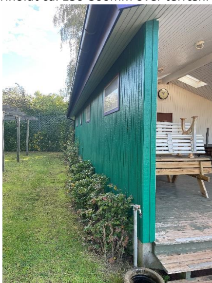
Træfacaden set fra tennisbaneenden ud mod tørrestativet
