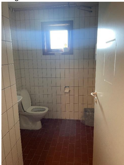
Toilet til dameomklædningen, 1 skyl
