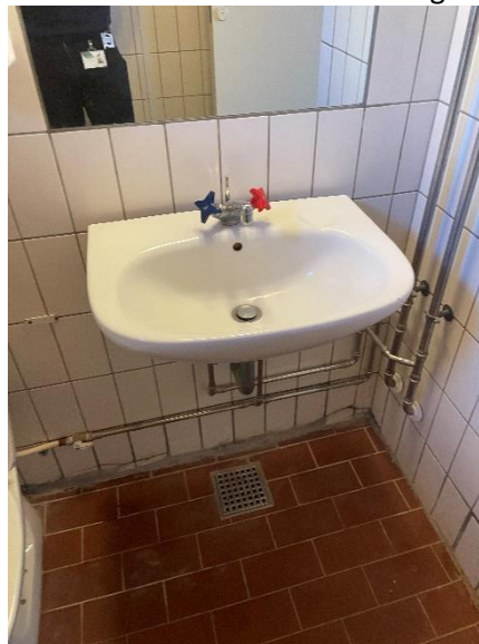
Togrebs håndvaskearmatur på toilet til herreomklædningen
