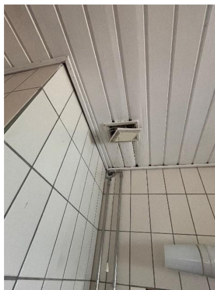
Ventilationsskakt i toilet.
