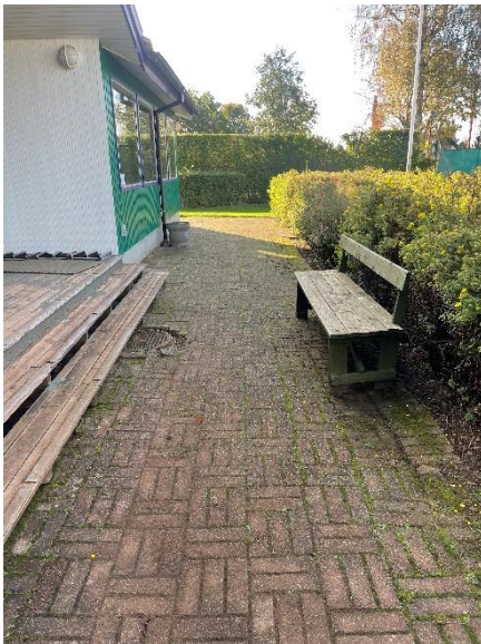
Kloakdæksel ses til venstre under terrasse trin
