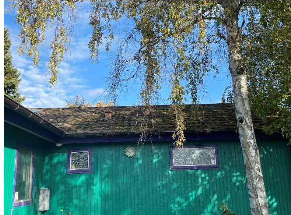
Mosbelægning på tag del under træ
