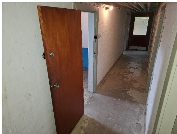
Døre til opgange uden pumpe.
