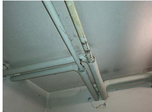
Loft i kælder
