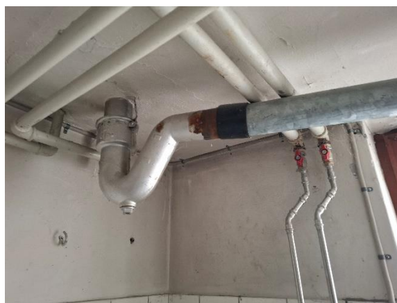
Overgang fra ældre støbejernsfaldstamme til nyere rør i galvaniseret stål.
