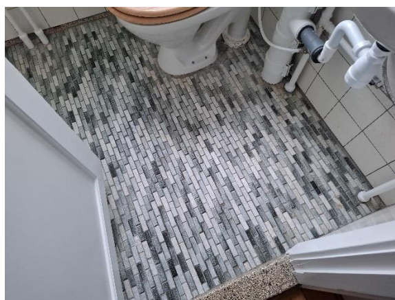
Gulv i badeværelse i bolig
