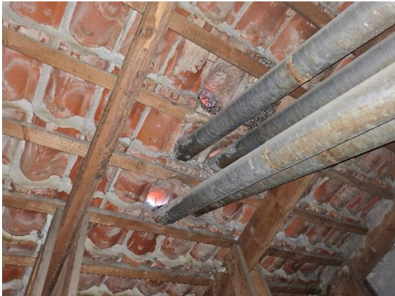
Ventilationskanal er gået fra i bygning 1
