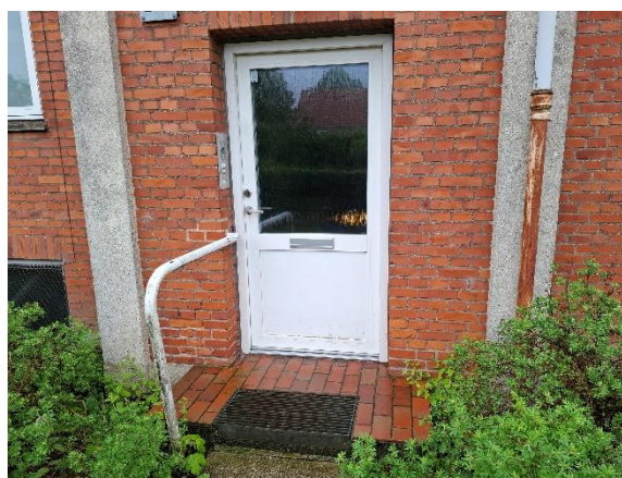
Dør til trappeopgang
