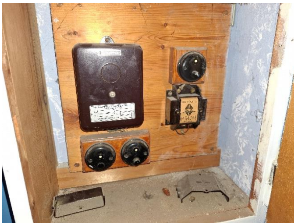
Timer til belysning i trappe i opgang
