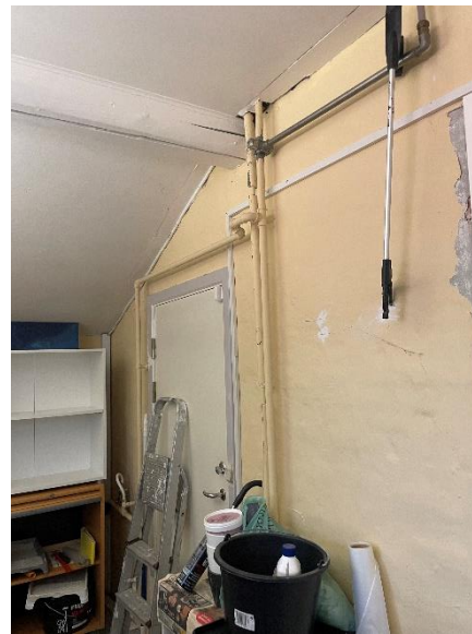
Uisoleret rum værksted/opbevaring.
