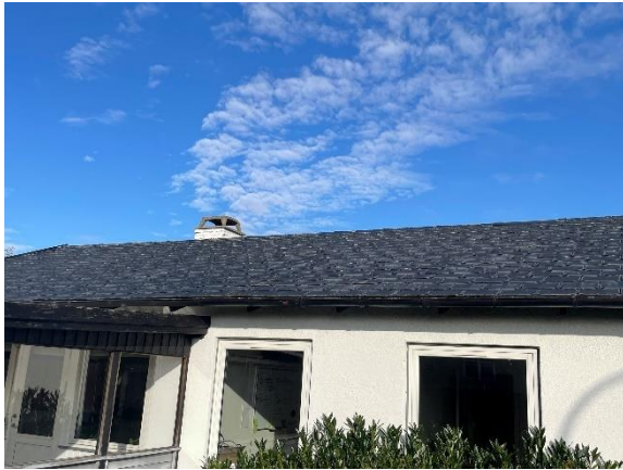
Tagbelægningen set fra havesiden
