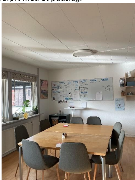
Laminat gulv, systemloft og malet gipsvægge ud mod terrassen
