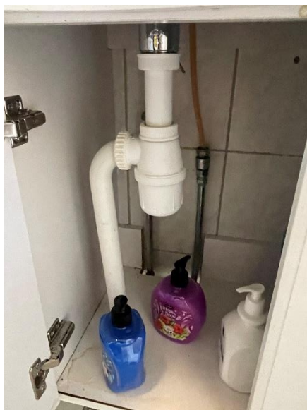
Afløb under håndvask på toilettet
