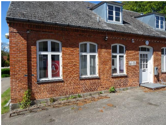
Vinduer med termoruder 1980
