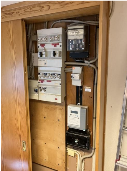
Fordelingstavle med måler for ejendom 1. sal.
