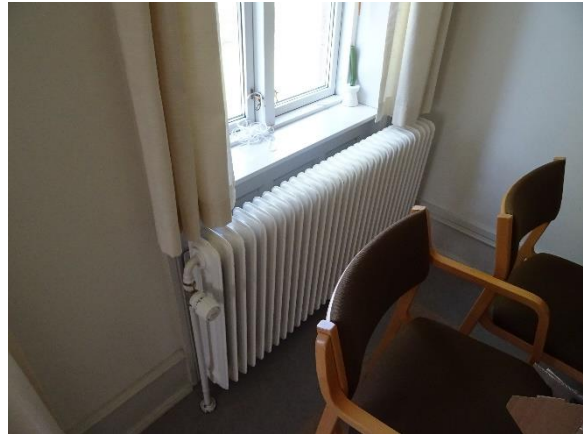
Søjleradiator på et-streng
