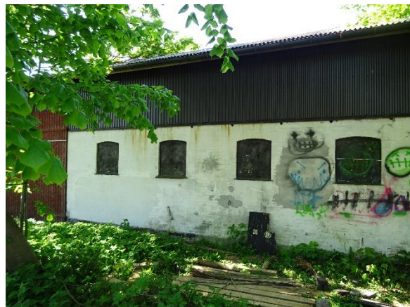
Facade øst bygning 2
