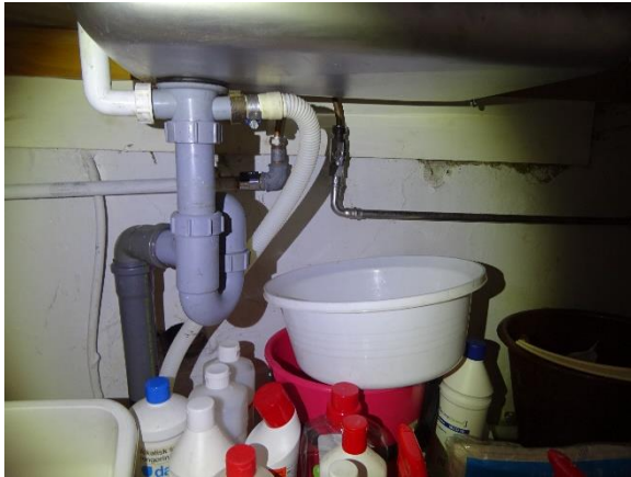
Udskiftet koblingsledning i rustfri til højre
