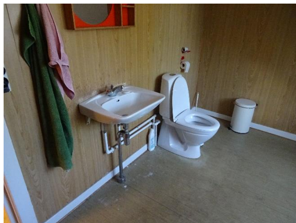
Toilet 1. sal med finervægge og vinyl gulv
