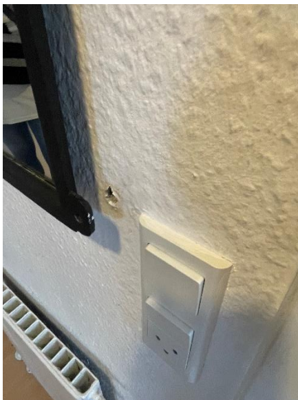
Udskiftet kontakt ved entre
