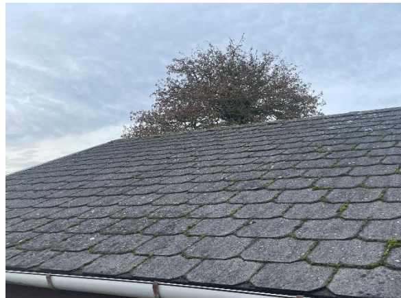
Eternit pladebelægning på taget mod syd
