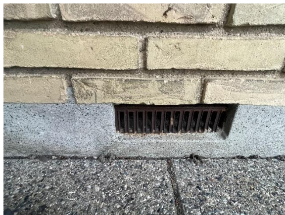
Sokkelventilation
