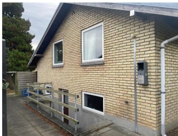
Endegavlfacaden med kælderdoor
