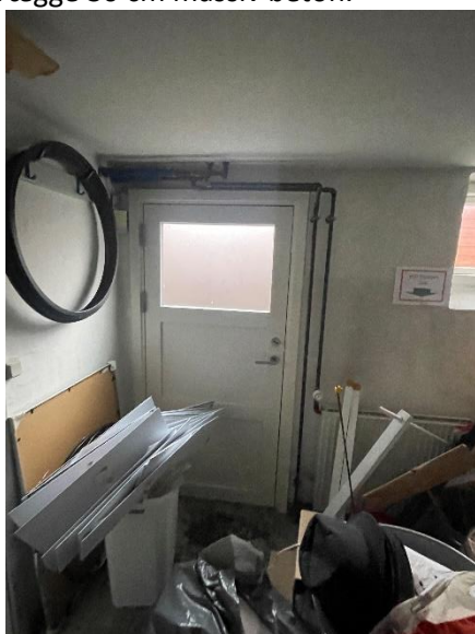
Kælder set ud mod kælderdoor
