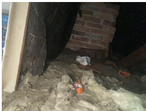
Loftisolering op mod skorsten.
