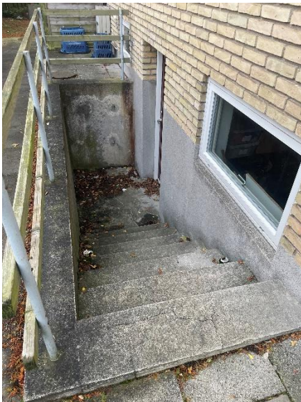
Betontrappe ned til kælder dør
