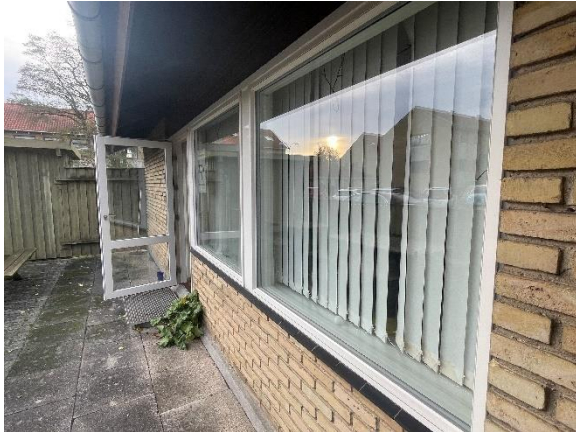
Vindue med energiruder i vinduesparti på syd facaden
