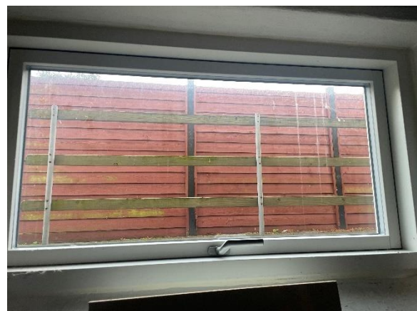
Kælder vindue med energirude
