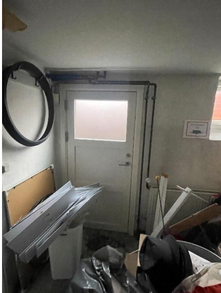
Kælderdøren set fra indersiden
