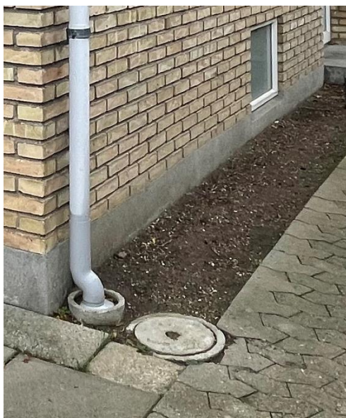
Brønddæksel ved nordsiden af bygningen.
