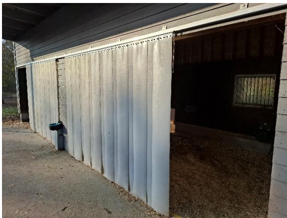
Skydeporte med plastforhæng i hestestald.
