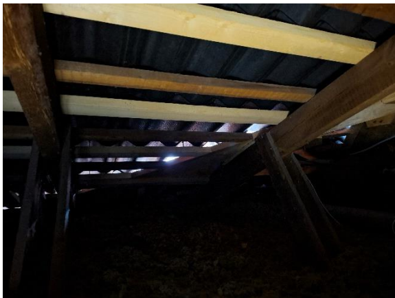
Der mangler skumbølgeklodser i bølgepladernes ender ved skotrende.
