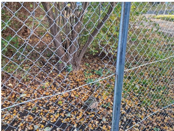
Trådhegn omkring institutionen er med flere huller og trænger til udskiftning især mod nord.
