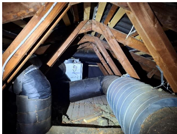
Kanaler i loftrum
