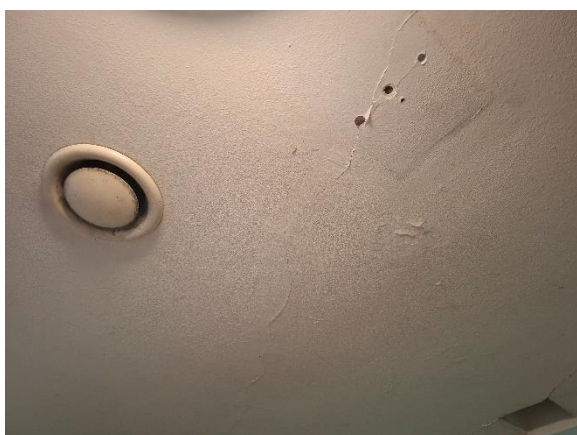
Kontrolventil på toilet
