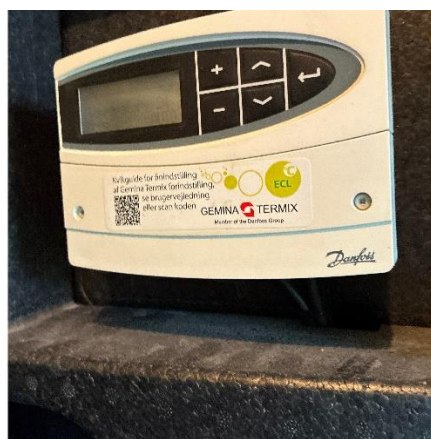
Danfoss ECL styring
