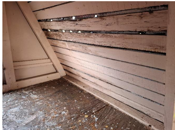
Huller i tag med råd i træværk til følge på legehuset.
