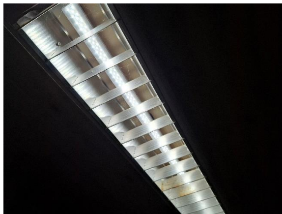
LED lyskilde i ældre armatur i sløjde
