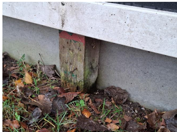
Kaninhuset er med råd i stolper med direkte kontakt til jord.
