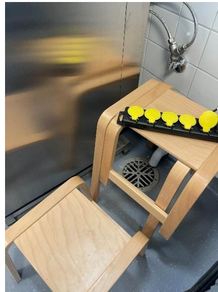
Afløb i køkken bag maskine
