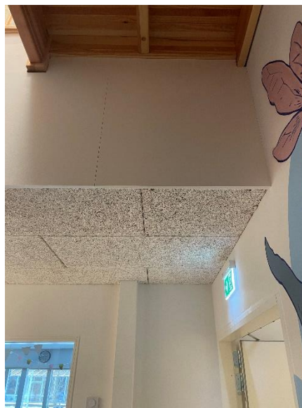
Etageskillelse under trappe mod 1.sal set fra stueetagen
