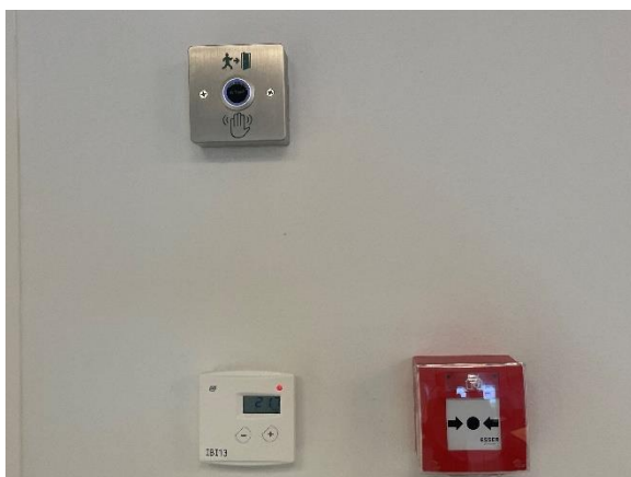
Nøddåbning til dør, temperatur indstilling og brand tryk
