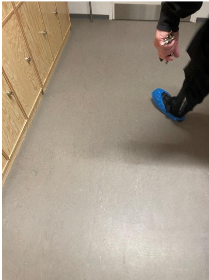
Linoleumsgulv ved hovedindgang
