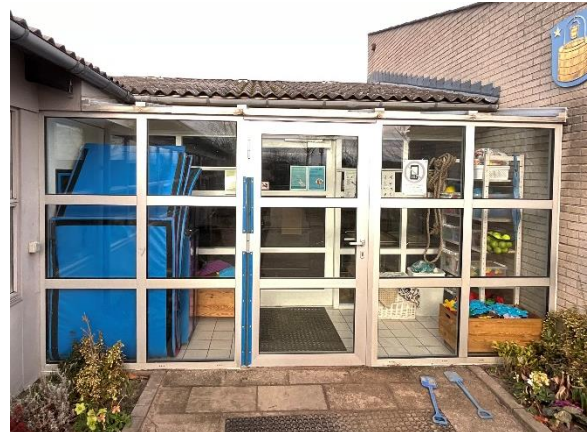
Vindfang med 2-lags termoruder fra 1997.
