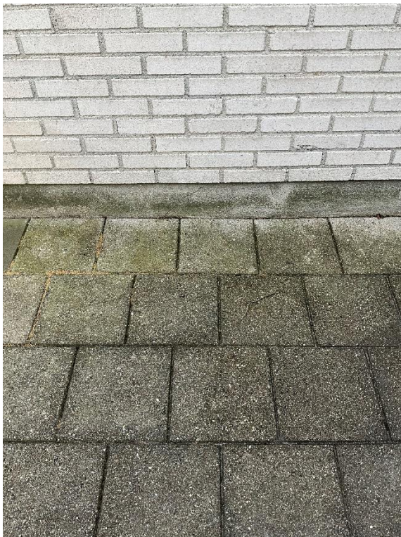
Facade murværk og sokkel.
