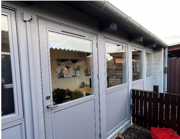
Nye dør og vindues installationer
