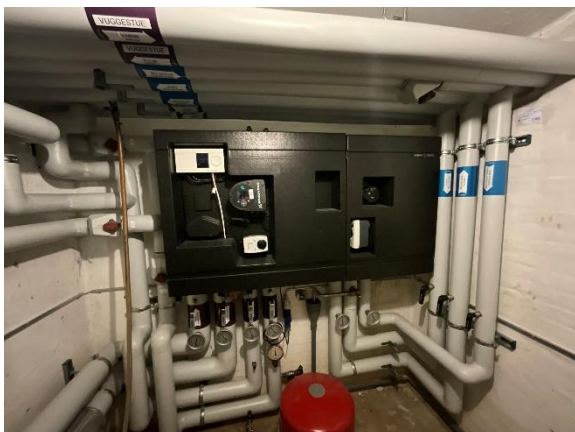
Combi fjernvarme vekslerunit
