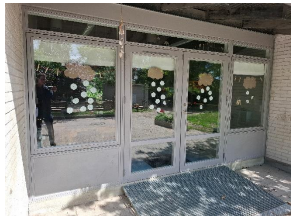
Facadepartier i oprindelig bygning
