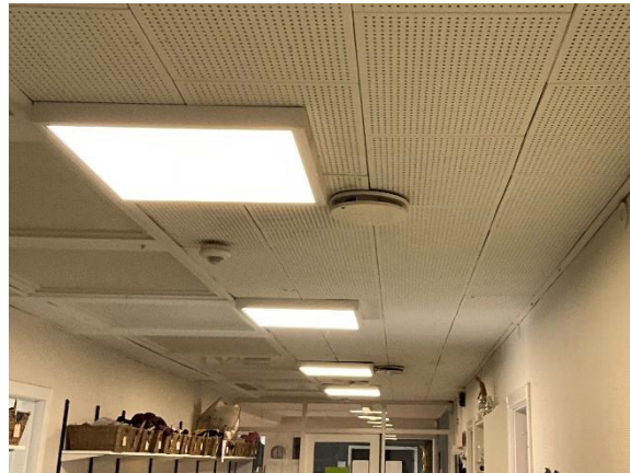
LED-armaturer i gang i oprindelig bygning.
