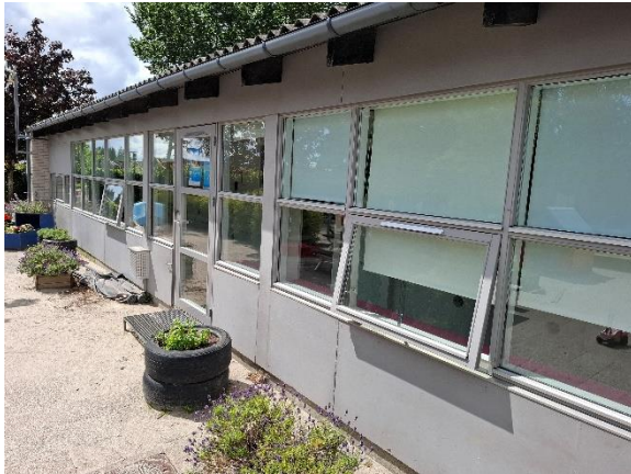
Oprindelige vinduer i tilbygningen mod øst.
