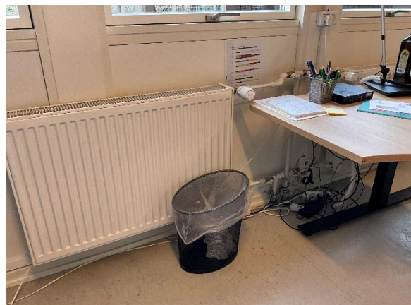
Radiator varm nye ventiler og termostatsføler
