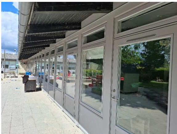
Facadepartier i oprindelig bygning
