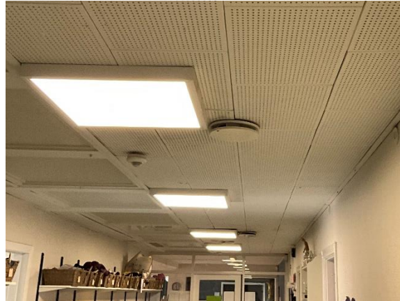
LED-armaturer i gang i oprindelig bygning.
