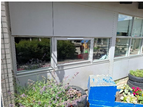
Facader på tilbygning.
