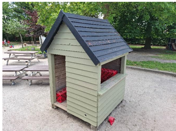
Legehus med begyndende afskalning i maling.
