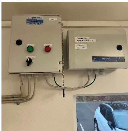
GSM Modul og pumpestyring
