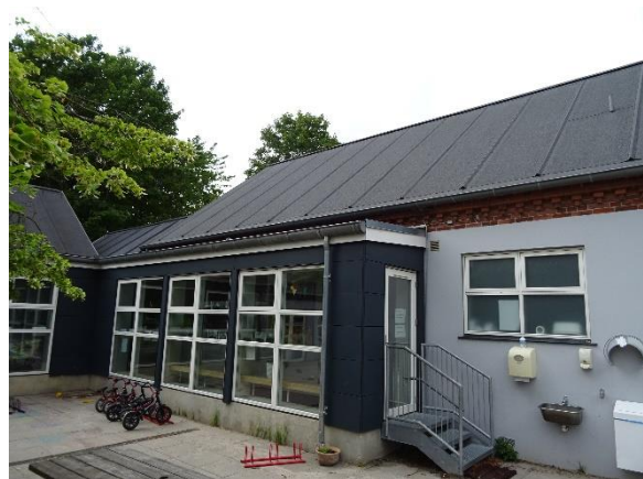
Yderdør og glaspartier med energiruder
