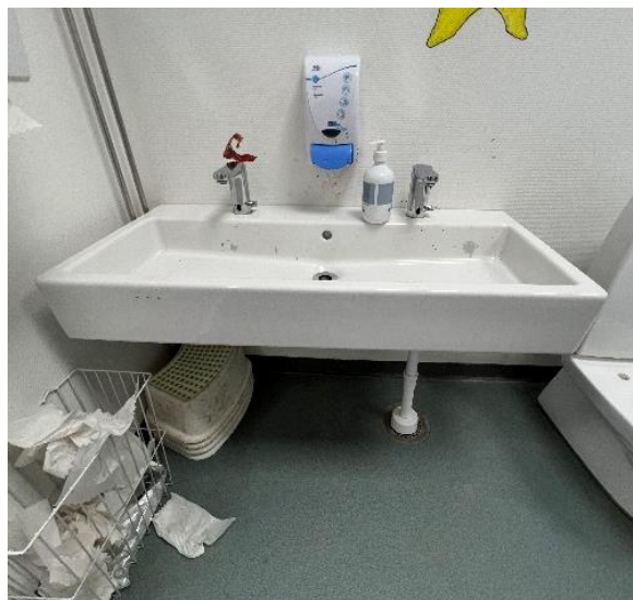
Afløbet er ført til gulv og tilsluttet afløbsstuds
