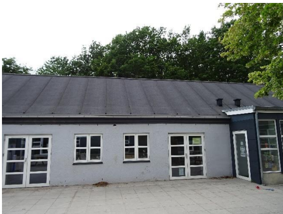
Træ/alu vinduer mod gård, vestfløj
