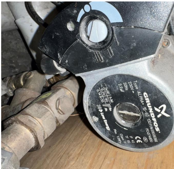
Trinstyret varmfordelingspumpe
