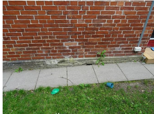
De ældste sokler har en del afskalning
