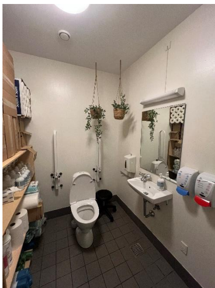
Afløb fra håndvask er lagt i væg med tilslutningen til gulv afløb.
