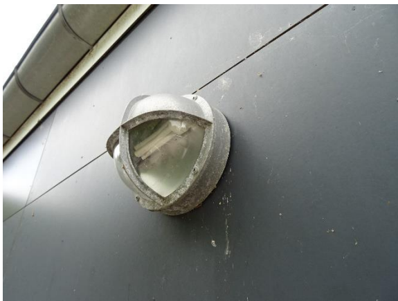
Udvendig skotlampe med lysstofrør
