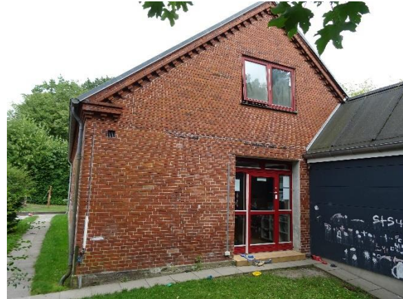
Indgangsparti fra 2004 i nordfløj, spor i murværk over efterter udhæng/bygning
