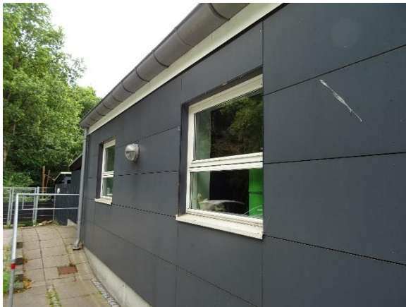
Trævinduer fra 2008 mod øst
