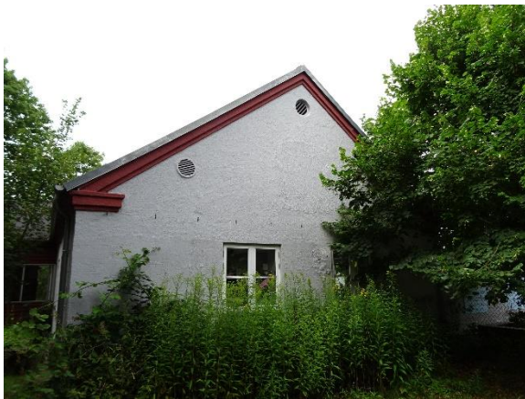
Gavlvinduer med termoruder fra 1996
