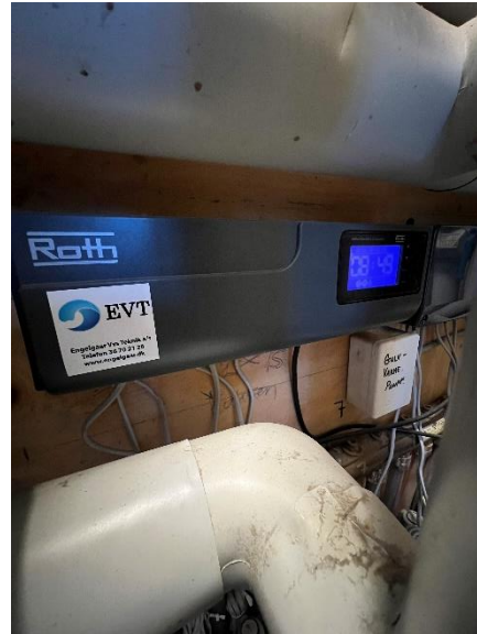
Roth gulvvarme styring
