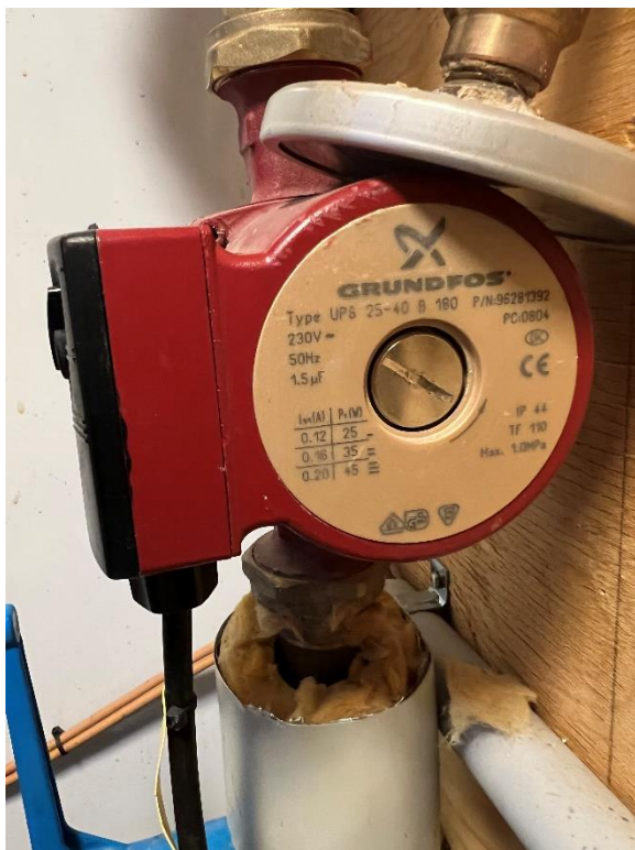
Brugsvand cirkulationspumpe fra 2008
