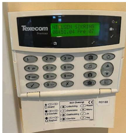
Kodetastatur for indbrudsalarm
