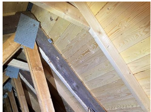
Ny tagkonstruktion med fast undertag på vestfløj
