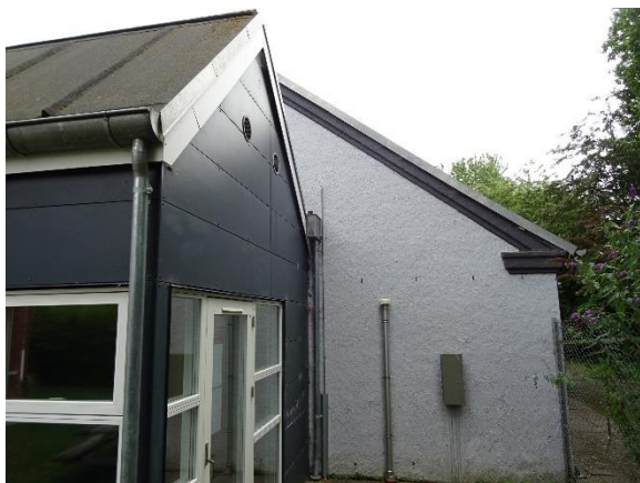
Faldstammeudluftning, nordvestgavl
