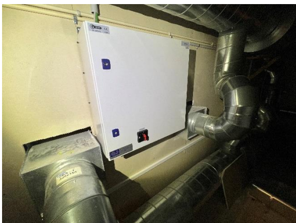
GSM Modul og pumpestyring
