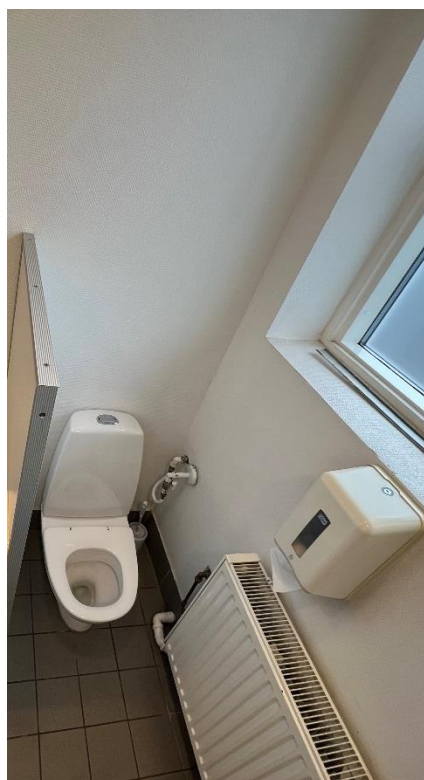
Varmerør ført i væg
