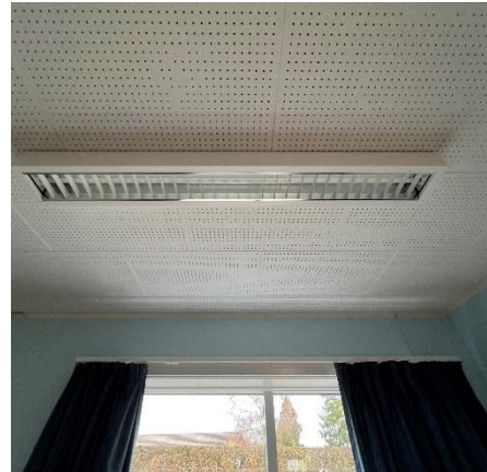
Perforeret gipsplade loft. Huller delvist malet over.
