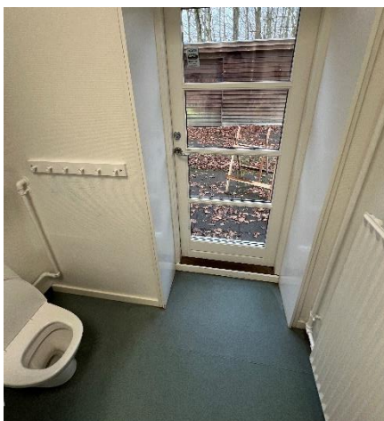
Gipsvægge med filt og vinyl på toilet
