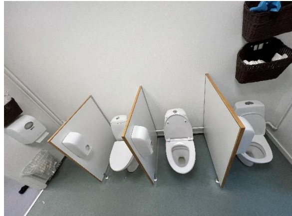
Forsyning bag toiletter i galvaniseret stål
