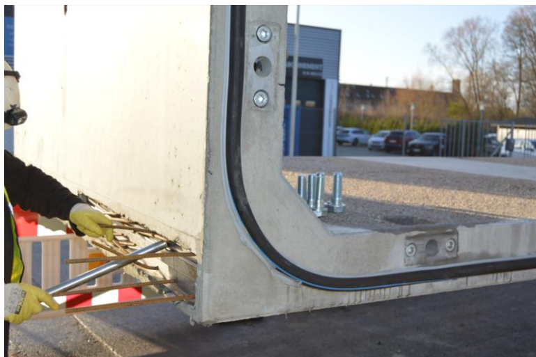
Fig 5 Hjørne af U element med gummipakning og bolteforankring. Armering for udstøbning af fod til opdriftssikring.
