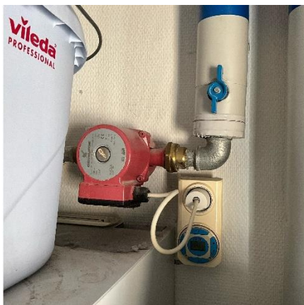
Cirkulationspumpe
