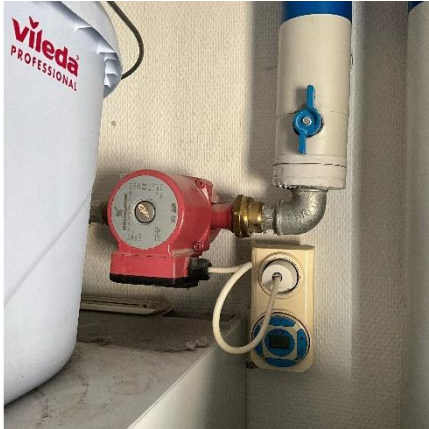
Cirkulationspumpe
