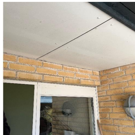
Fibercement plader ved overdækket halvtag
