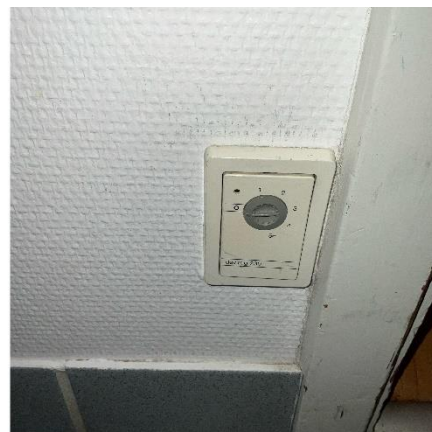
Gulvvarme termostat
