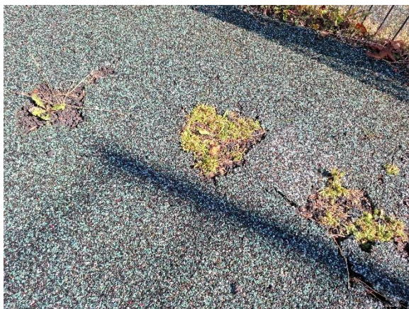
Bevoksning i hullet gummi-asfaltbelægning på boldbane.
