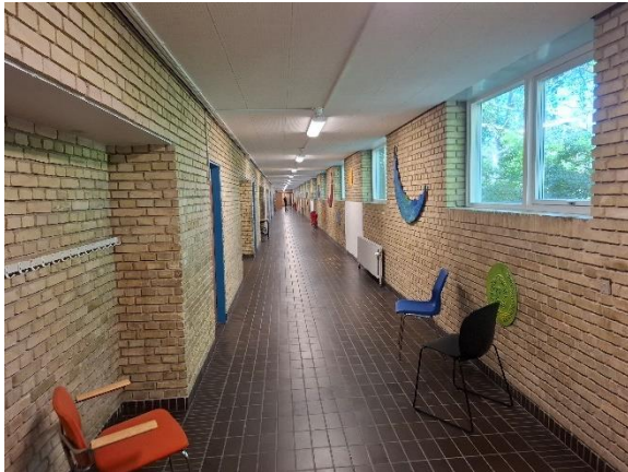
Overflader i gangarealer.
