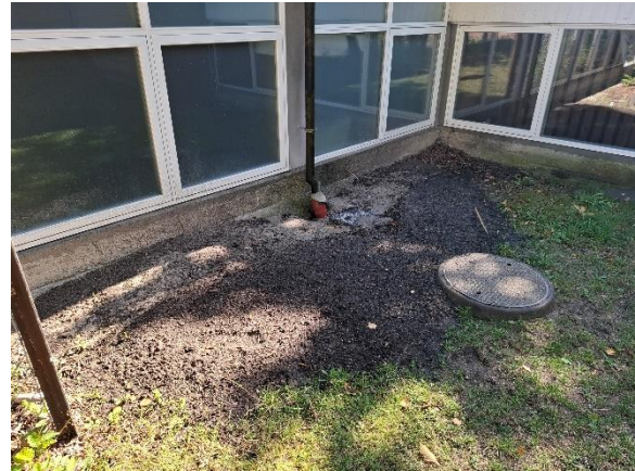
Taggedløb med renoveret brønd.
