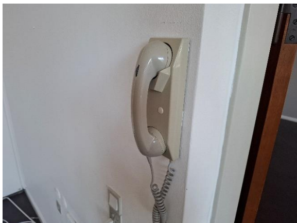
Ældre kaldeanlæg er ifølge driften fuldt funktionsdygtigt
