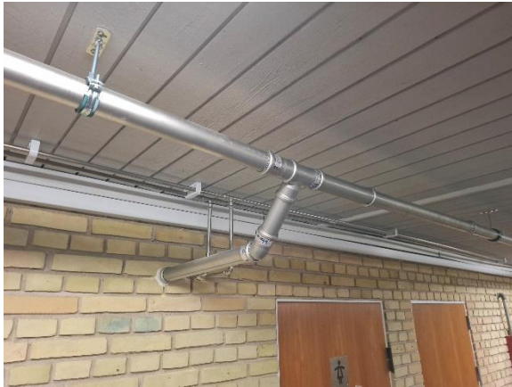
Nyere afløbsrør i kælder
