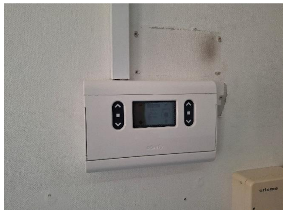
Styringspanel til solafskærmning
