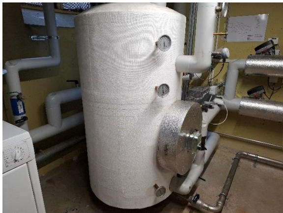
Varmtvandsbeholder
