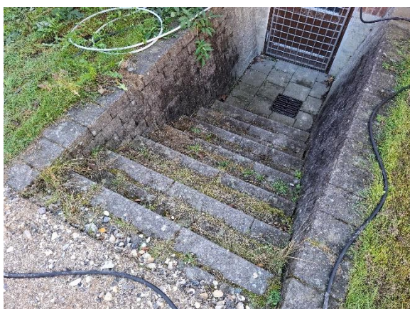
Trappe til kælder i FGU-salen
