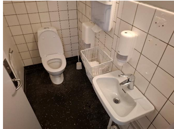
Toiletrum i vestfløj
