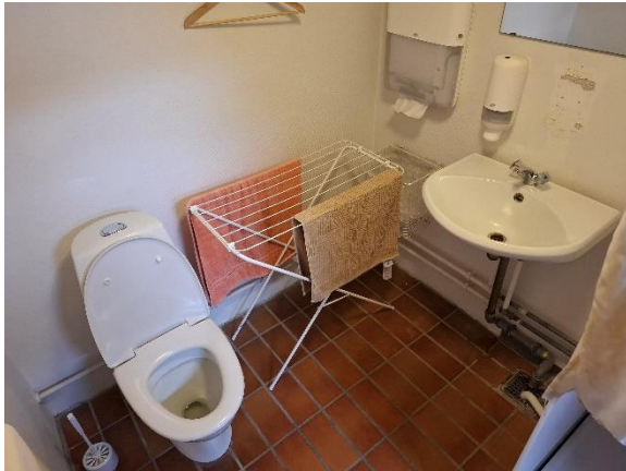
Toiletrum i kælder nordfløj
