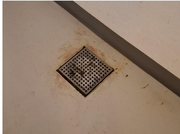
Oprindeligt gulv afløb i kælder
