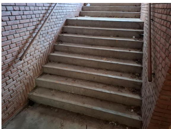
Trappe til kælder i nordfløj
