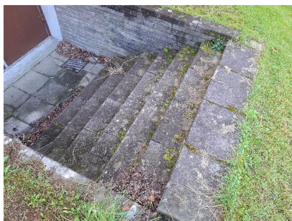
Trappe til kælder i gymnastiksalen
