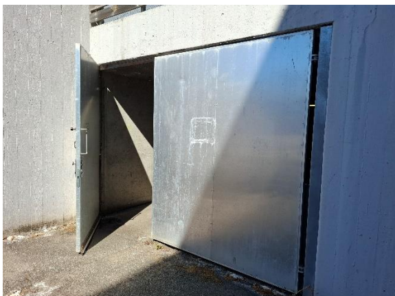
Port til affaldsrum
