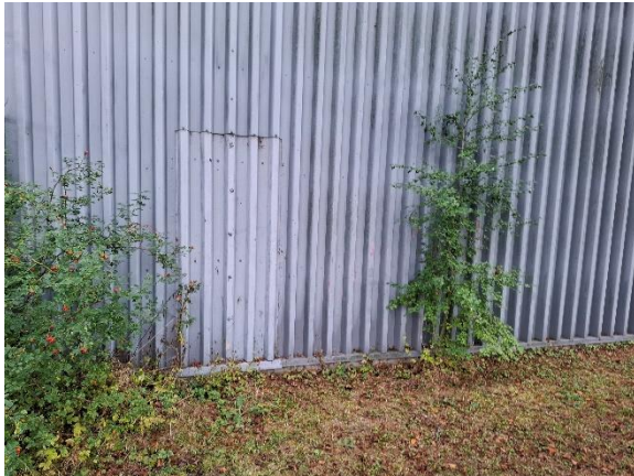
Facade på sportshal med lukning af dør hul
