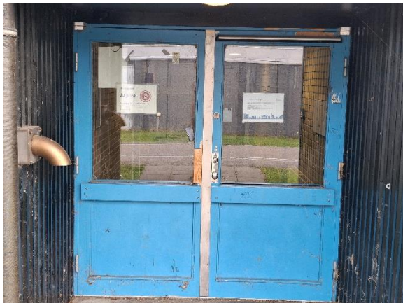
Adgangsdør til sportshal
