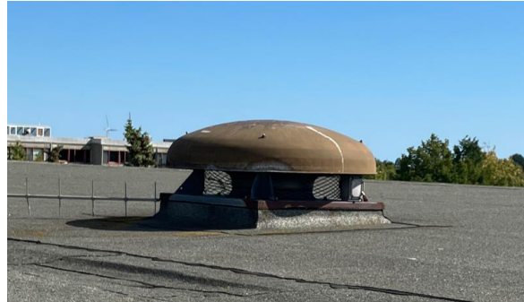
Tagventilator udsugning, alder ukendt men formentligt fra opførselsåret 1973
