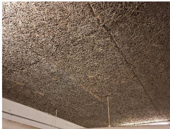
Dæk over lukket men uopvarmet cykel kælder
