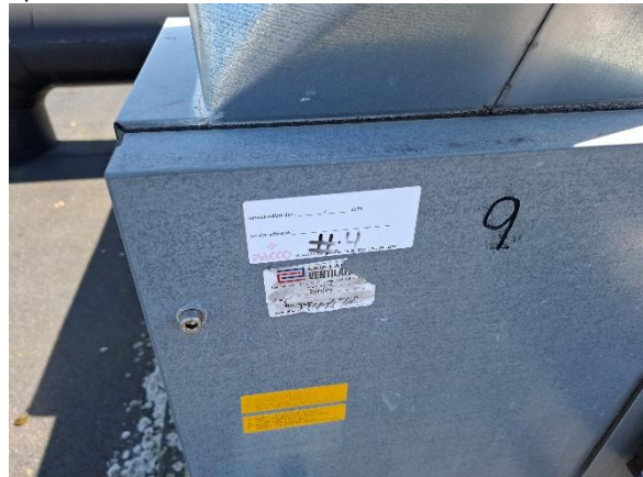
Tagventilator udsugning, alder ukendt men formentligt fra opførselsåret 1973
