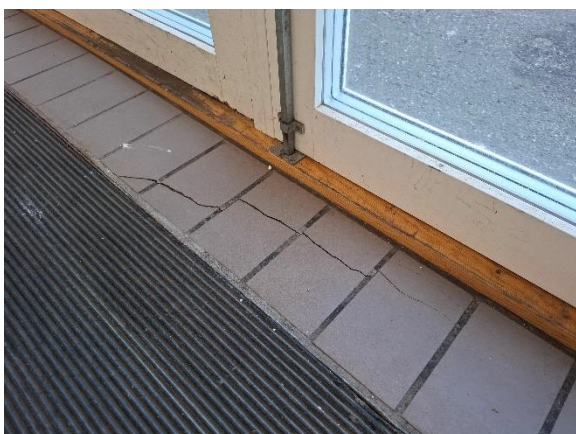
Revnet flisebelægning mod dør til udearealer
