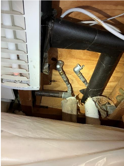
Automatisk udluftere fungerer kun hvis de er korrekt installeret
