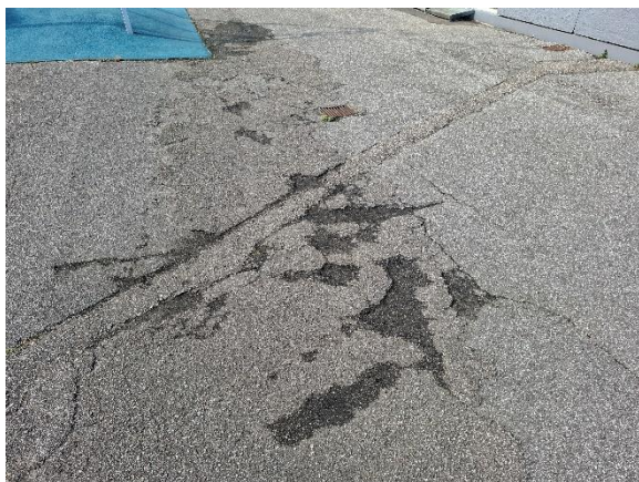
Asfaltbelægning syd for skolen.
