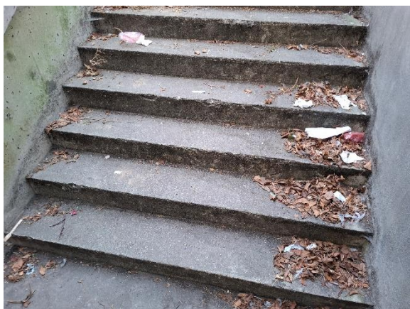
Udvendig trappe til kælder
