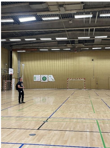
Belysning i hal sektion. Udskiftet til LED
