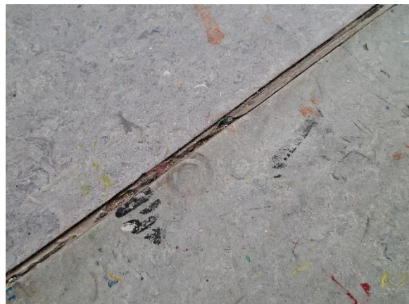
Svejsefuge i billedkunstlokkale i stueetage
