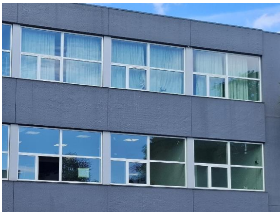
Vinduer i facade, skolen
