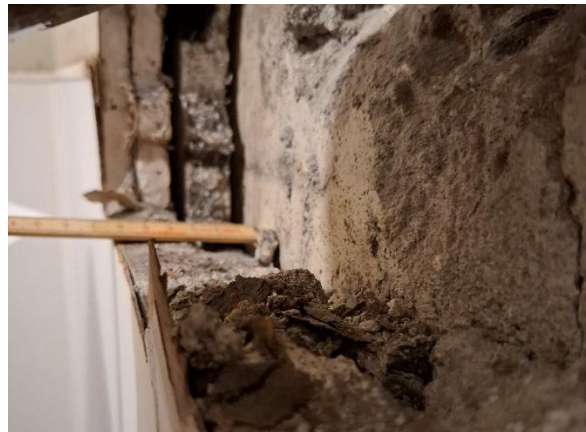
Indvendig isolering, ca. 50 mm i rengøringsrum.
