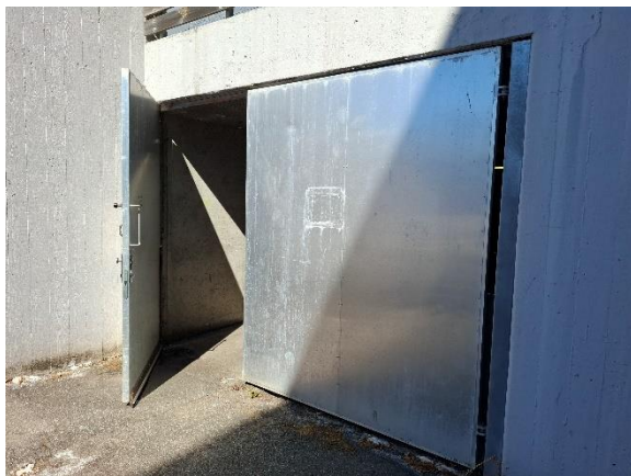
Port til affaldsrum
