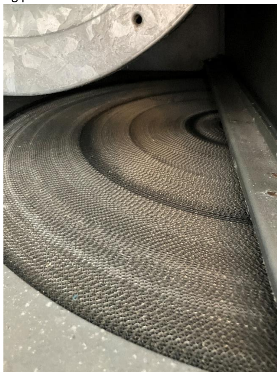
Rotorveksler tilstand vurderes fin.
