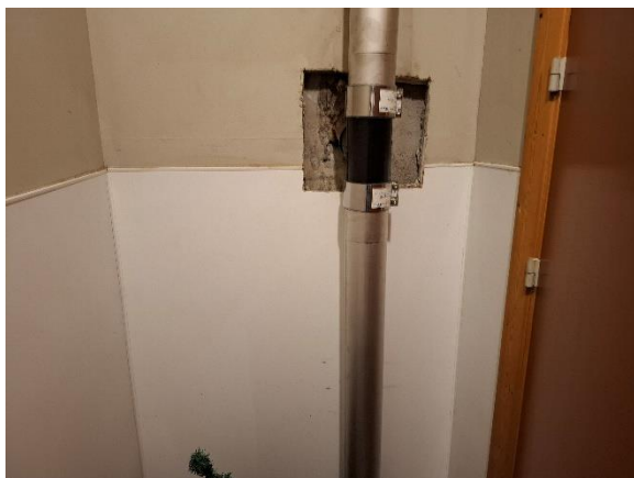
Rørdele der er udskiftet
