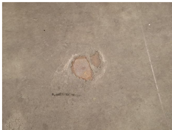
Linoleumsgulv i bygning Rød.
