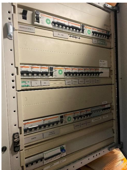
Hovedtavlens installationsgrupper
