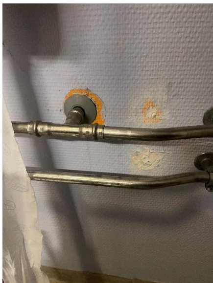
Vandrør ved bad i personaletoilet
