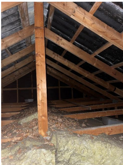
Tagkonstruktionen set fra loftrum
