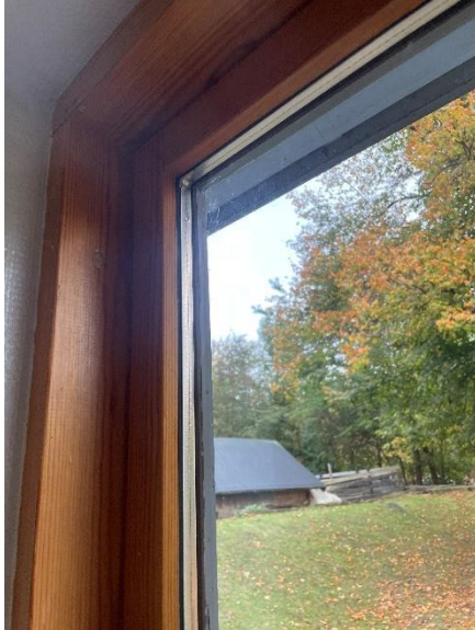
Termorude fra den oprindelige del af bygningen
