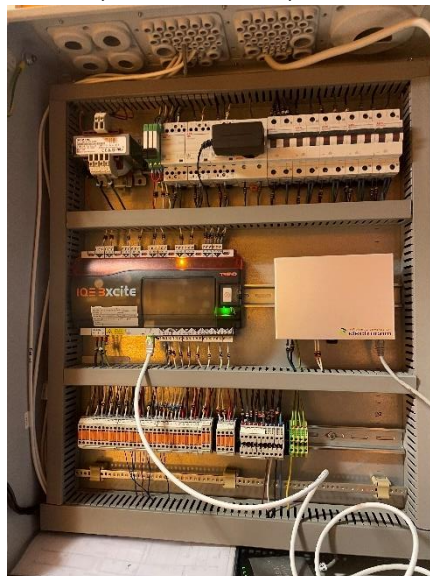
Forældet CTS-styring til varmecentral
