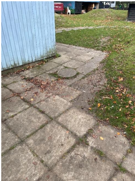
Kloakdæksel på vestsiden af bygningen
