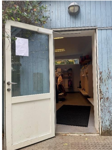
Udvendige trædør ved tilbygningen med energirude med varm kant.
