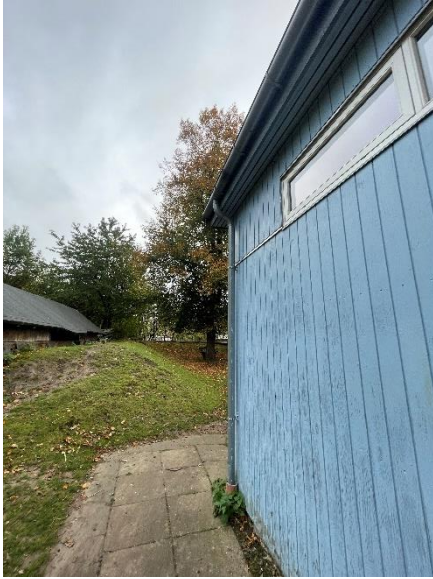
Facadebeklædning på tilbygning
