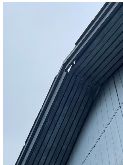
Hul i tag og underside udhæng
