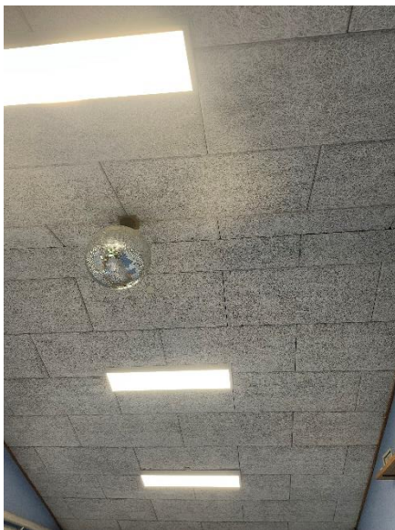
Troldtekt loft i den oprindelige bygning
