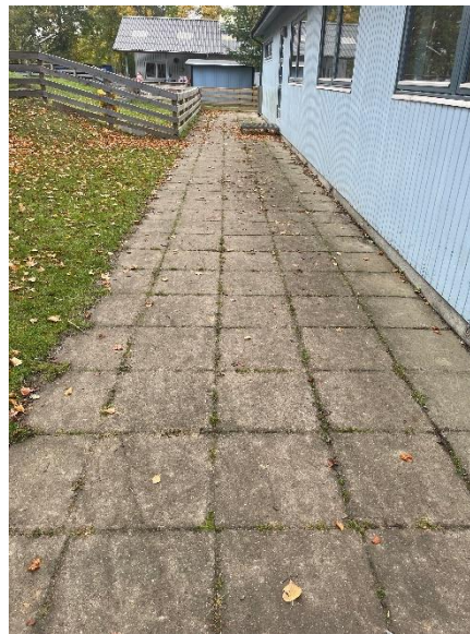
Belægning ude ved nordfacaden
