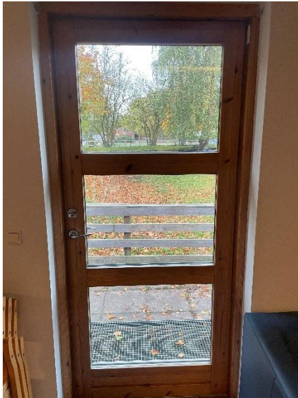
Udvendig trædør med flere rudet i den østlige endegavl af bygningen. Døren har energiruder med kold kant
