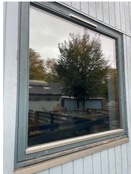
Vindue med træramme med termorude
