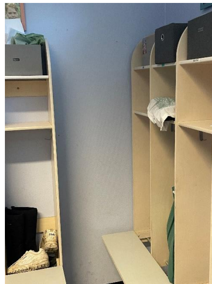
Malet gipsvæg i tilbygning som bruges til garderobe af børn
