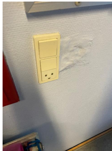
Grim reparation af gipsvæg ved elinstallation i den oprindelige bygning
