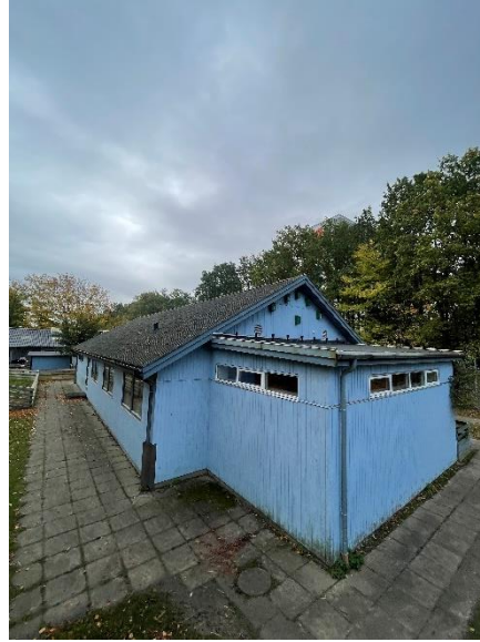
Facadebeklædning på tilbygning
