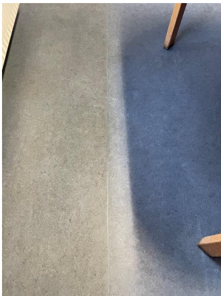
Svejsesamling på linoleumsgulv i oprindelige bygning
