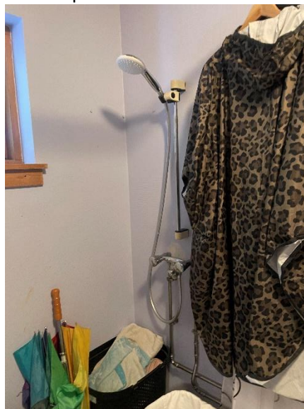
Bruser armatur i omklædning/voksent toilet
