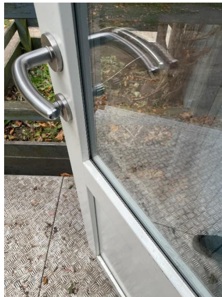
Udvendige trædør ved tilbygningen med energirude med varm.
