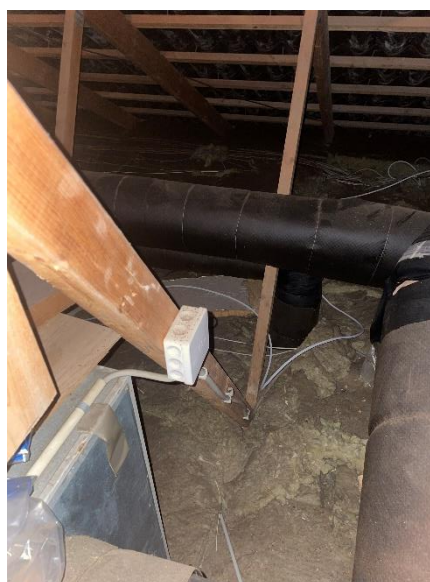
Loftisolering bag ventilationsanlæg
