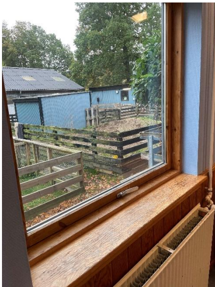
Termorude fra den oprindelige del af bygningen
