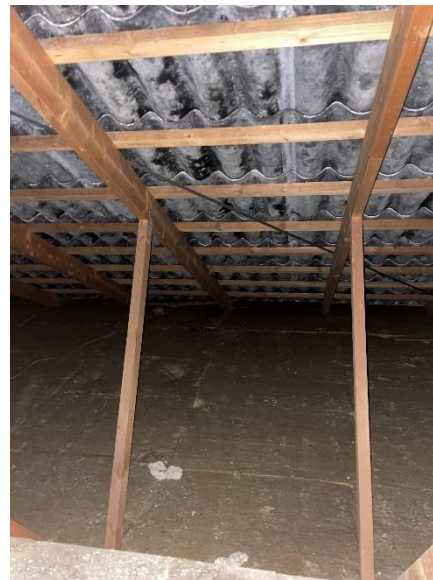
Tagkonstruktionen set fra loftrum
