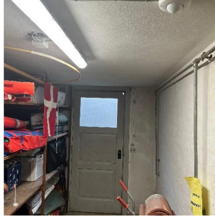
Kælderdør med etlag glas
