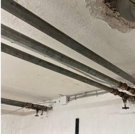
Uisolerede brugsvandsrør
