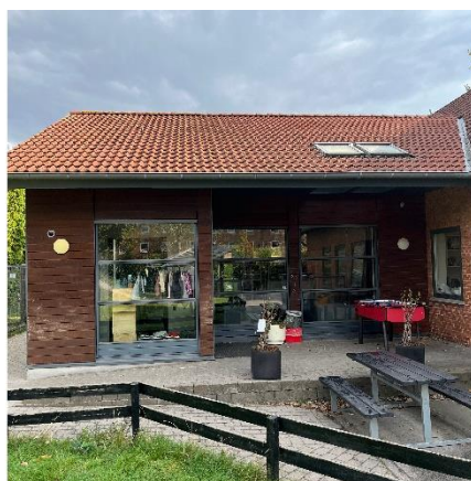
Vinduespartier i tilbygning
