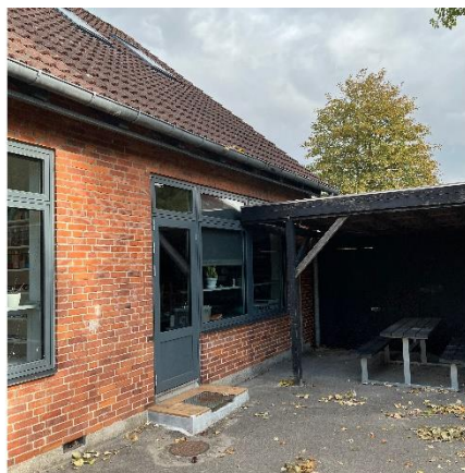
Facadepartier med glasdøre og trelags energiruder
