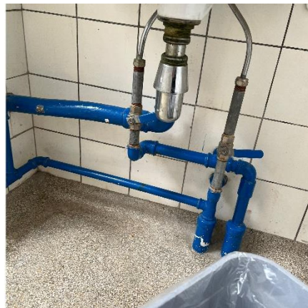
Terrazzogulv på toilet 1. sal
