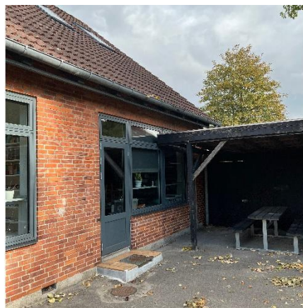
Facadepartier med glasdøre og trelags energiruder
