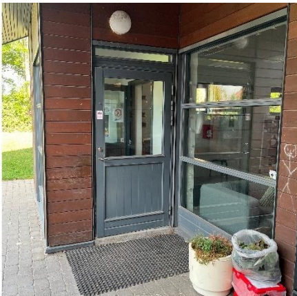
Yderdør i tilbygning
