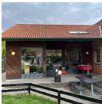
Vinduespartier i tilbygning
