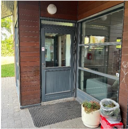
Yderdør i tilbygning
