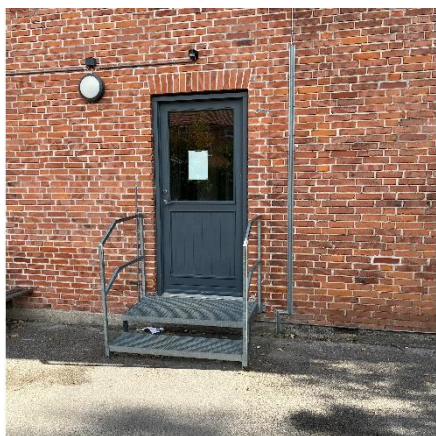
Yderdør i gavl
