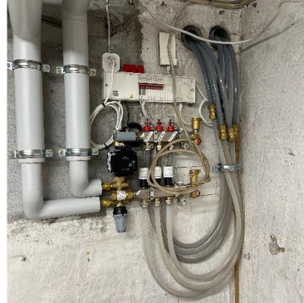
Gulvvarme installation – tilbygning
