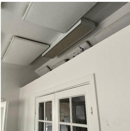
Ældre lysstofrør m. konventionelle forkoblinger
