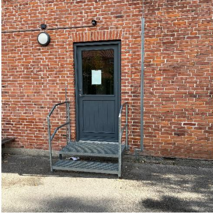
Yderdør i gavl
