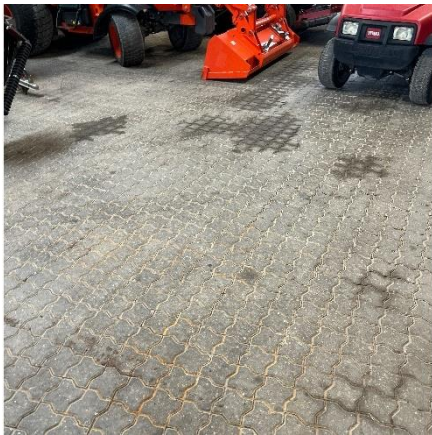
Stenbelægning i hal, greenkeepergård
