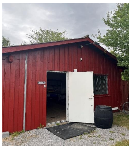
Sikringsdøre til udhus
