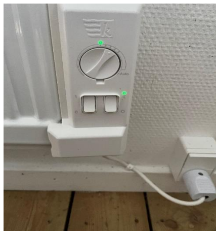
El-radiator i udhus med automatisk drift og aktiv natsenkning
