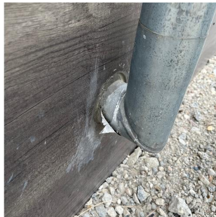
Nedløb ført gennem facade
