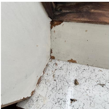
Afskallet maling, tegn på vandskader og muligvis råd i træ til lysninger for ovenlys i sekretariat
