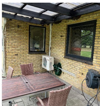
Luft/luft varmepumpe delvist til 1. sal i sekretariat (ikke i brug)
