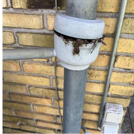
Tilstoppet nedløbsrør
