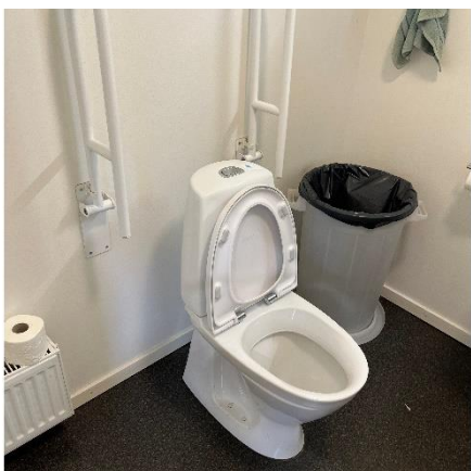
Toilet med to-skyl, greenkeepergård
