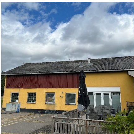
Fibercement konstruktion
