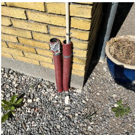
PE-trækrør ført over jord i SØ-gavl til sekretariat
