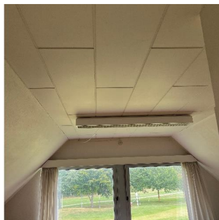
Belysning på 1. sal med ældre T8 rør m. konventionelle forkoblinger, sekretariat
