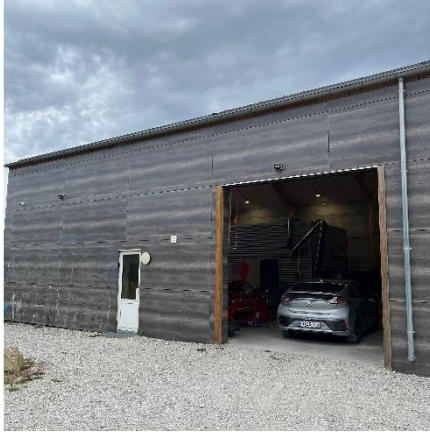
Dør til værksted i greenkeepergård
