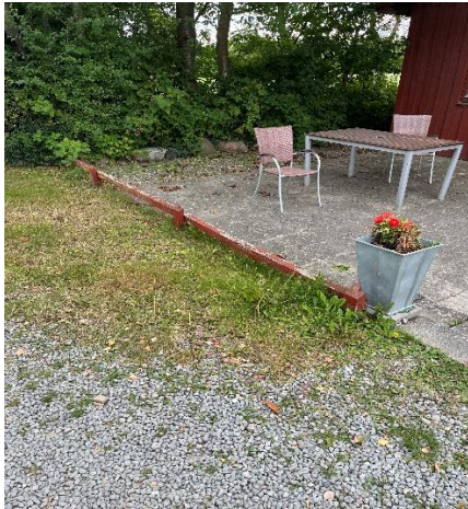
Manglende malervedligehold af rækværk til udhus
