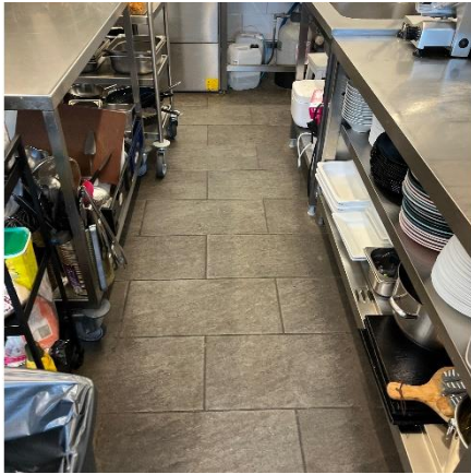
Klinkegulv i køkken
