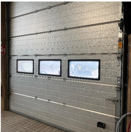
Hejseport til værksted for greenkeepergård
