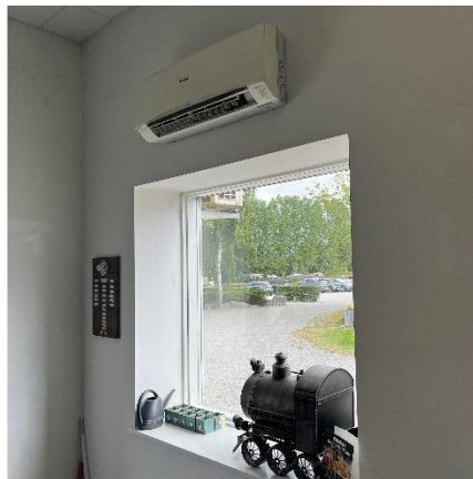
Luft/luft varmepumpe i café
