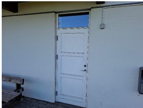
Dør mod nord til omklædning
