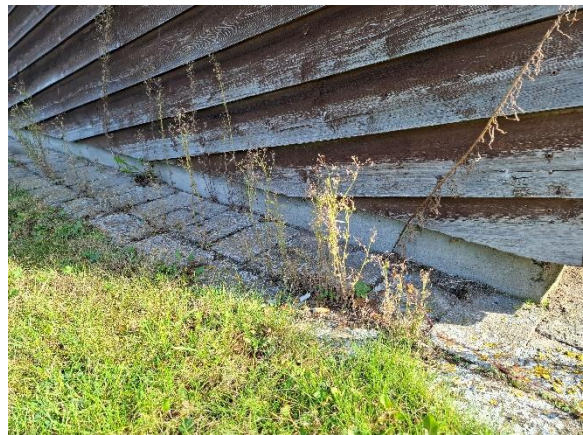
Bevoksning mellem flisefuger mod sokkel.
