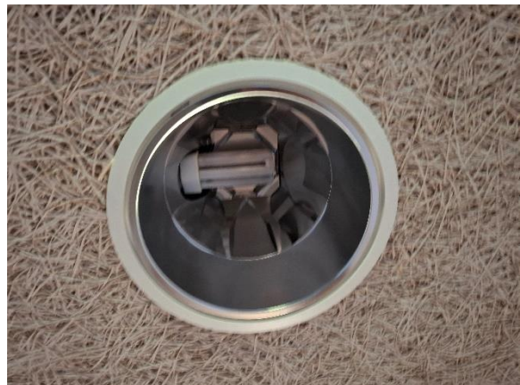
Armatur med kompaktrør.
