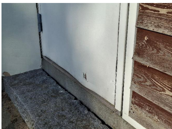
Dørblad i karnap mod øst er opfugtet i bunden.
