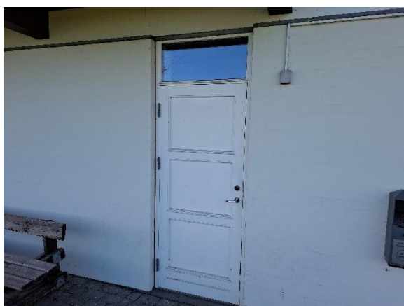
Dør mod nord til omklædning
