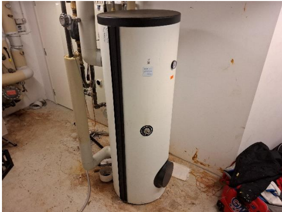
Varmtvandsbeholder
