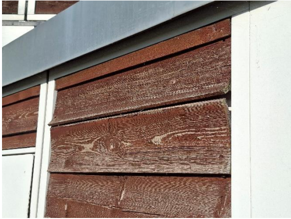
Løstsiddende klinkbeklædning mod øst
