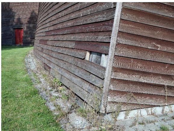
Et bræt er brækket af på hjørne mod sydøst
