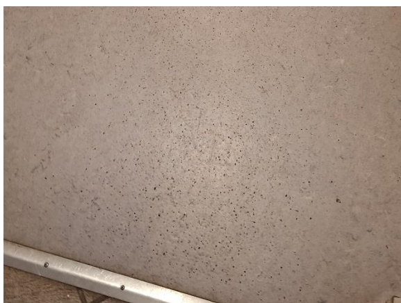
Linoleum er generelt med mange små huller, der formodes at være resultat af anvendelse af sko med pigge.
