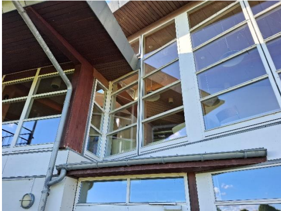
Vinduer og vinduespartier.
