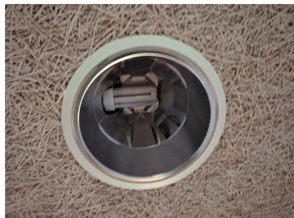
Armatur med kompaktrør.
