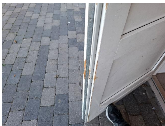
Slid på dør mod nord til omklædningsrum.
