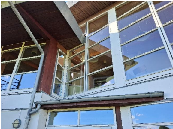
Vinduer og vinduespartier.
