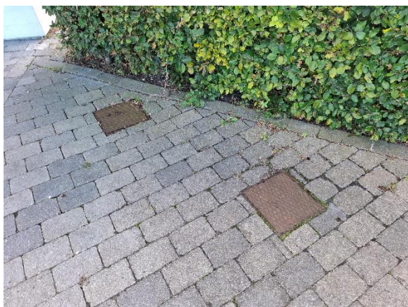
Adgangsdæksler til brønde
