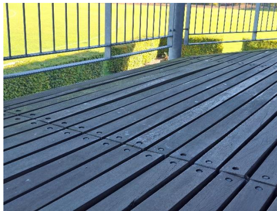
Altangang med niveauspring målt op til 20 mm.
