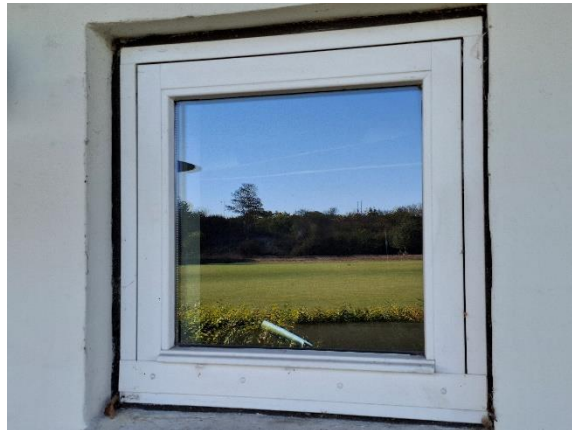
Vindue mod nord
