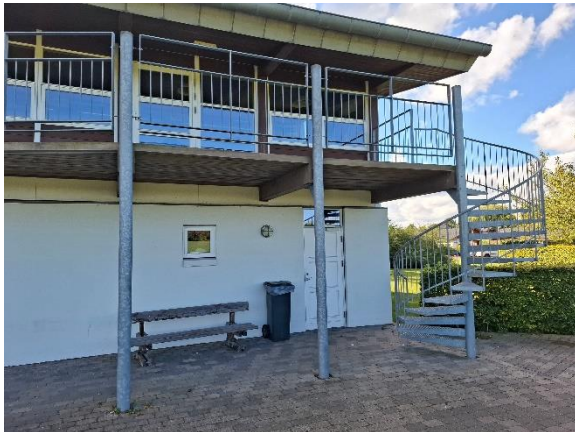
Udvendig trappe til altan med gelænder
