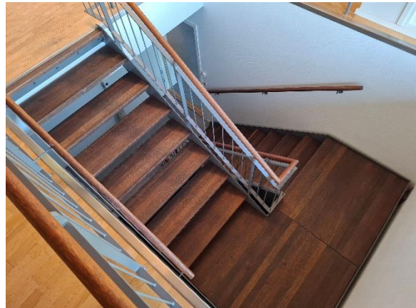
Indvendige trapper udført i stål og hårdttræ
