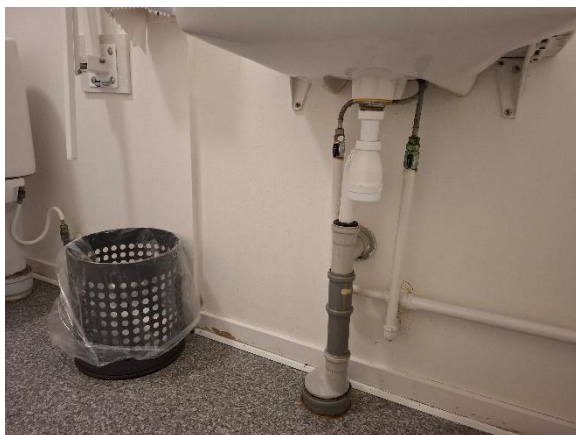
Rørføring under håndvask
