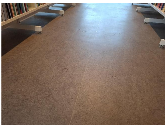
Enkelte mærker efter reoler ses i nyere linoleumsgulvflader
