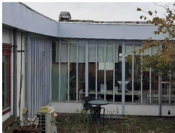
Vinduer mod gård.
