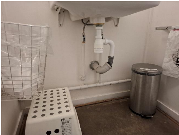
Afløbsrør under håndvask i toiletrum.
