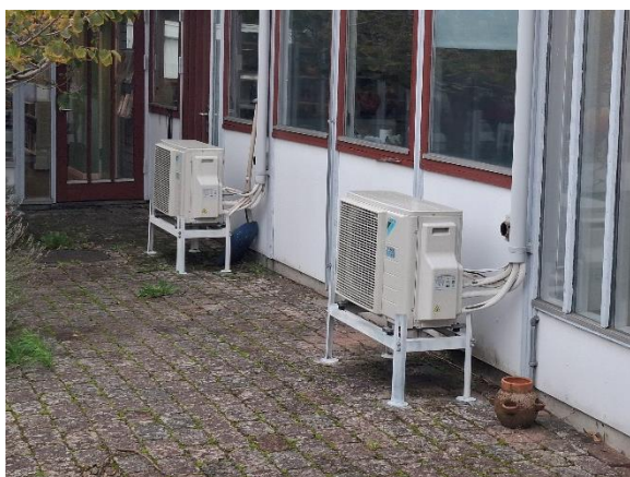
Varmepumper – ude dele i gård.
