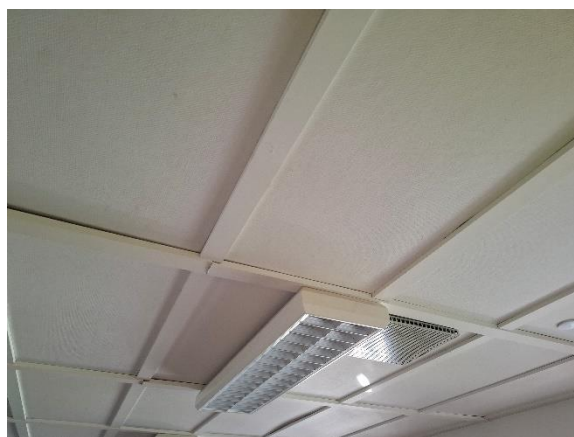
Ældre træloft i oprindelig bygning
