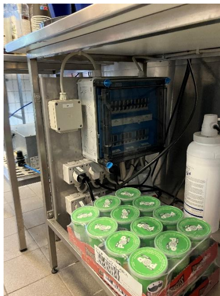
Fordelingstavle monteret i løst stående bordstel. Uvist om der er HPFI beskyttelse fra tavlen.
