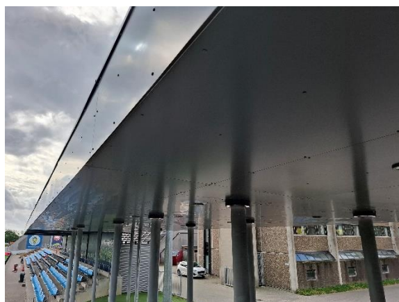
Beklædning under tagoverdækning
