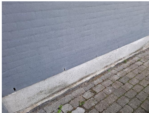
Oprindelig sokkel mod nord.
