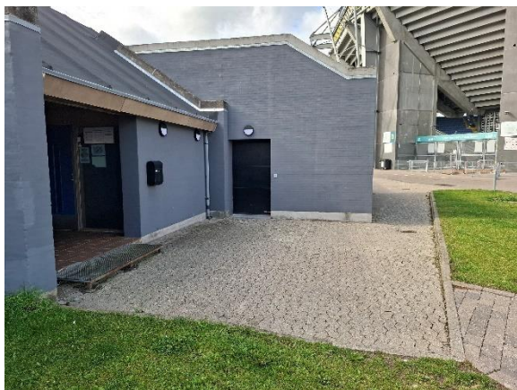
Belægning med SF-sten nord for oprindelig bygning.
