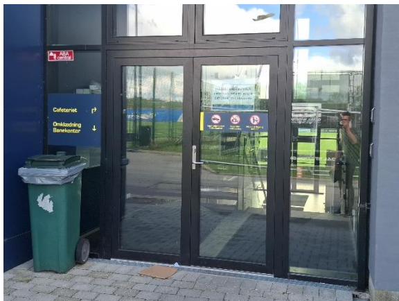
Ny dør i sammenbygning med tilbygning.
