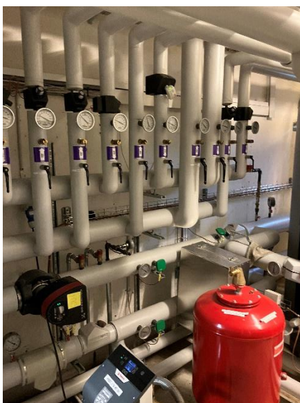
Stor opdatering af varmecentral ved omlægning til fjernvarme.
