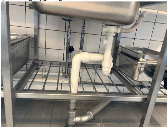
Afløb udskiftet til rustfast.
