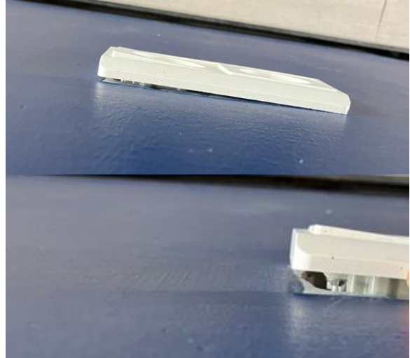
LK OPUS ramme er ikke korrekt monteret
