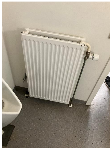
Rør udskiftet. Vidner om generel rørtilstand af ejendom.
