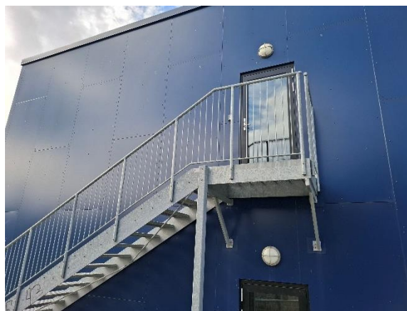
Udvendig trappe tilbygning
