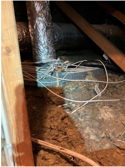
"Fuglereder" i samledåser flere steder på loft
