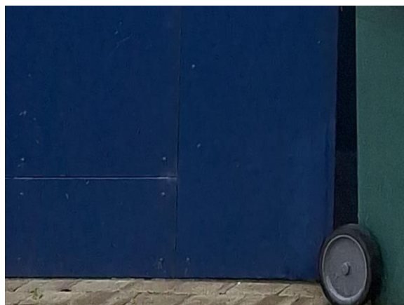
Sokkel ved ny omklædningsfløj
