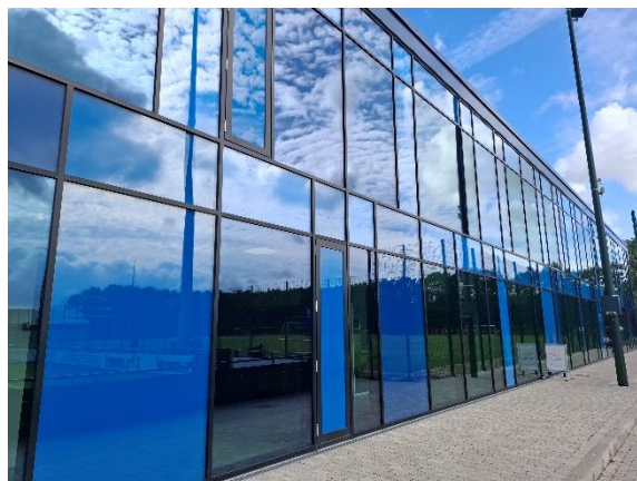
Glasfacade på tilbygning TB3
