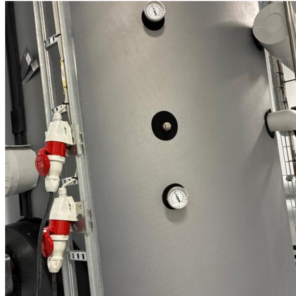
Varmtvandsbeholder tilbygning
