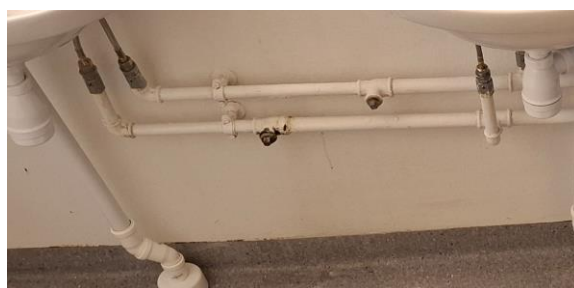
Enkelte steder er der erstattet med rustfri installation og pressfit ved renovering.
