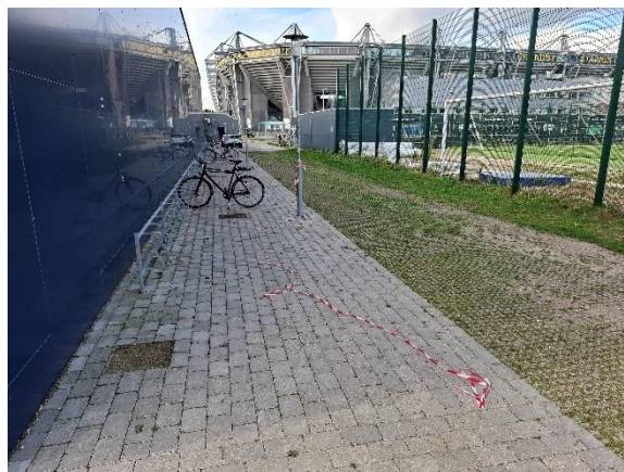
Belægning med herregårdssten og græsarmingssten i beton omkring tilbygning TB3.
