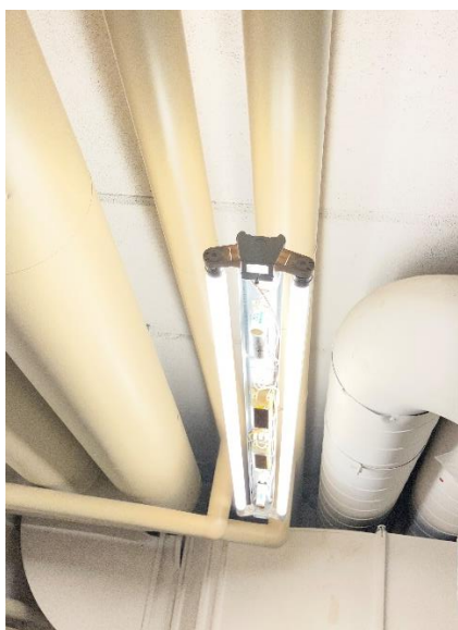
Armatør uden indkapsling og blottede ledende dele.
