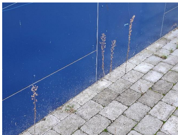
Sokkel på tilbygning
