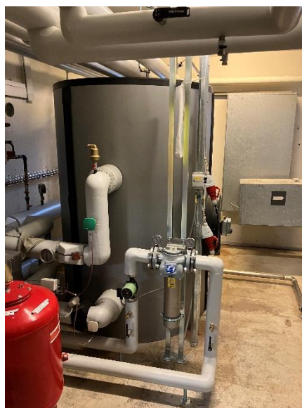
Varmtvandsbeholder
