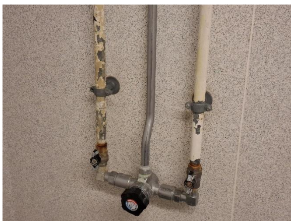
Maling afskaller, rust/kalk/okker på tvist, Ballofix der ser slidte ud.
