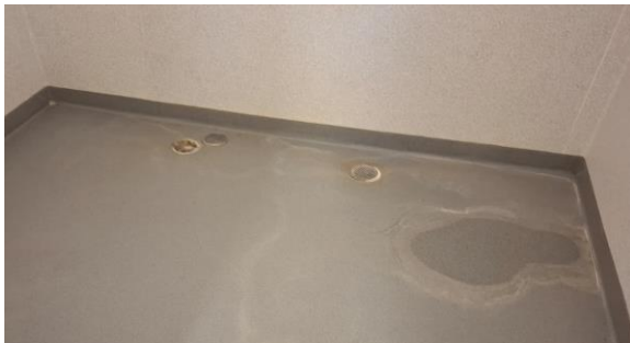
Kondensafløb i tilstødende rum der heller ikke fungerer og uden afløb i rummet samles der vand på gulvet.
