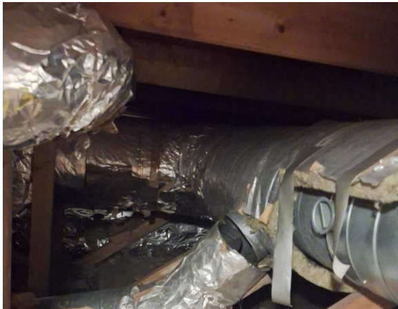
Isoleret ventilationskanaler
