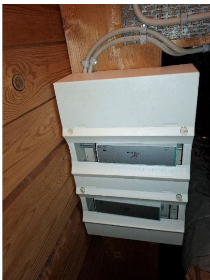
Tavle uden blænddæksler og monteret sidelæns; hvilket strider imod producentens anvisninger.
