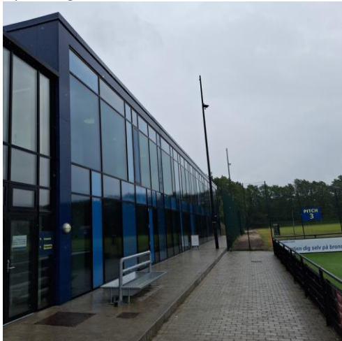
Vinduer ny omklædningsfløj
