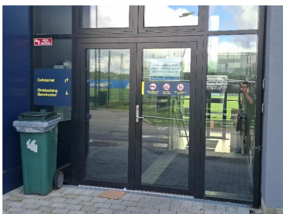
Døre i tilbygning
