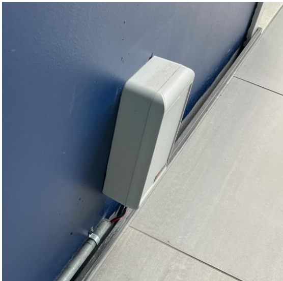
Enkeltisoleret leder blotlagt udenfor dåse. Henleder opmærksomhed på 60364: 526.5 – 526.9
