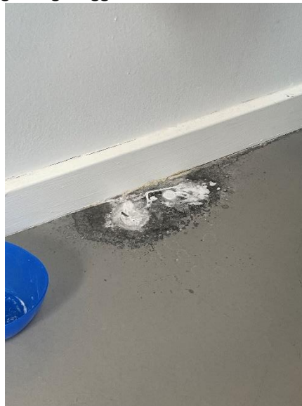
Skader på gulvet under sæbedispenser
