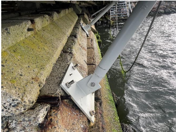
Brostøtter fastgjort til betonelementer i diget
