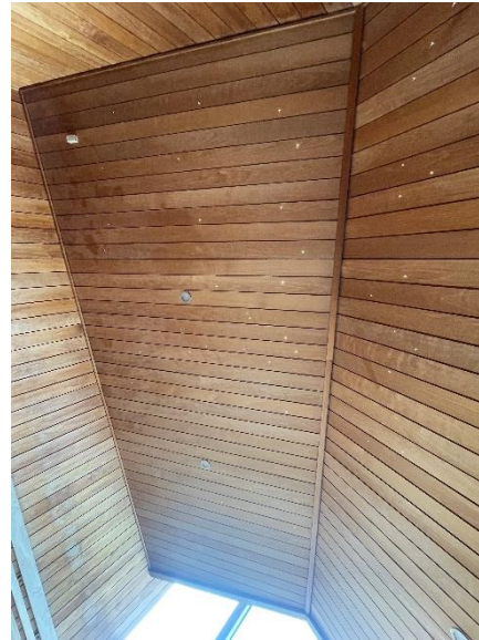
Bræddebeklædt loft i sauna med lysstjernehimmel
