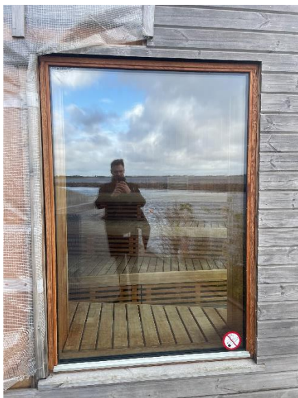
Stort vindue til sauna med rep arbejde på venstre side af facaden
