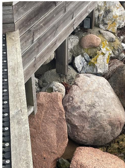
Stolper fastgjort til beton/sten
