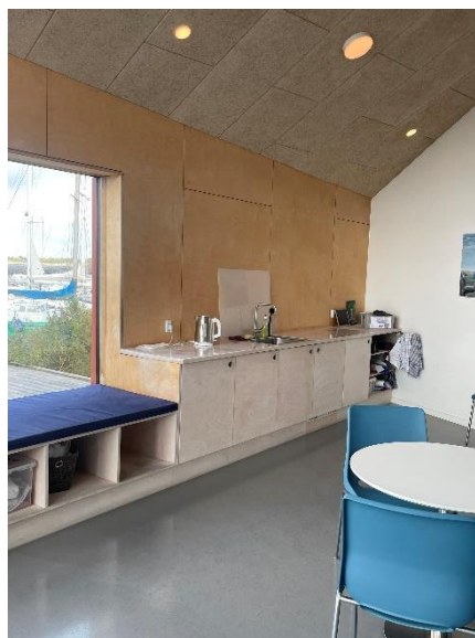
Væg beklædt med krydsfiner i fælleslokale.
