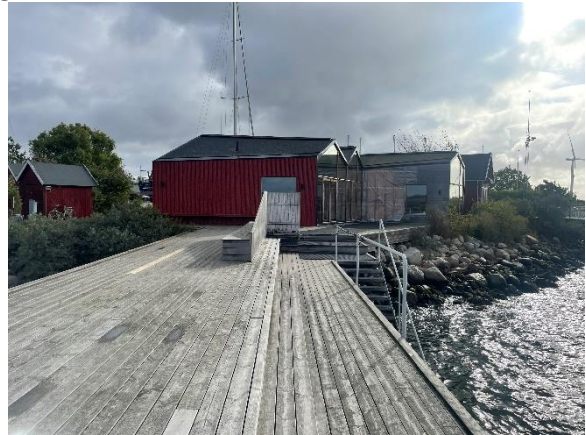
Gangbro over diget med badtrappe til højre
