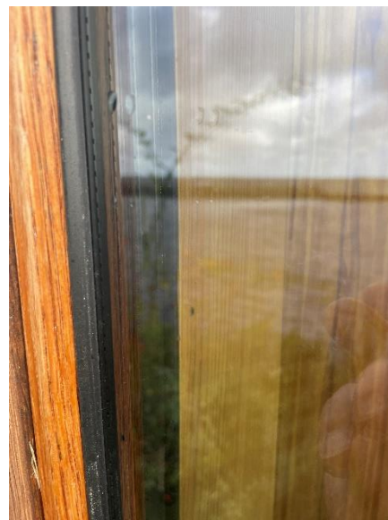
Oliebehandlet træ udvendigt, fyrtræsrammer indvendigt i natur
