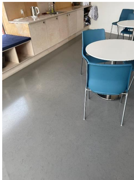
Linoleumsgulv i fælleslokale
