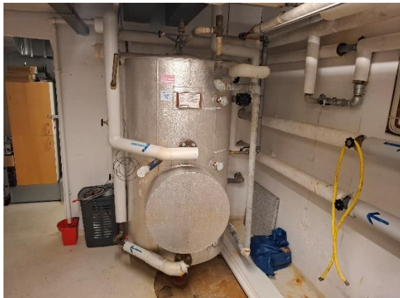
Varmtvandsbeholder
