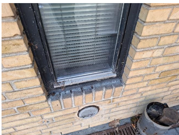
Vindue i muret væg
