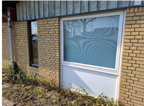
Vindue i nyere facadeparti
