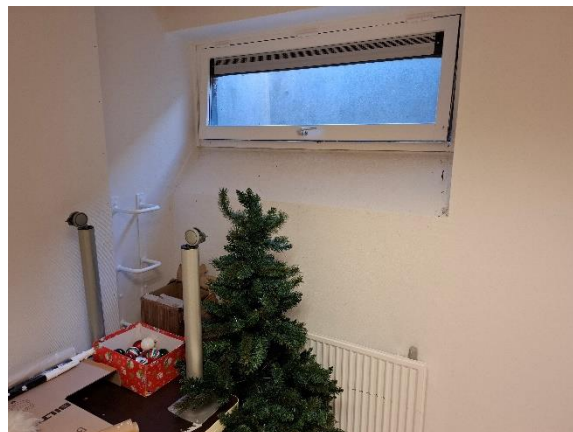
Indvendig efterisolering af kældervæg mod syd ses tv.
