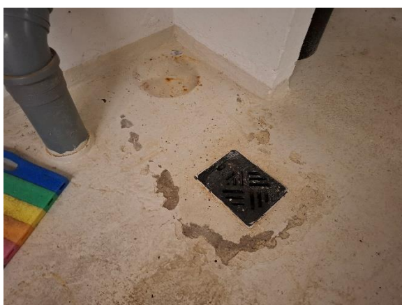
Højvandslukke
