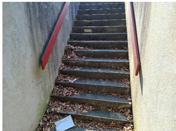
Trappe til gennemgang i gård.
