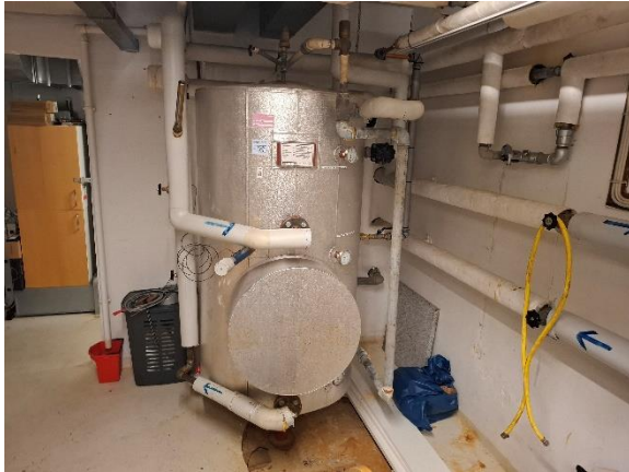
Varmtvandsbeholder
