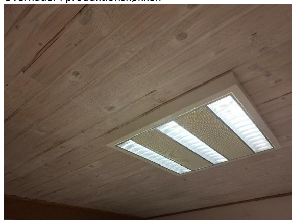
Lofter i kælder
