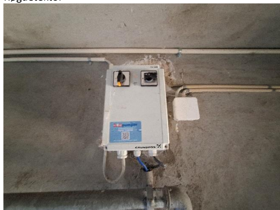
Pumpestyring i gennemgang under nordfløjen
