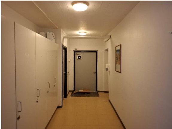
Fordelingsgang i kælder
