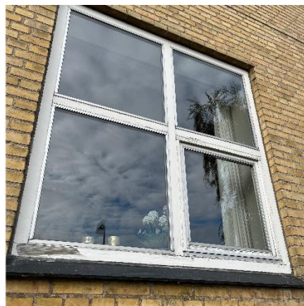
Vinduer med tolags termoruder i lille sal
