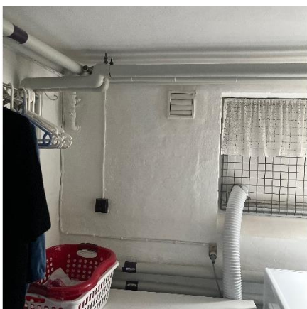
Afskallet puds langs med dørkarm til bad i kælder
