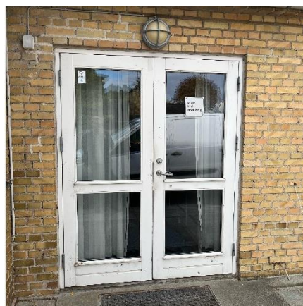
Indgang til depot
