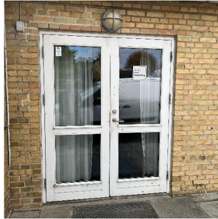
Indgang til depot
