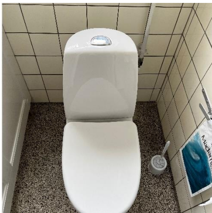
Toilet med to-skyl
