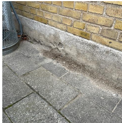
Pudset sokkel i beton
