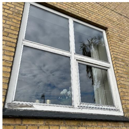
Vinduer med tolags termoruder i lille sal
