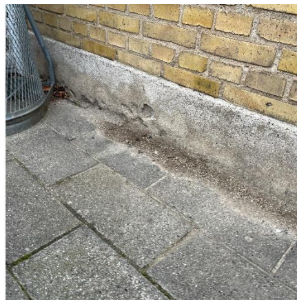
Pudset sokkel i beton
