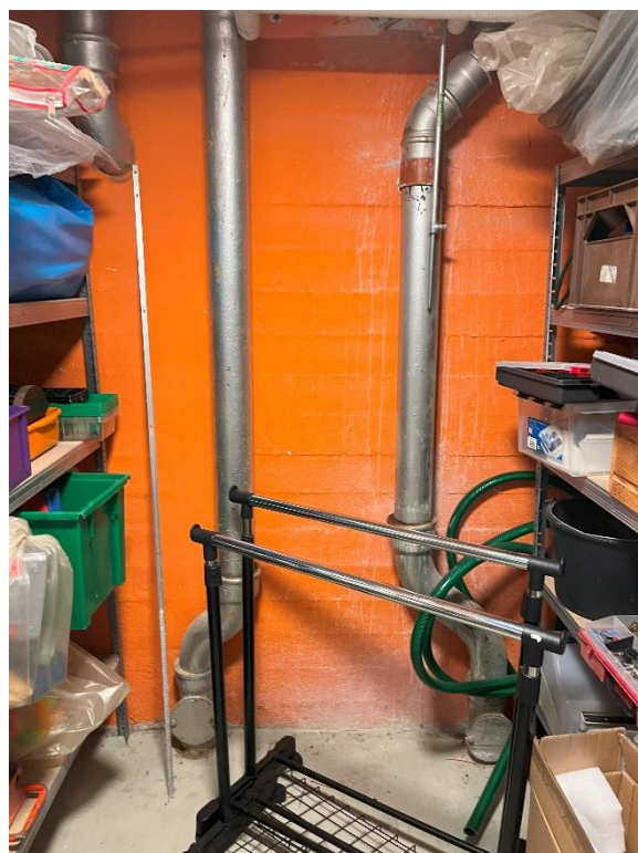
Blyholdigmaling på alle originale støbejernsrør.
