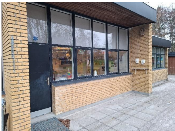
Sydvendt facade på bygning nord
