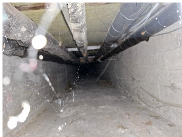
Underside af krybekælder dæk
