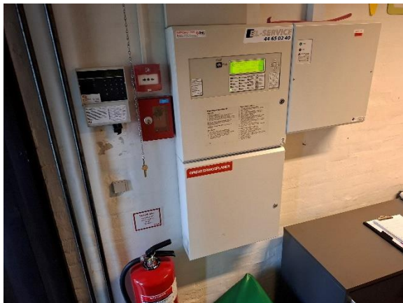
ABA-central, bygning nord
