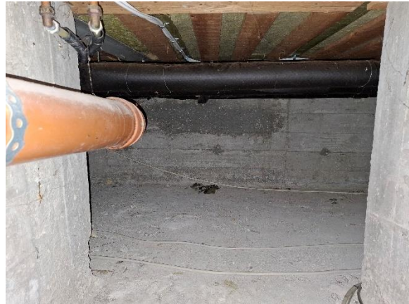
Ingeniørgang i bygning syd
