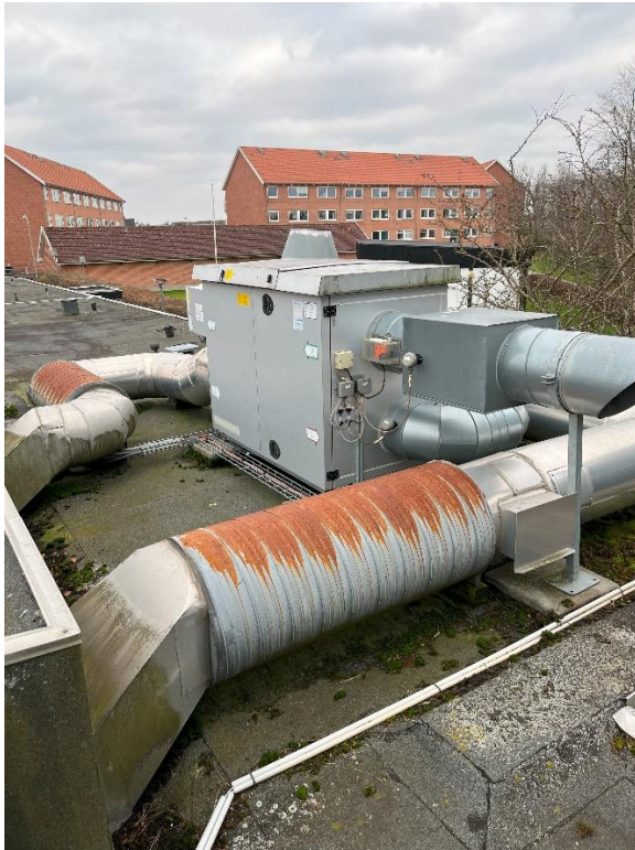
Aggregat bygning nord
