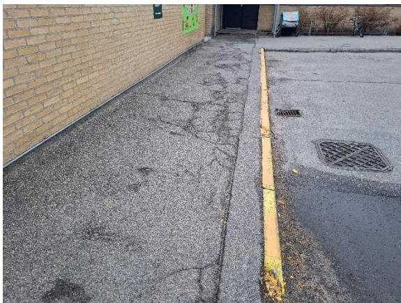
Belægninger mod parkeringsplads
