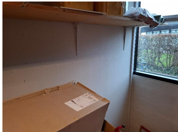
Malede vægflader i bygning nord
