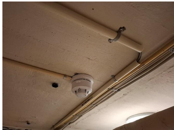
Røgalarm koblet på ABA
