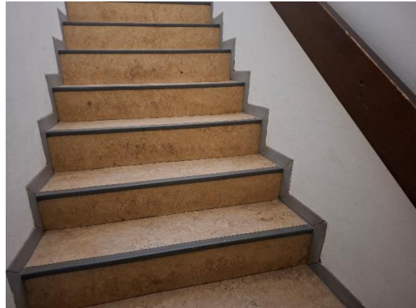
Bygning nord, trappe til kælder
