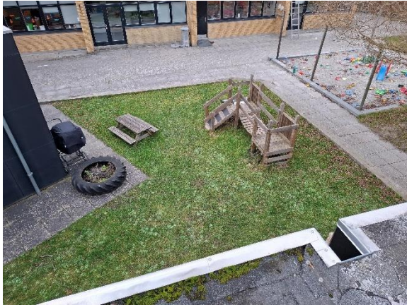
Belægninger ved bygning nord
