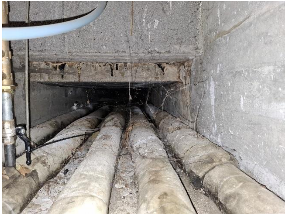
Ingeniørgang i bygning syd
