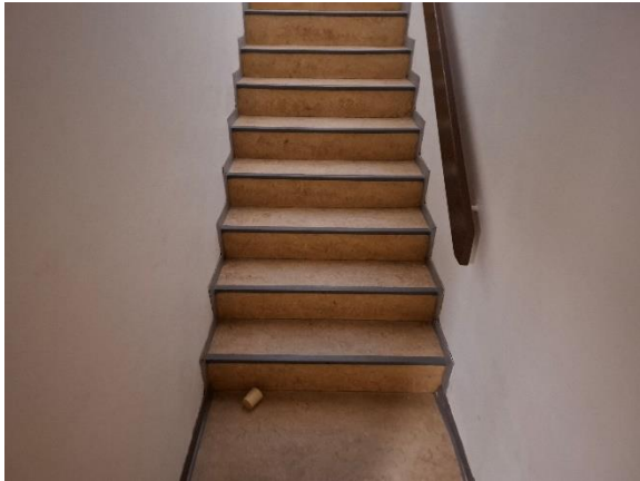
Bygning nord, trappe til kælder
