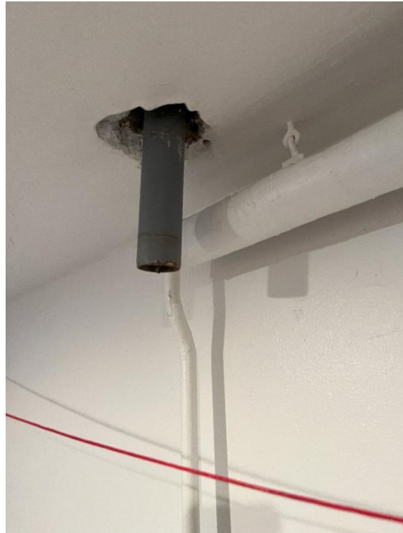
Skal fjernes fra etagedæk og udstøbes.
