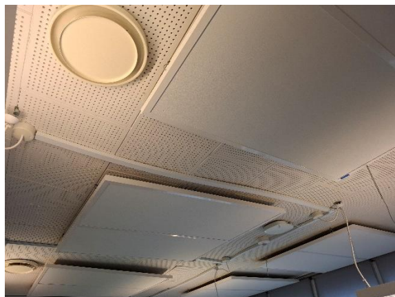
Akustikgipslofter med nedhængte akustikplader.
