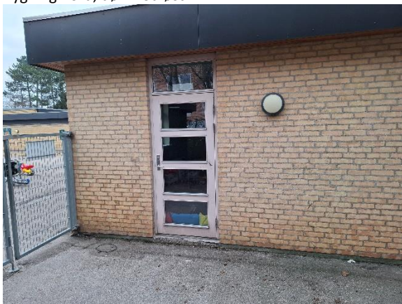
Bygning syd, dør mod vest
