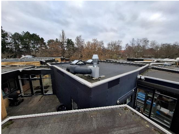
Tagflader på mellembygningen
