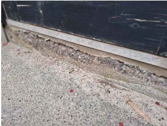
Afslag på sokkel bygning syd
