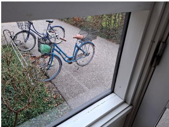
Vinduer med 1-lags glas vindfang bygning nord
