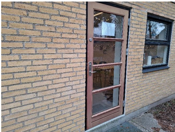
Bygning nord, dør mod øst
