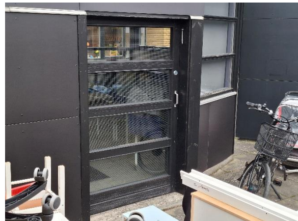
Bygning nord, skydedør til barnevognsrum
