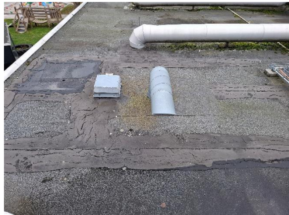
Lapninger ved hovedindgangen på den sydvendte bygning.
