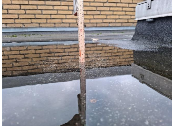
Lunken måler 20 mm på dybeste sted.
