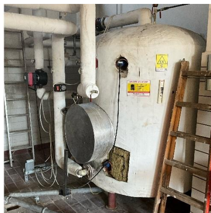
Varmtvandsbeholder
