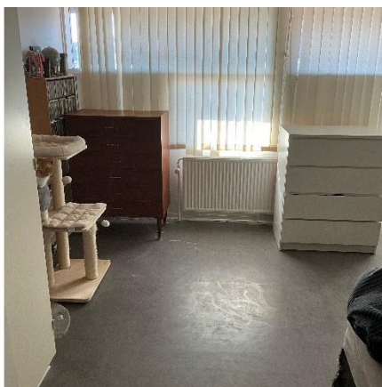
Linoleumsgulv i stue og opholdsrum
