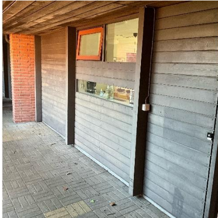
Vinduesfacade mod gangareal
