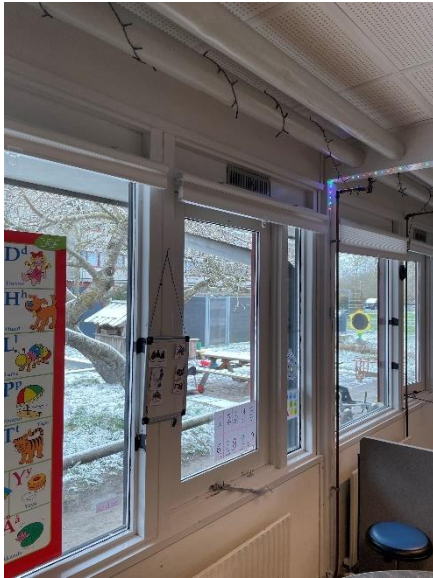
Vinduer ud mod legeplads
