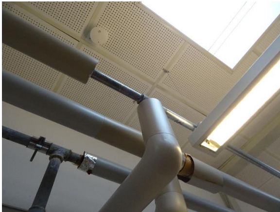
Reparationer og afisolering efter tæringer
