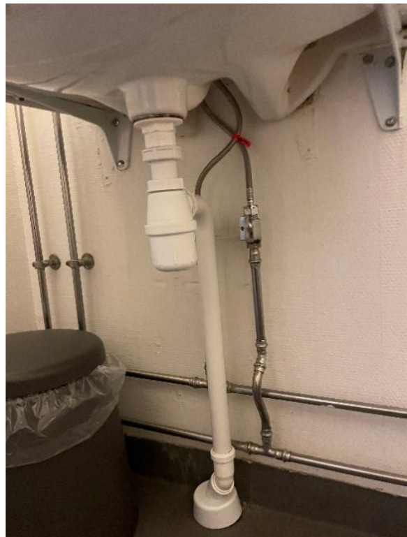
Ventiler og haner i rustfrit stål hvor rør ikke er skiftet
