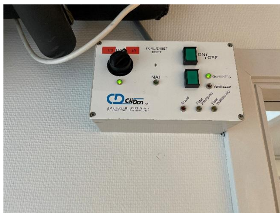
Ventilationsstyring 15-20 år gammel
