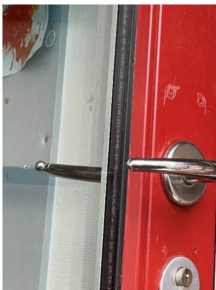
Tekst på energirude i udvendig dør
