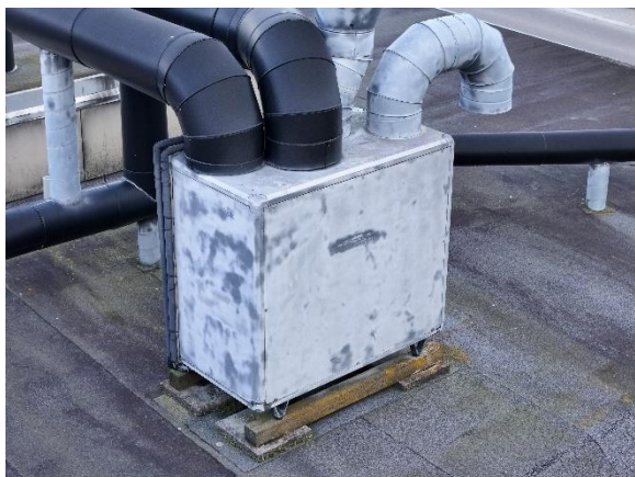
Ventilationsaggregat på tag
