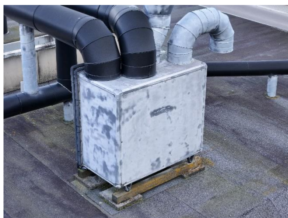
varmeblase til vent
