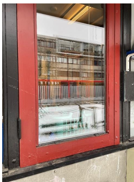
Malet vinduesramme ud mod legeplads
