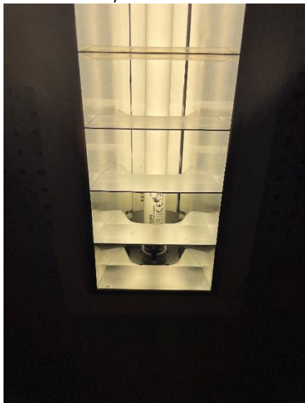
Eksempel på belysningsrør halo 28W
