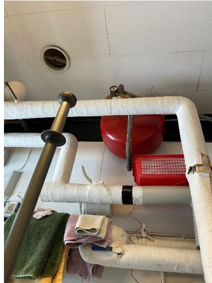
Rør med gammel lamelmåtte på
