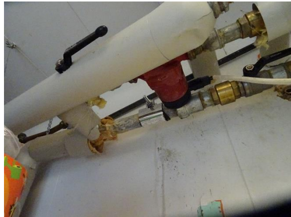
Reparationer efter tæringer i teknikrum
