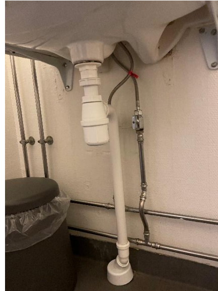
Afløb fra håndvask på toilet
