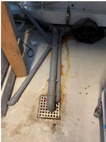
Afløb ude i teknikum
