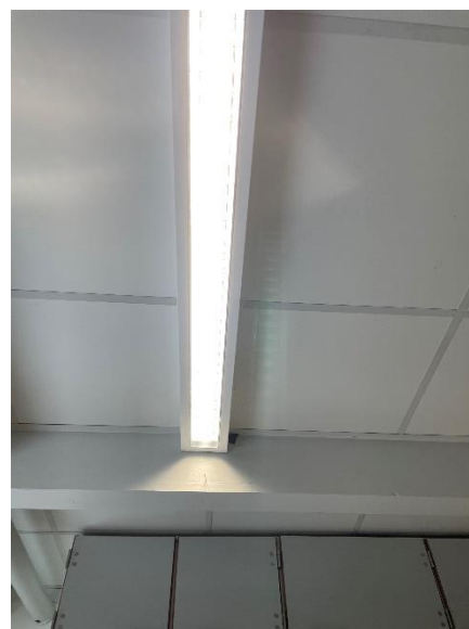
Belysning i køkkenet er udskiftet til LED
