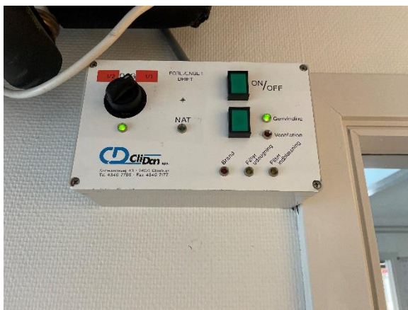
Ventilationsstyrings enhed
