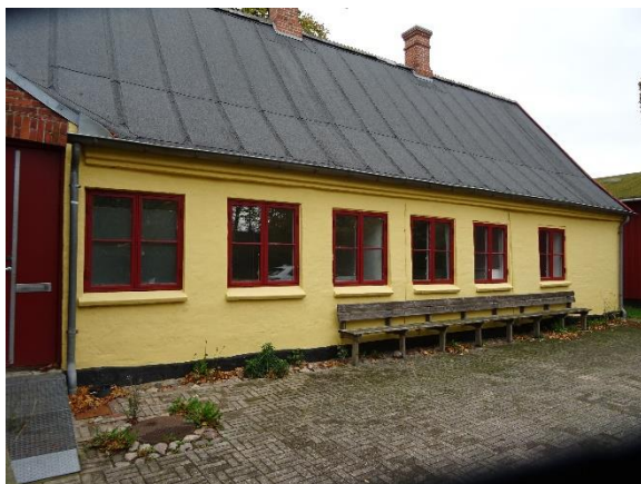
Sydside af tagpap med listedækning på længe
