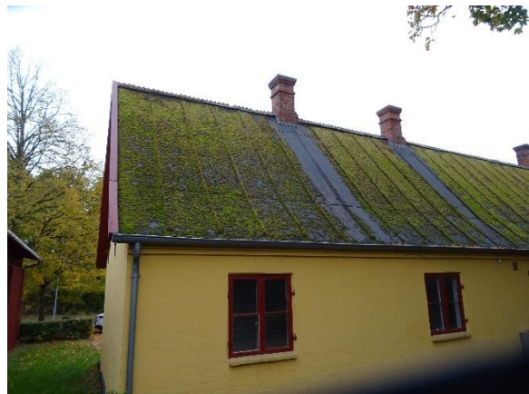
Nordside af tagpap med listedækning
