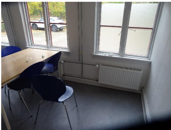
Nyere radiatorer med termostater
