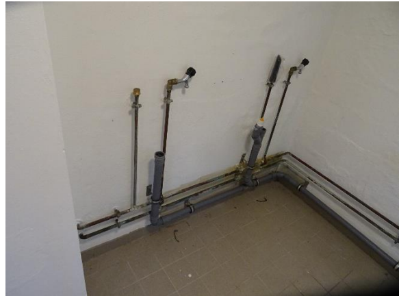
Rør og afløb efter demonterede vaske
