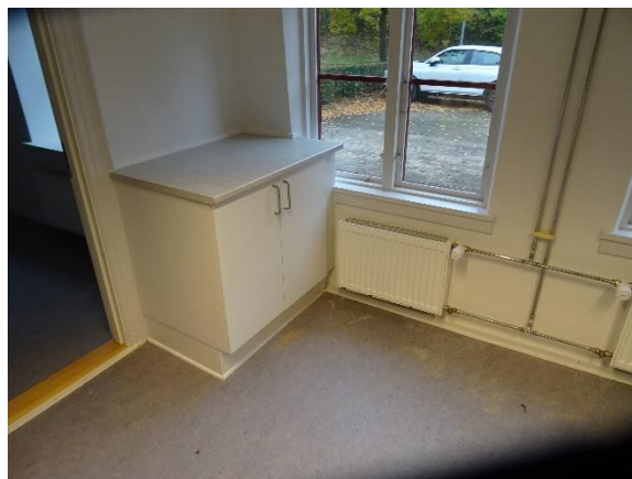
Skabselement hvor der ifølge tegninger skal være køkkenvask
