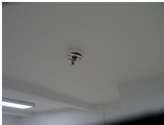
Sokkel for røgdetektor
