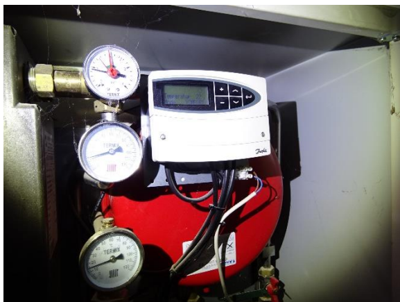
Varmestyring i fjernvarmeunit
