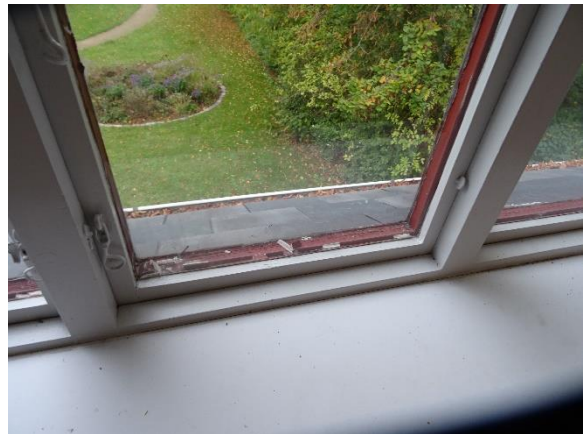
Vindue med koblede rammer i kvist
