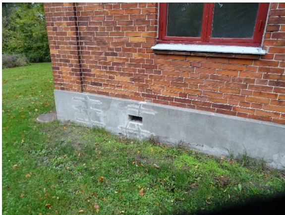
Sokkel hjørne med ilagt forstærkning
