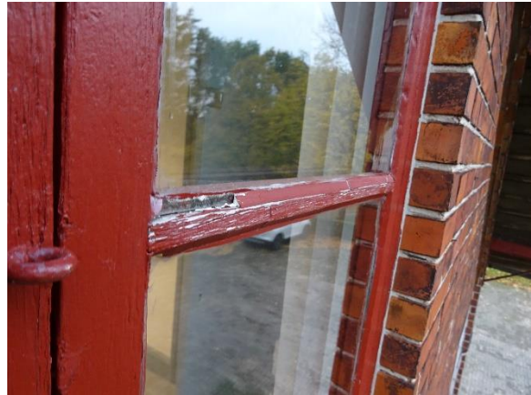
Kvistvindue, kit falder af sprosse der er under nedbrydning
