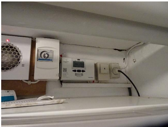
Ventilator med urstyring
