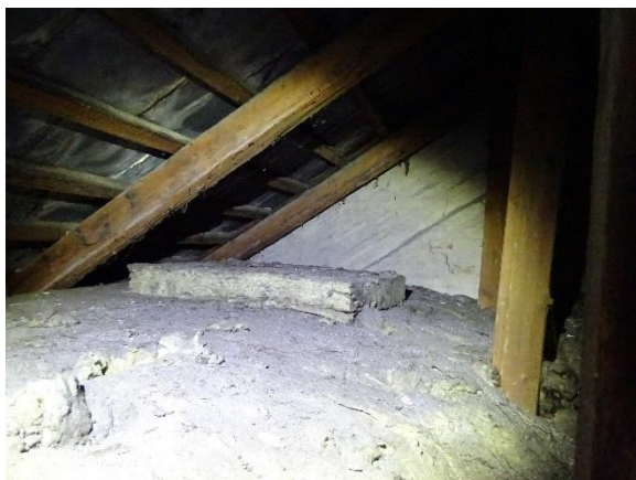
Isoleret spidsloft
