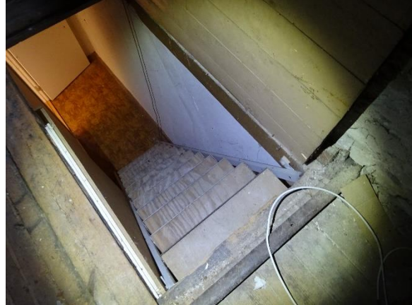
Trappe til loft over længe
