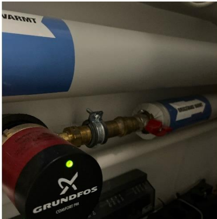
Cirkulationspumpe
