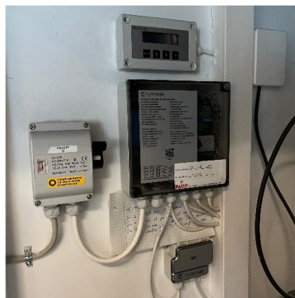
Brandsikringsautomatik
