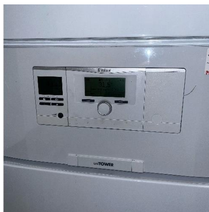
Vejrkompareret styring
