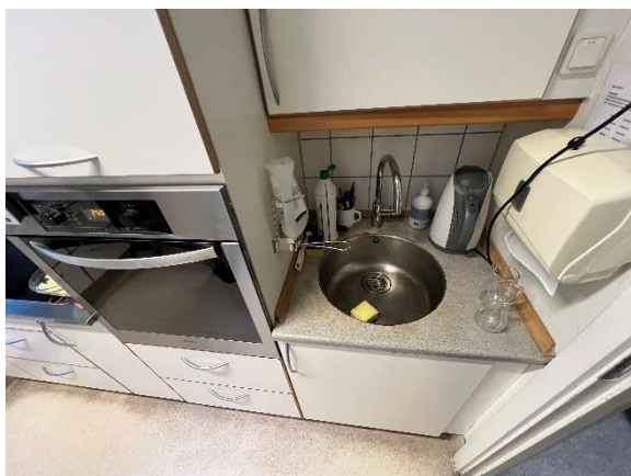
Laminatbordplade med underlimet vask.
