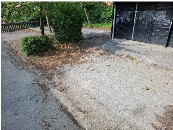
Asfalt og flisebelægninger ved redskabsskur
