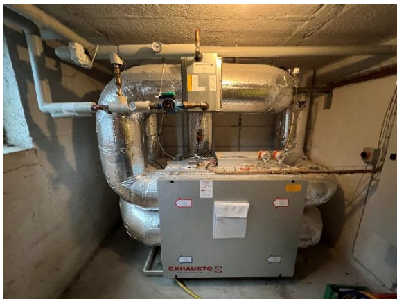
Ventilations aggregat med krydsvarmeveksler
