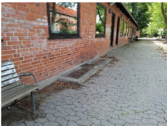
Terræn skræner ind mod bygningen ca. 4 meter fra facaden.
