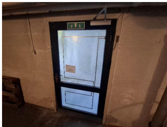
Kælderdoor ved rampe mod øst
