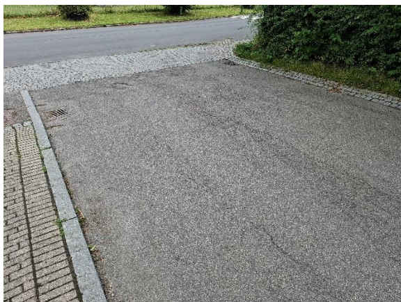
Asfaltbelægning mod øst
