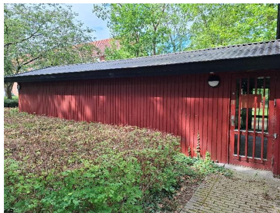
Let facade med træbeklædning på liggehal mod syd
