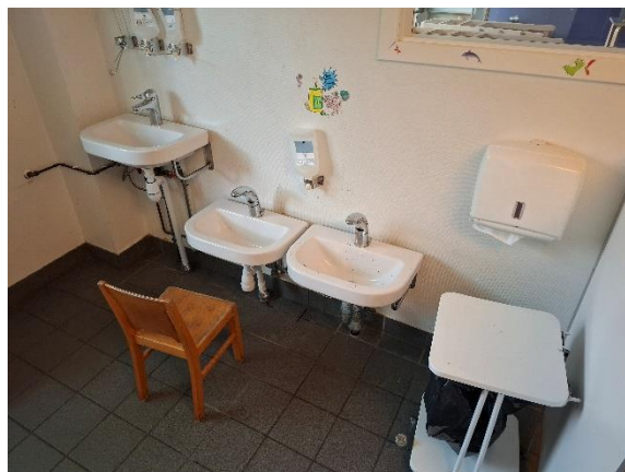
Nyere armaturer med hhv. 1 greb og sensor
