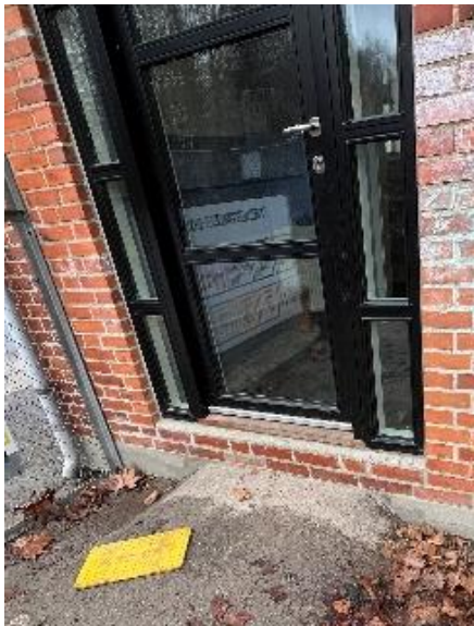
Nyere dør med energiruder og varm kant
