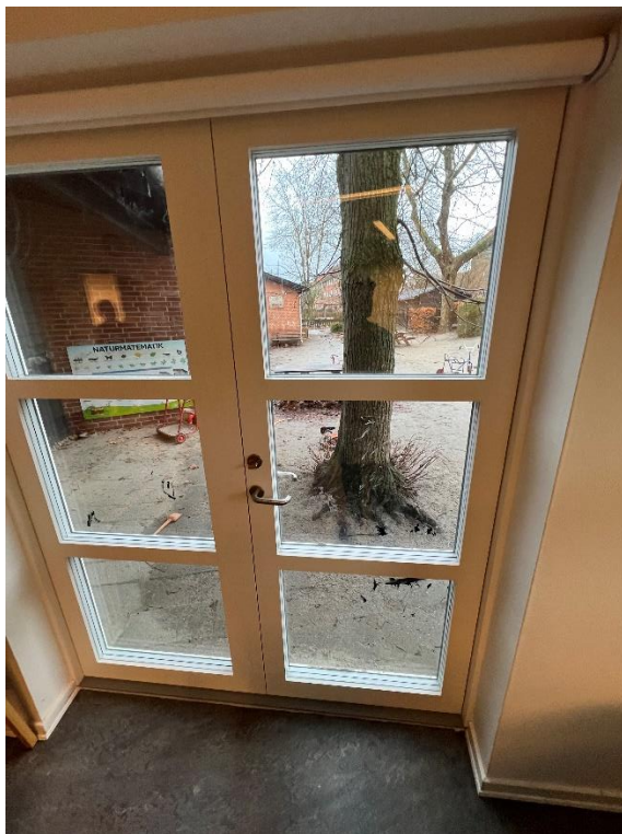
Ny dør med 3-lags energirude med varm kant.
