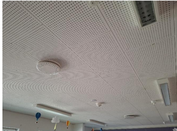
Loft med akustikgipsplader.
