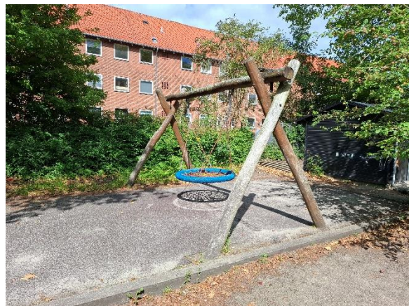
Legeplads elementer installeret med jordkontakt
