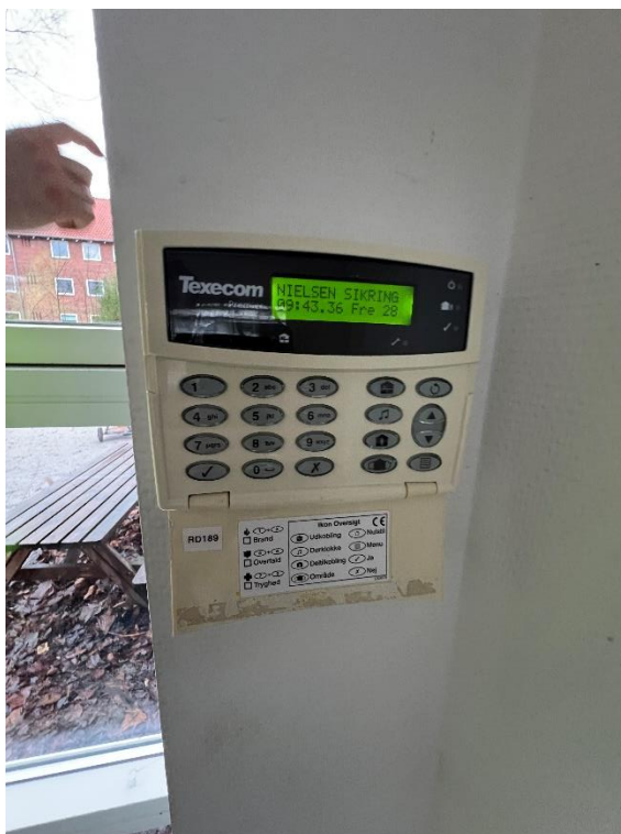
Indbrudsalarm kodetastatur
