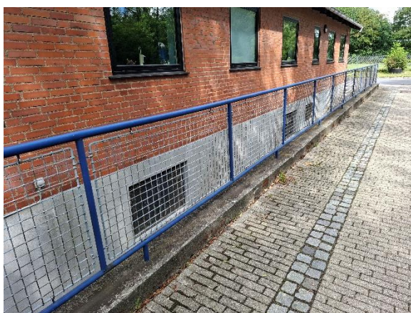
Trappeværn i malet stål.
