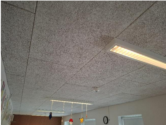
Loft med træbeton
