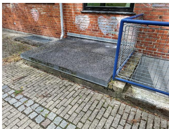
Nyere tagpapbelægning over overdækning til kælderør.
