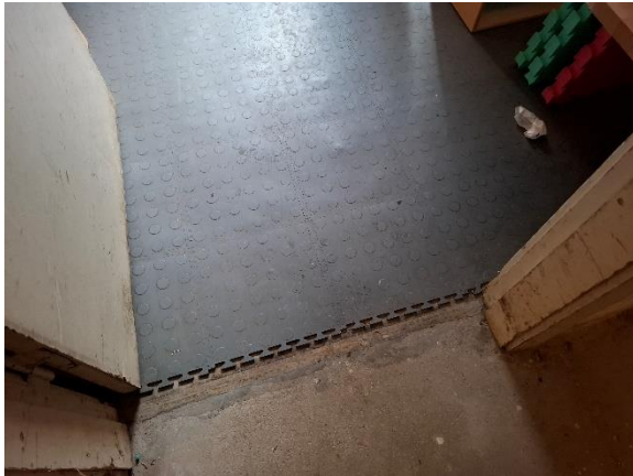
Gummigulv i kælder anbefales fjernet.
