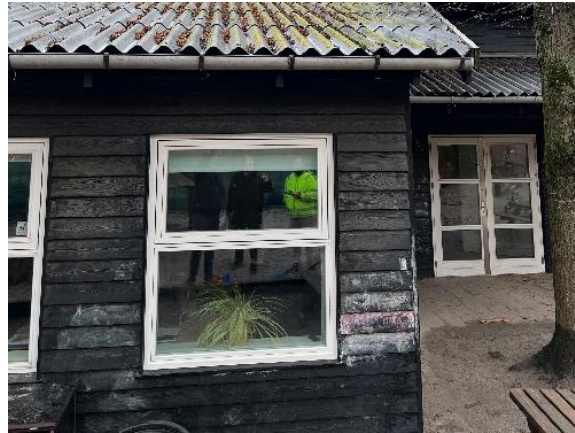
Vinduer i facade til kontor
