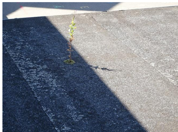
Tagpap på forbindelsesbygning over indgangsparti
