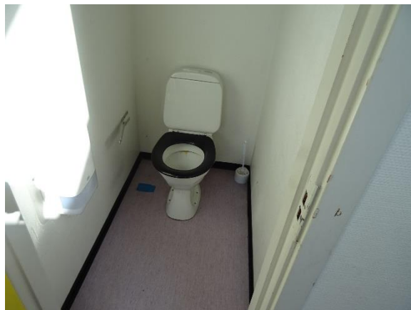
Skolettoilet uden egen håndvask
