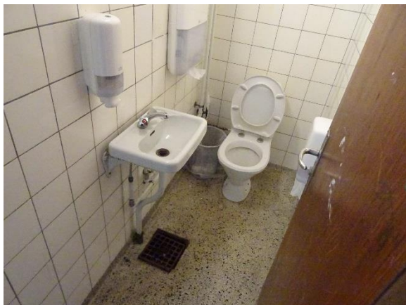
Skolettoilet med egen håndvask
