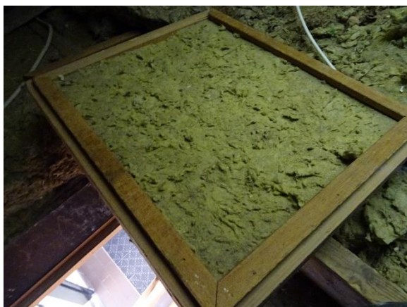
Isolering oven på loftlem
