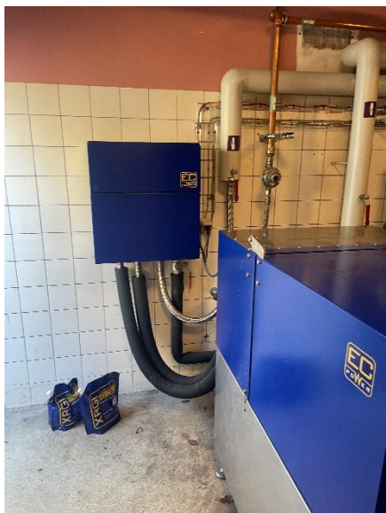
Gasgenerator med styring
