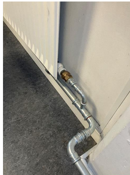
Presfitting af galvaniseret rør ved radiator
