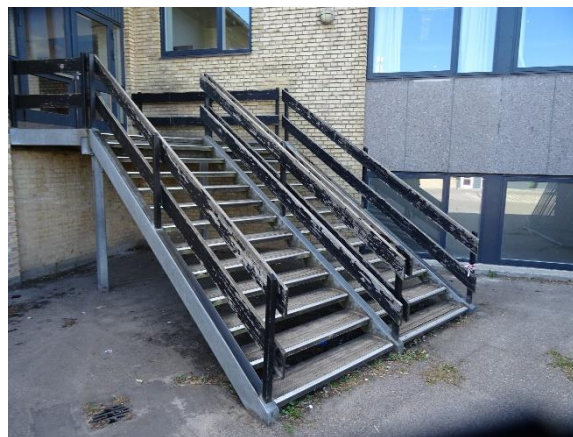
Hævet trappe til fløjindgang
