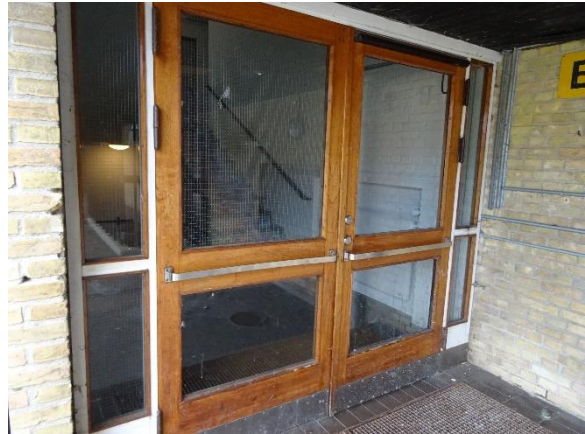
Nyere dør med glas energiruder
