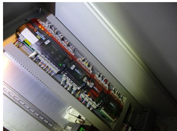
Trend controller på loft over lærerværelse. U hensigtsmæssig placering.
