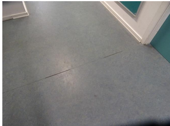
Revnet svejsning i linoleums gulv
