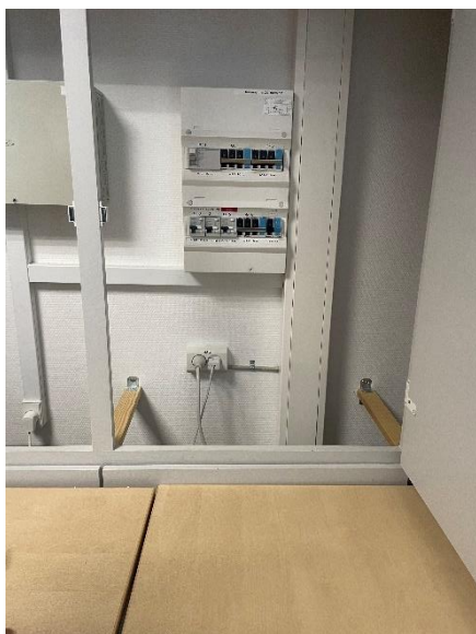
Sektionstavle i skab der er blokeret af border.
