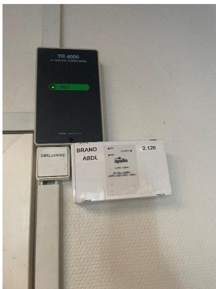
ABDL dør koblet til ABA-systemet
