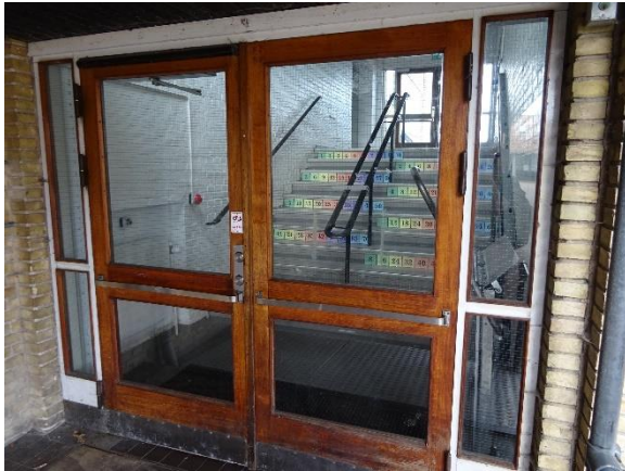
Nyere dør med glas energiruder
