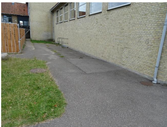
Asfalt ved gymnastiksal
