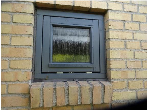
Ældre vindue med træramme
