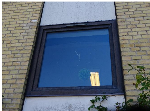
Ældre vindue med træramme
