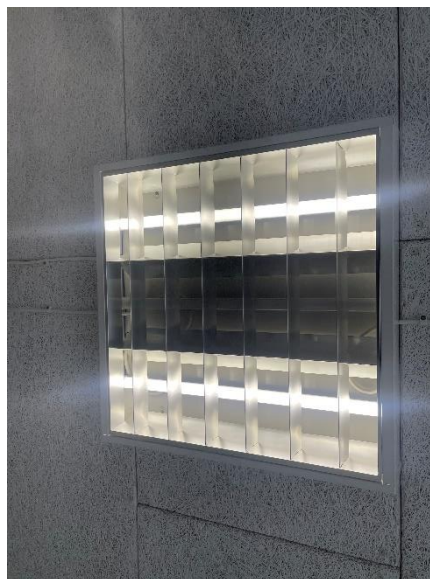
Armaturs udskiftet til LED
