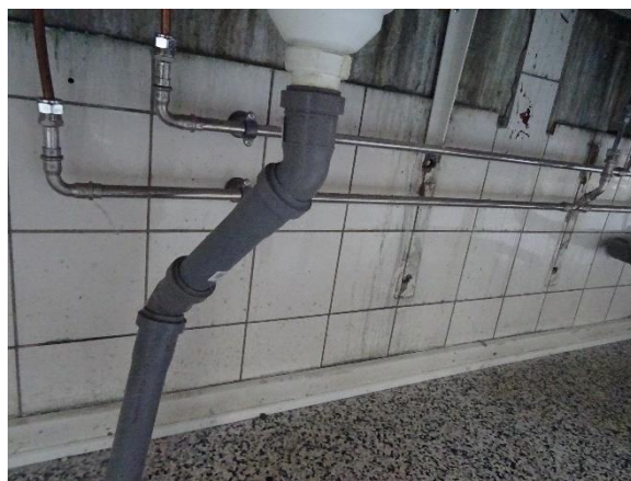
Afløbsrør siddende under borde hvor børn sidder. Risikerer at blive sparket i stykker og mangler mekanisk beskyttelse
