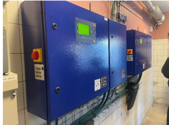
Styring til EC-power XRG1 20 mini gaskraftværk 2.stk
