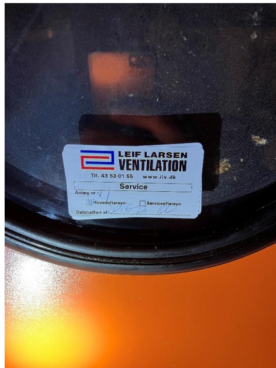
Hovedeftersyn i 2016 – Umiddelbart ingen senere service mærker
