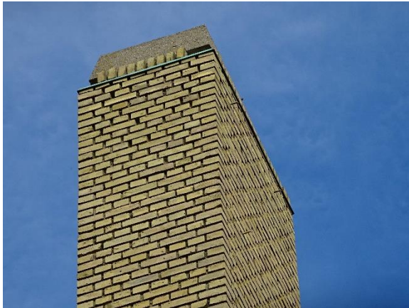
Muret skorsten med tegl
