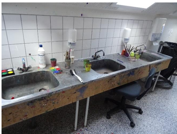
Afløbsrør siddende under borde hvor børn sidder. Risikerer at blive sparket i stykker og mangler mekanisk beskyttelse
