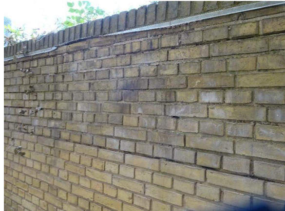
Mur omkring kælderhals med rulleskifte
