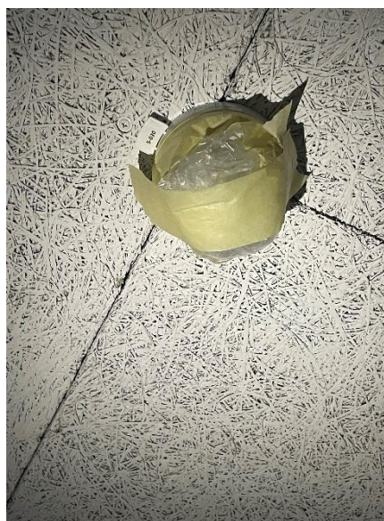
ABA-melder der er tapet over med plastik
