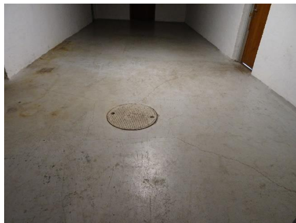
Kældergulv af beton med slidlag
