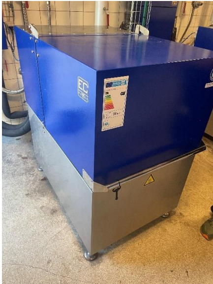
EC-power XRG1 20 mini gaskraftværk 2.stk
