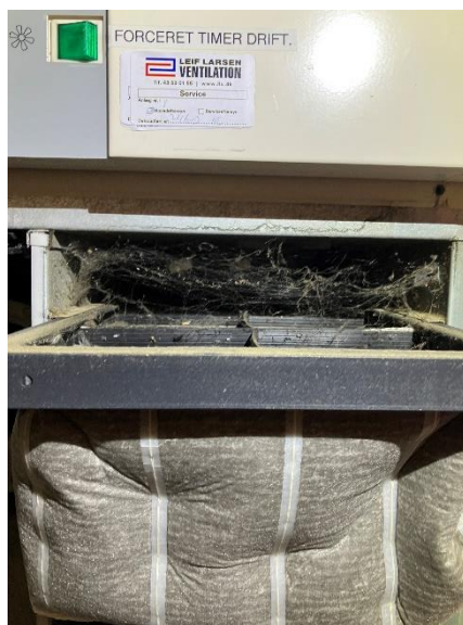
Filter ekstremt tilnavset
