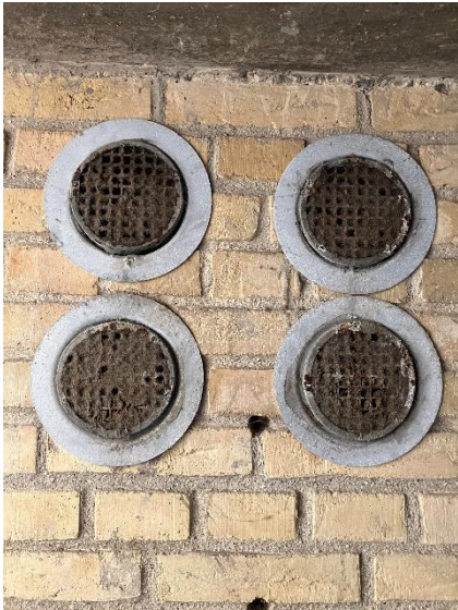
Sugeriste tæt på tilstoppet af skidt
