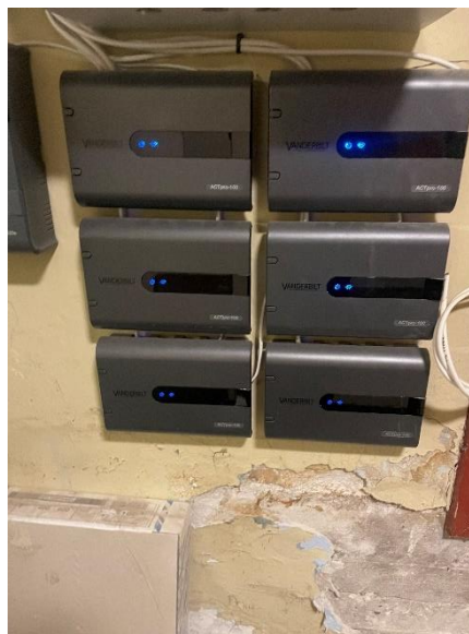
Vanderbilt ADK adgangskontrol system central
