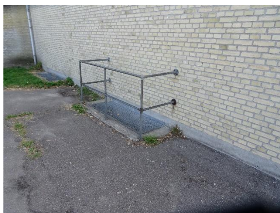
Sokkel under muret sokkel.
