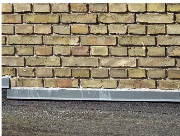
Teglstens facade ved tagkonstruktion
