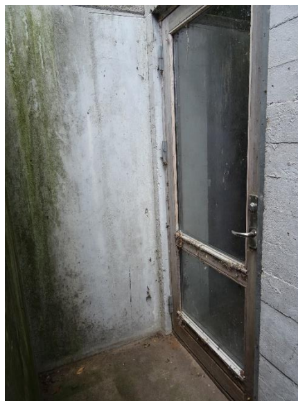
Dør mod kælderrum under jordniveau
