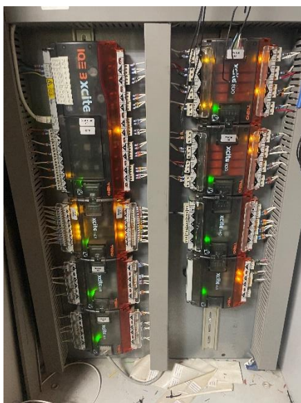
Trend styring af automatik
