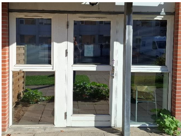
GM1 – yderdør til terrasse/altan
