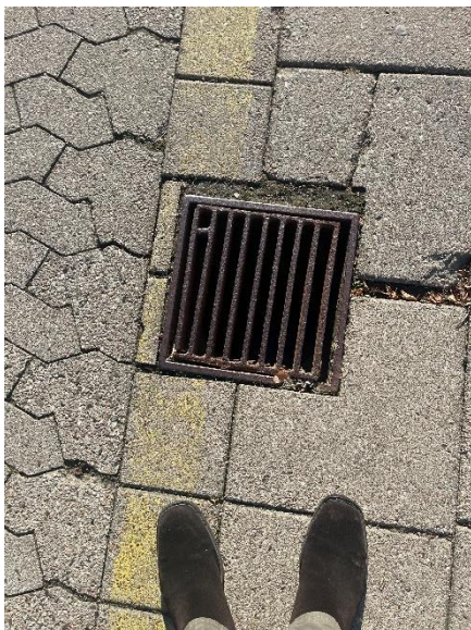
Rist dæksel ved indkørsel mellem GM 1 og GM5
