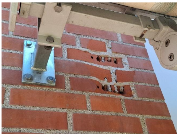
GM 1 – huller i ydervæg efter tidligere montering af markise
