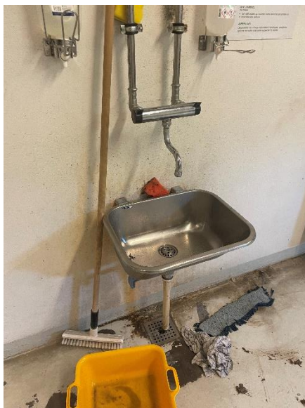
Zink i lagerrum i kælder GM5
