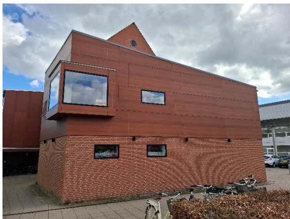
GM 1 – Facade på tilbygning
