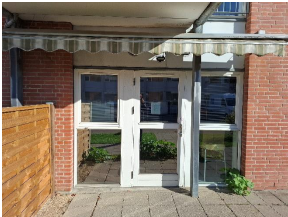
GM 1 – Oprindeligt vinduesparti til terrasse
