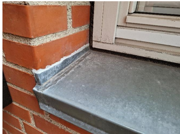
GM 1 – Sølbænk med mørnet elastisk fuge.
