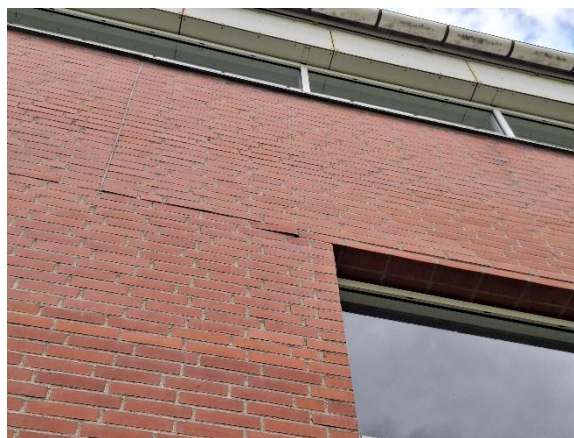
GM 1 – Stenene har skubbet sig ud i enden af alle overliggere på facaden mod nord.
