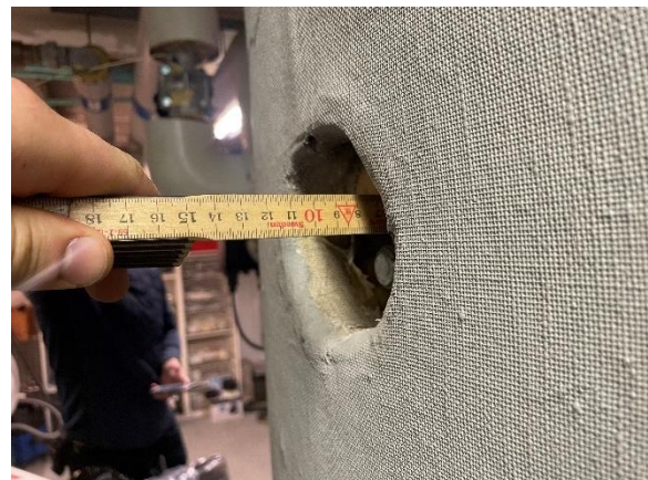
VVB isoleringstykkelse
