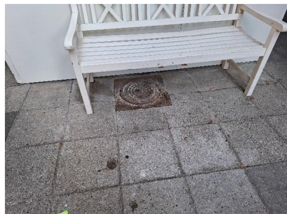
Brønddæksel ud for hovedindgang til GM1
