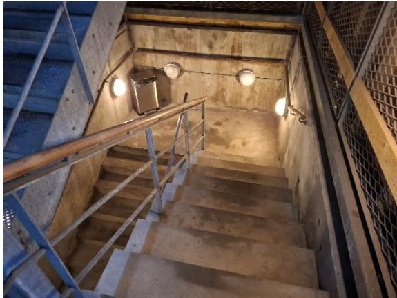
GM 1 – Betontrappe til kælder
