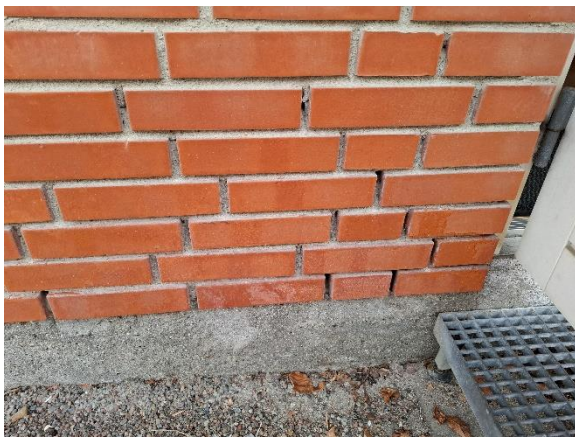
GM 5 – Murværk på tilbygning mod nord.
