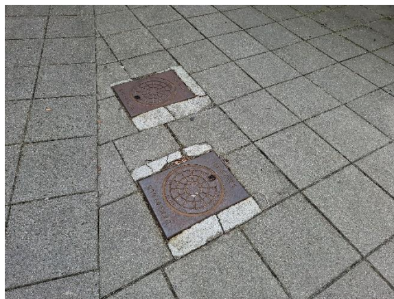
Brønddæksler ud for hovedindgang til GM5
