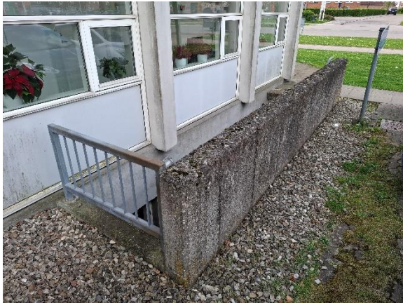
GM 5 – Værn til kælderskakt
