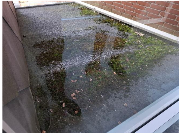
GM 1 – Mosbegrøninger på tagpaptage mellem blokkene
