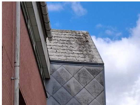
GM 1 – Eternitskifer på elevator- og affaldstårn
