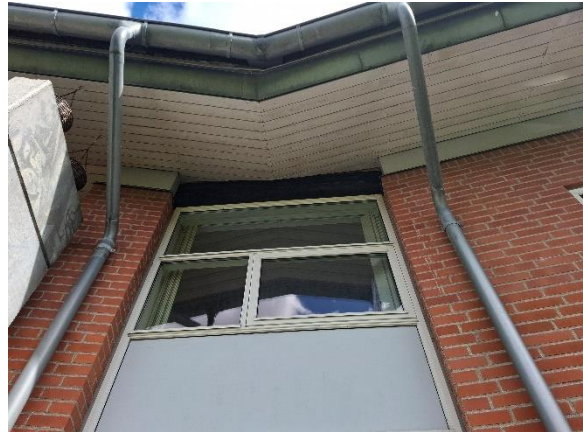
GM 5 – Udhæng og nedløb mod syd
