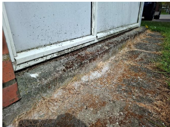
GM 5 – Der ses kager af salt mod sokkel på østgavl.
