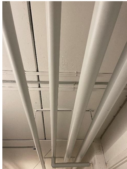
Brugsvandsrør vedsiden af varmerør i kælder Gm5
