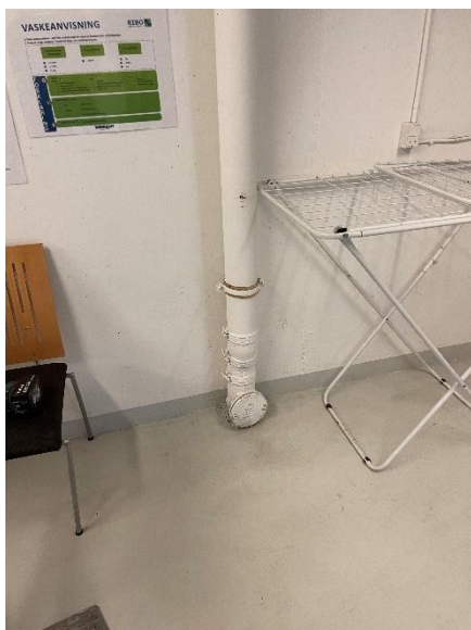
Afløbsrør i kælder i rengøringsrum GM5
