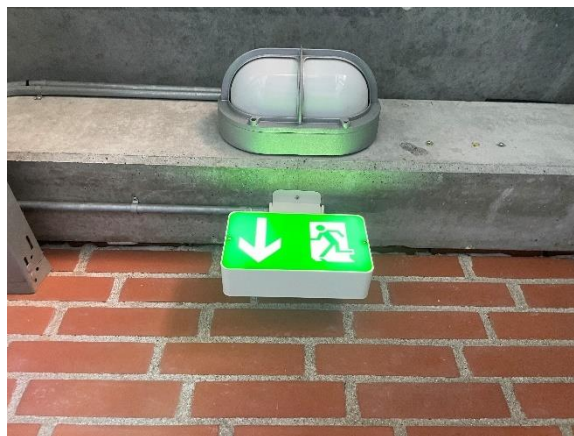
Flugt og panikbelysnings armatur LED
