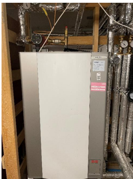
Varmtvandsbeholder
