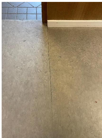
Svejsning i ældre bygning
