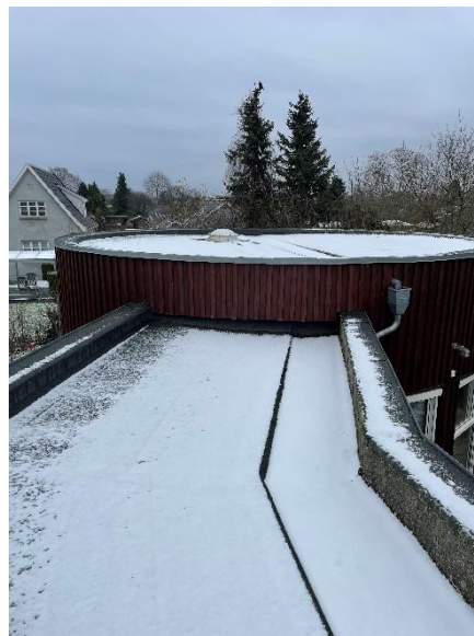
Del af tagpaptag på nyere bygning
