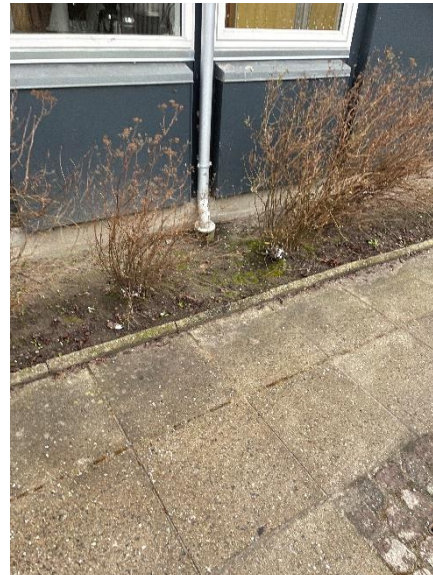
Nedløb fra tagrende i kloak ved fundament
