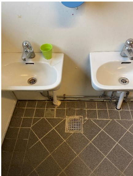
Afløb på toilet ved håndvaske
