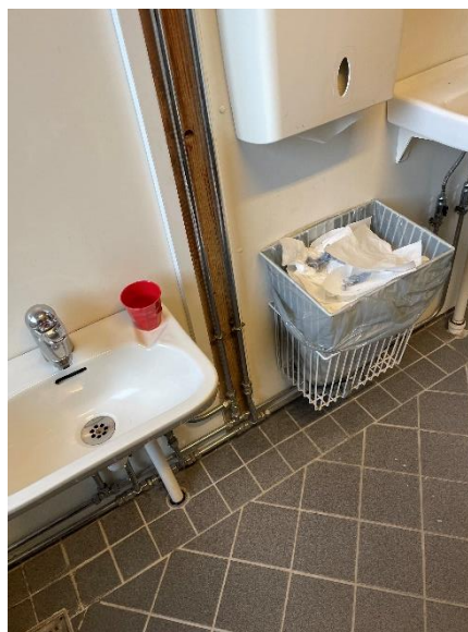
Bad i ældre bygning med flisegulv
