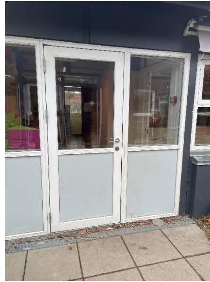
Glasdør i ældre del af bygningen
