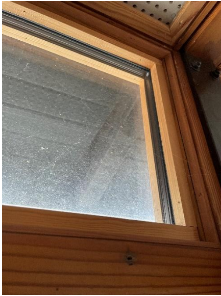
Energirude 2 lags med varm kant i træramme
