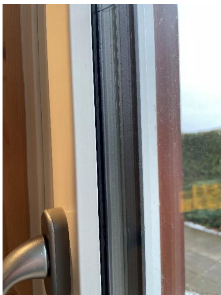
Energirude 3 lags med varm kant
