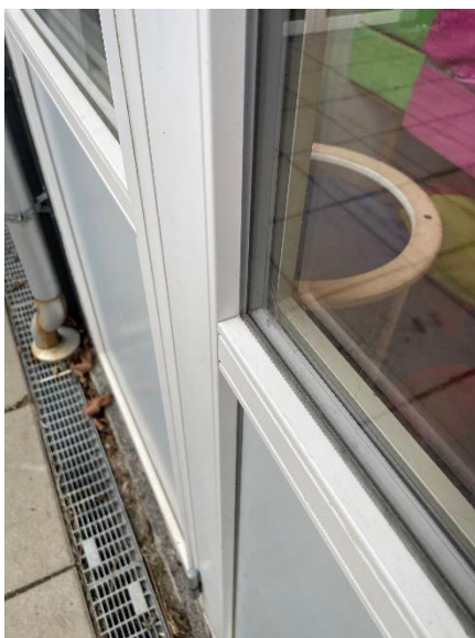
Vinduesramme på midterbygning facade
