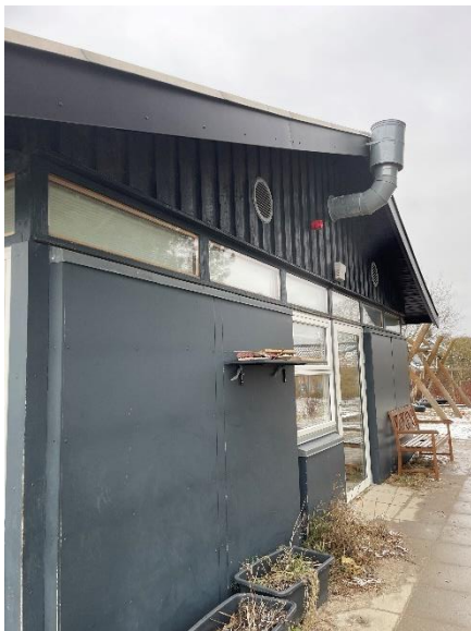
Gavl på den gamle del af bygningen i 1 på 2 bræddebe- klædning
