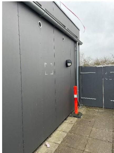
Fibercementplader
