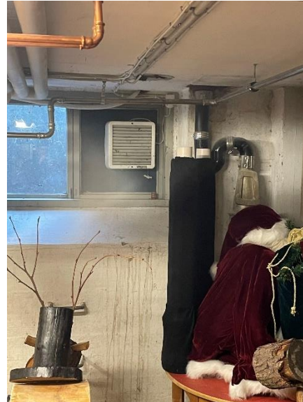
Vindue og ventilator i kælder
