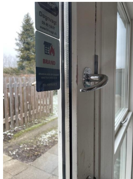
Der er to lags termorude i glasdøre på den ældre del af bygningen.
