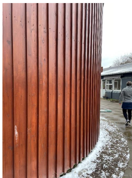
Facade på 2017 bygningen
