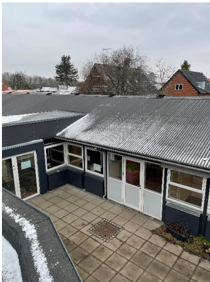
Kloakdæksel i midten af gård ved legeplads
