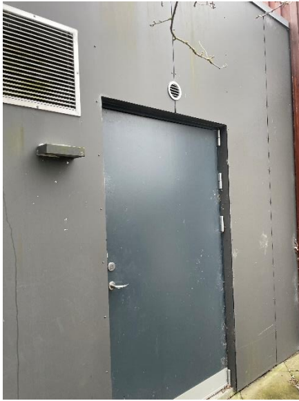
Massiv dør ind til ventilationsanlæg
