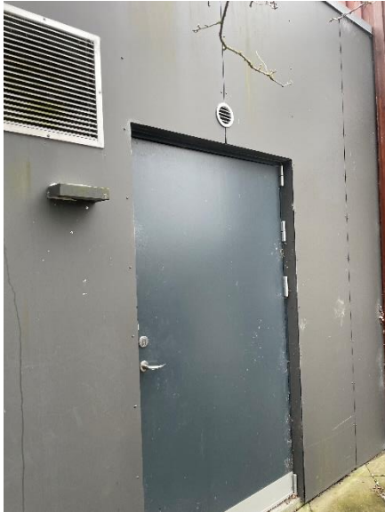
Massiv dør ind til ventilationsrum
