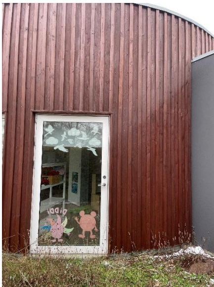
Glasdør i nyere del af bygningen med energirude
