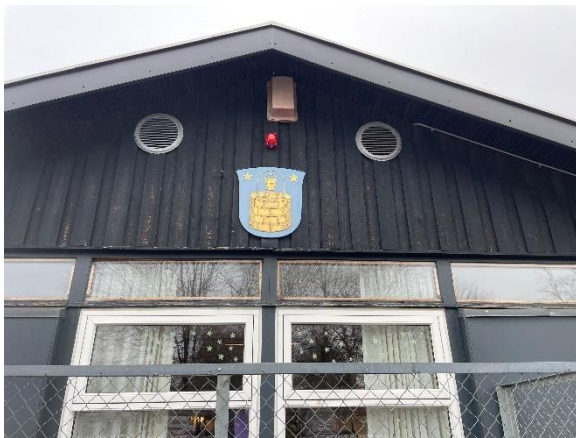
Modsatte endegavl gamle bygningsdel
