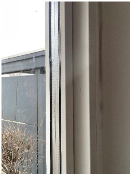
To lags energirude med kold kant
