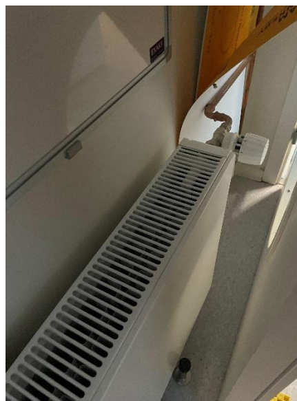
Radiator 2 strengs system med kobberør
