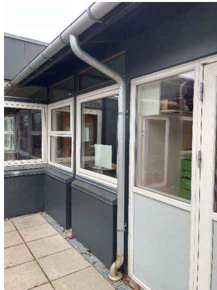
Nedløbsrør på den gamle del af bygningen
