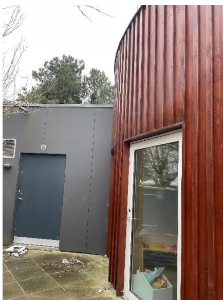
Til venstre rum med ventilations aggregat, til højre dele af facaden på 2017 bygningen
