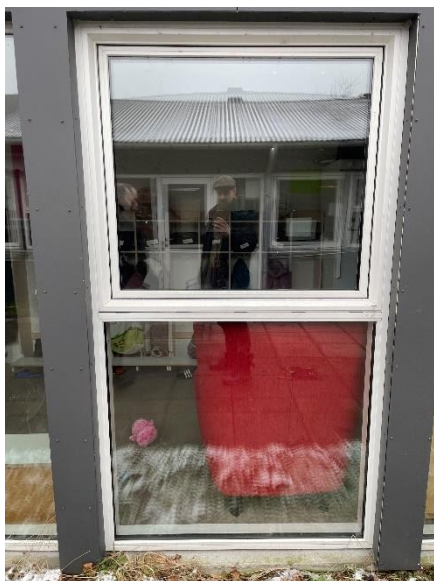
Oplukkeligt vinduesparti ved den nyere bygning.
