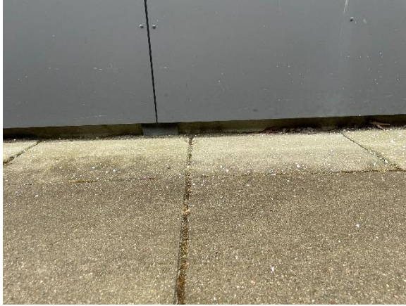
Sokkel under eternitfacade ved ventilationsrum
