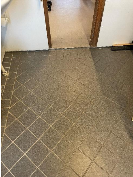
Flisegulv i ældre bygning
