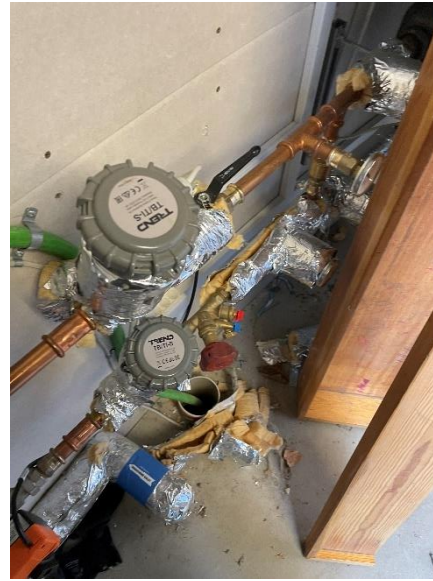
TREND styring af vand/varmeinstallation
