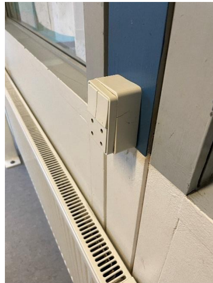
Revnet dåse til stikkontakt ældre del af bygningen
