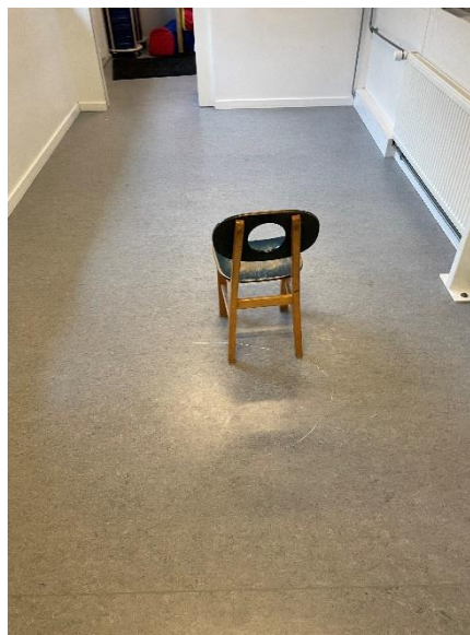
Eksempel på linoleumsgulv i ældre bygning
