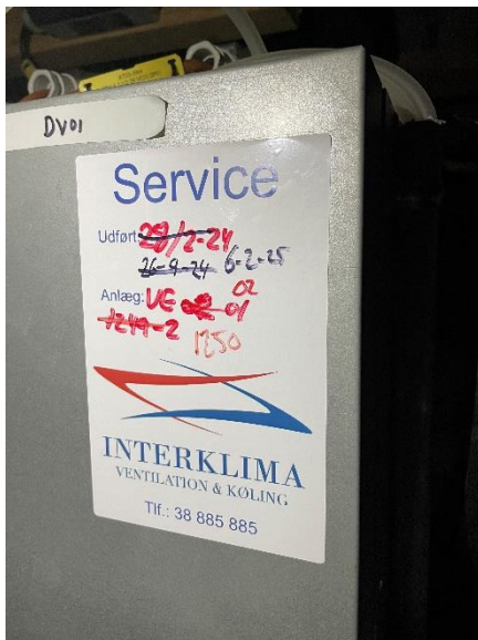
VE 02 til den ældre bygning på loft
