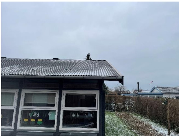
Ståltrapez tag på gammel del af bygningen
