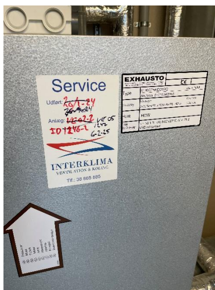
VE 05 til den nyere bygning
