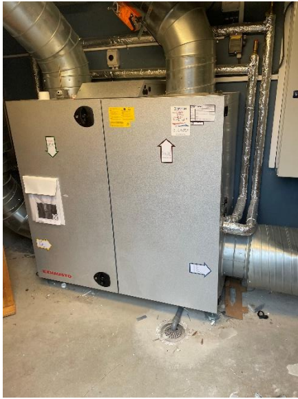
VE 04 til den nyere bygning
