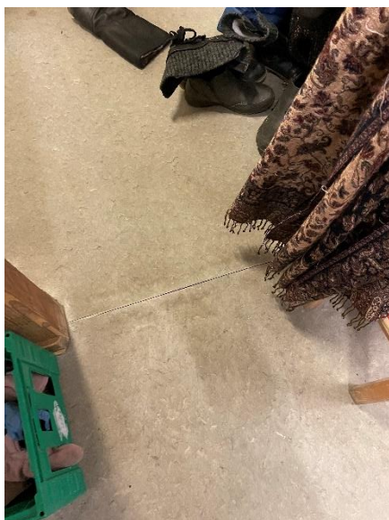
Svejsning i ældre bygning
