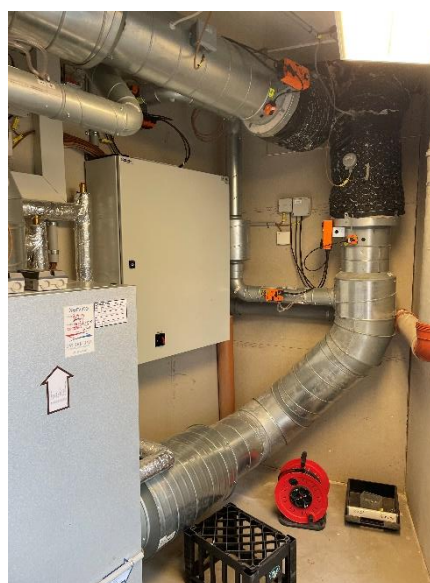
VE 05 til den nyere bygning
