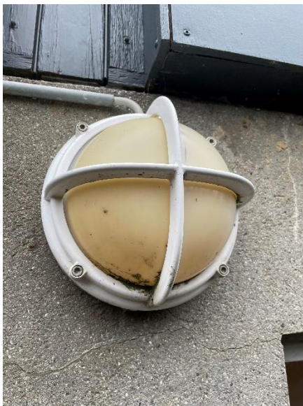
Kompaktrørs armatur udvendigt
