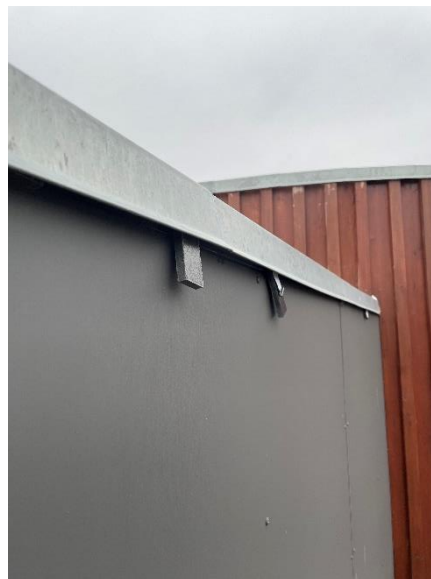
Kiler der holder sterninddækning på plads
