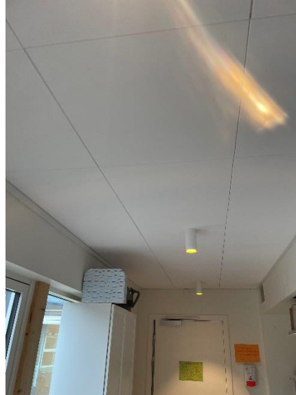
Systemloft med skjulte skinner
