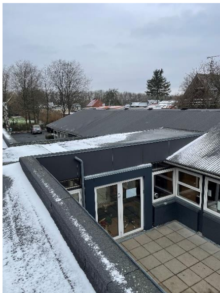
Forbindelsesgang og indgang mellem den nye og gamle del af bygningen
