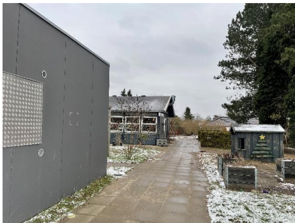
Flisebelægning samt legehus
