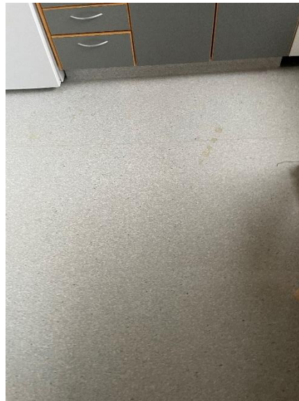
Gulv i forbindelse med ombygning i den ældre bygning
