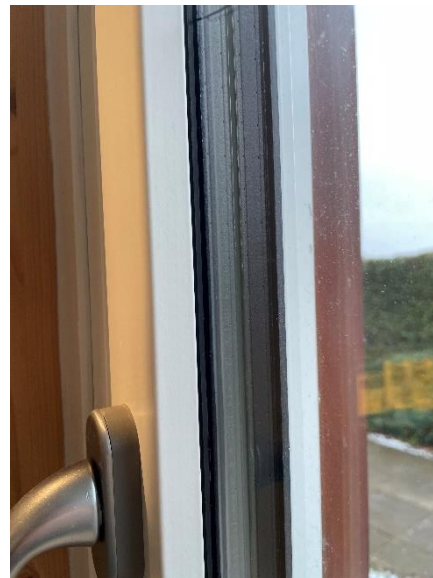
Tre lags energirude med varm kant
