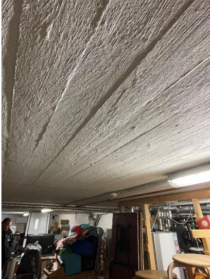
Loftet i kælderen mod stue, ældre bygning
