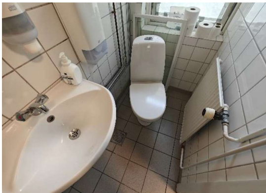
Toilet i staldbygningen.
