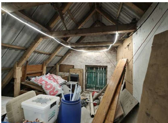
Loftsrum i staldbygning
