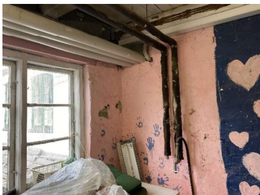
En del af rørføringen fremstår som værende den oprindelige fra bygningens opførelse.
