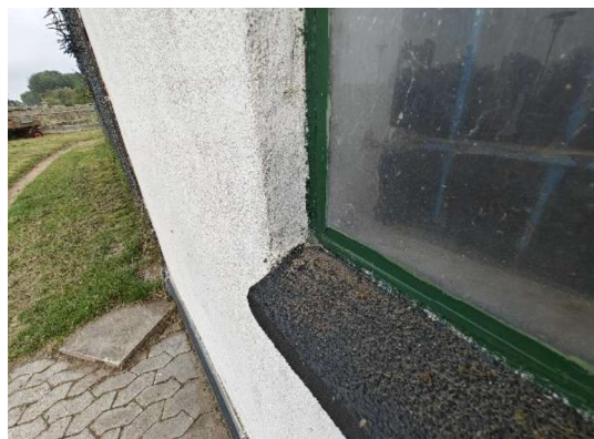
Vinduer på staldbygningen
