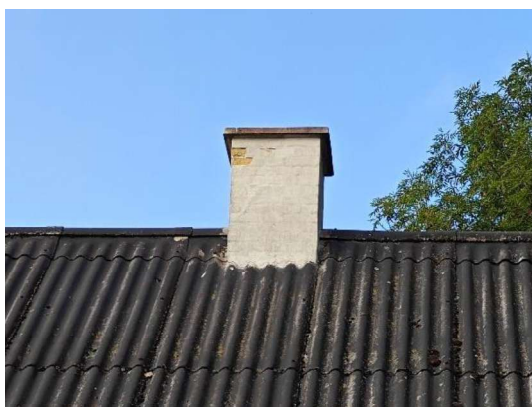
Inddækning omkring skorsten
