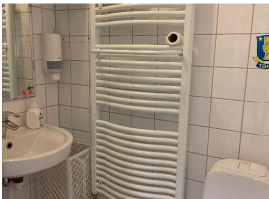
Vådrummene opvarmes ved vandbaseret håndklædetørrer
