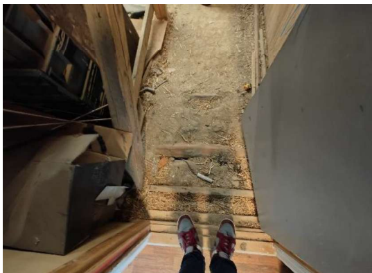
Bjælkelag med lerindskud på loftsrums over stalden
