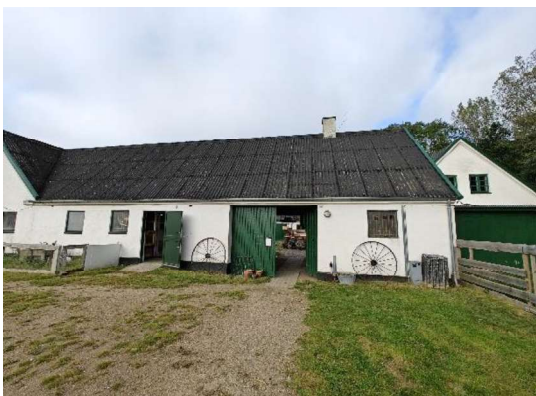
Facader på staldbygning
