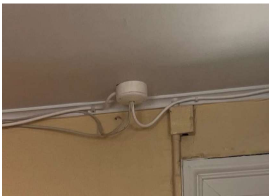
Ulovlig belysningsinstallation.
