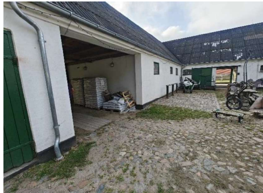
Facader på staldbygning
