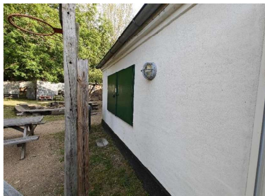
Facader på staldbygning
