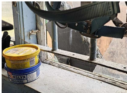
Vinduer på staldbygningen
