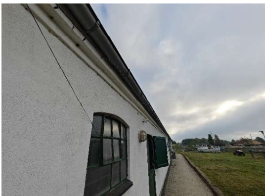
Vinduer på staldbygningen
