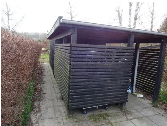
Udhus øst for institution, bygning 4
