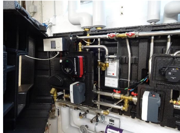
ECL styring for varmeanlæg med PDS stik
