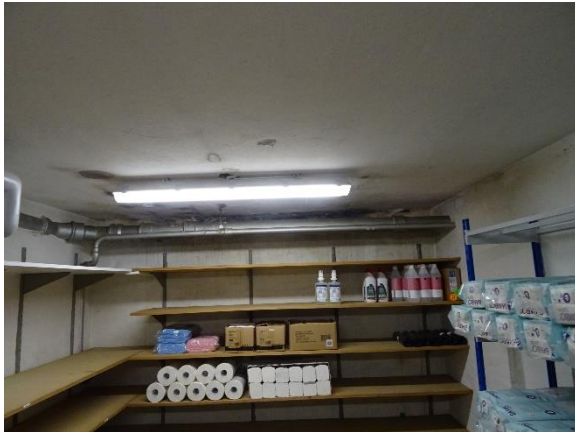
Loft i kælder
