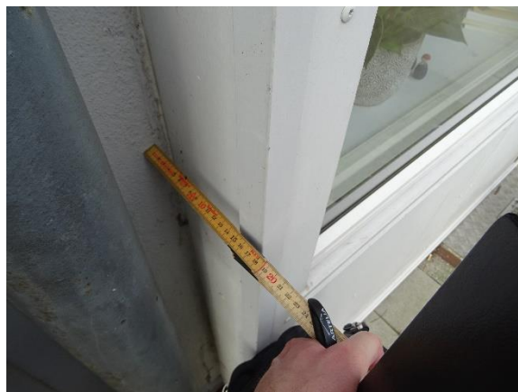
Udvendig isolering på østfacade
