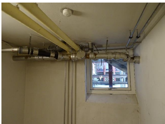
Støbejernsafløb fra opførelsen
