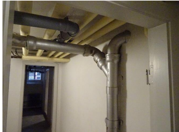
Kælderloft i gang
