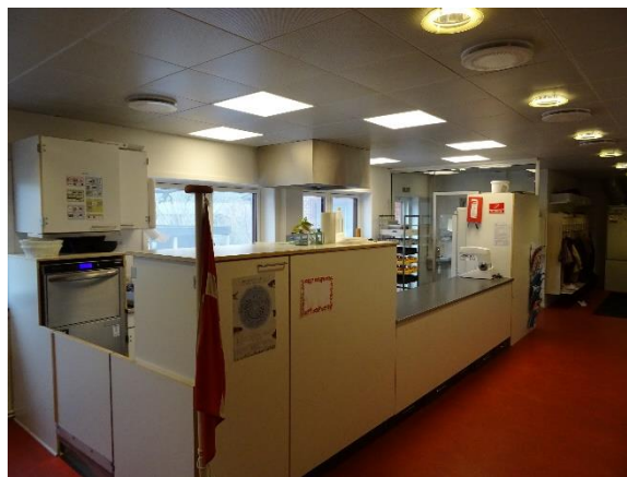
60x60 LED paneler over køkken og indbygningsarmaturer til PL rør i gang areal.
