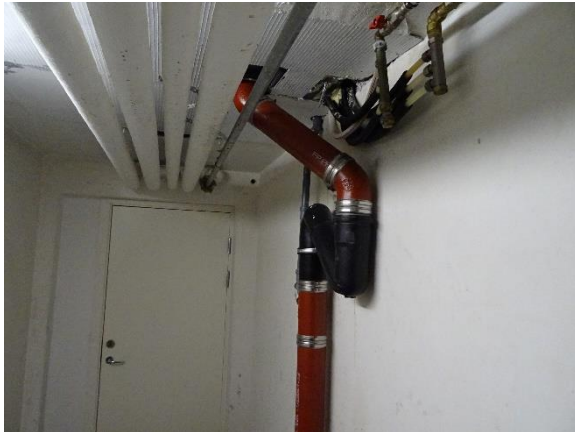
Nyere støbejernsfaldstamme fra renovering
