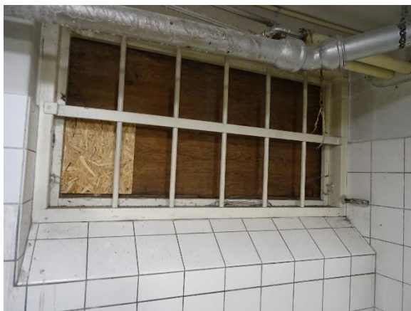
Vindue i kælder monteret med blændplade
