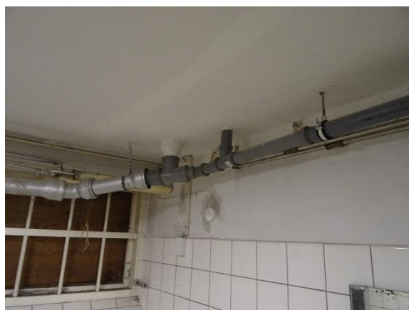
Plast afløb fra renovering
