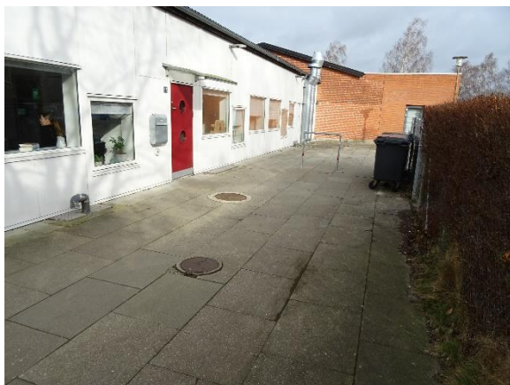
Kloakbrønde øst for bygning
