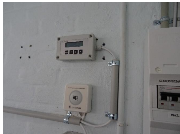
Brandspjældsautomatik
