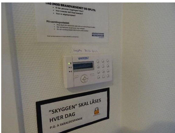
AIA indbrudsalarm, kodetastatur
