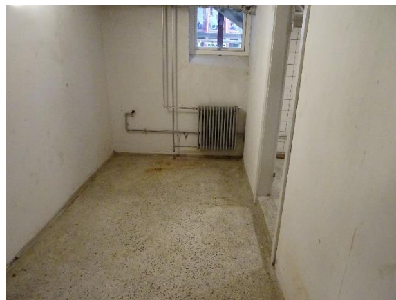
Kælder gang foran nedlagte toiletter
