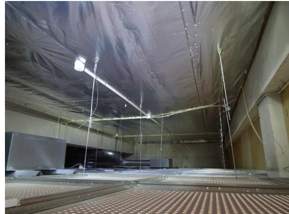
Kig over systemlofter. Folie er underside af loft.
