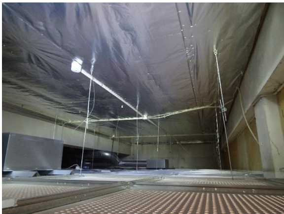
Over nedsænket loft, dampspærre mod tagrum øverst
