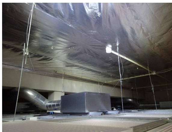
Kanalsystem over lofter og alukraft mod loftrum øverst
