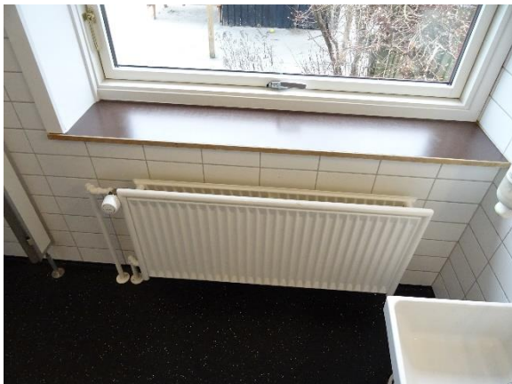
Nye radiator på toilet
