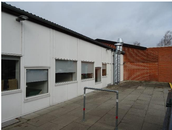
Facade mod øst udvendigt efterisoleret
