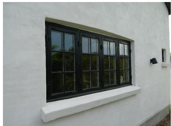
Oprindeligt renoveret vindue
