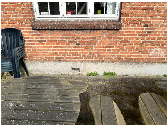
Røde teglsten. (Bygning 1)
