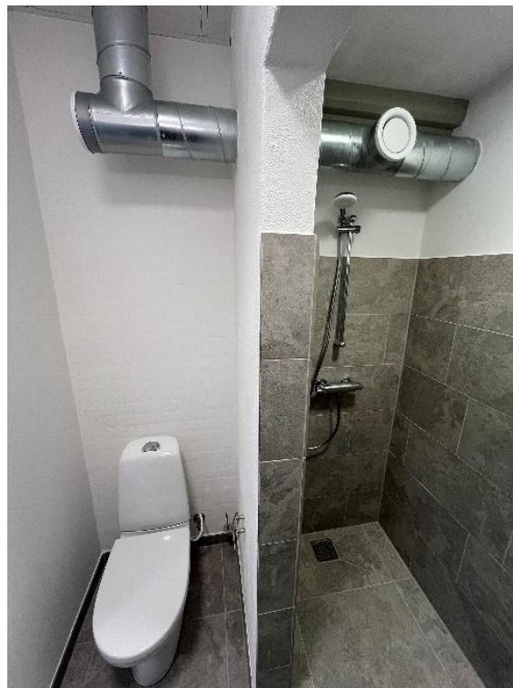
Toilet i bygning 2
