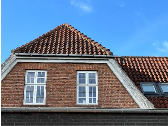
Vinduer med forsatsvinduer
