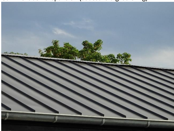
Stål tag (bygning 2).
