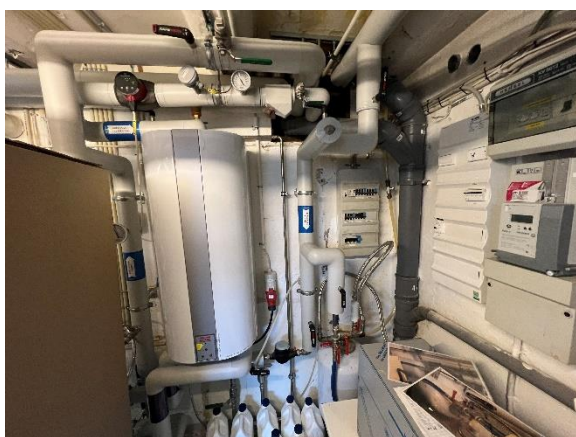
Varmtvandsbeholder bygning 1
