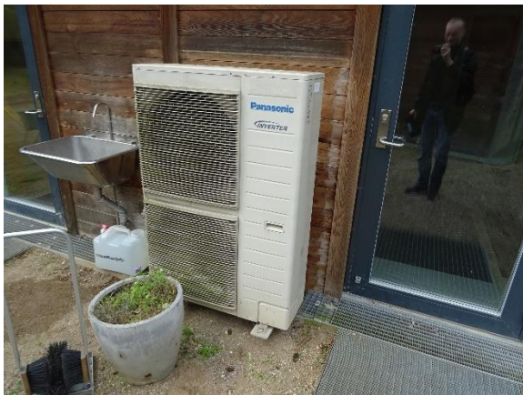
Varmepumpe udedel, en af to
