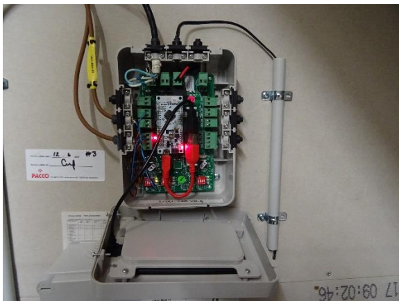
Spjældstyring controller
