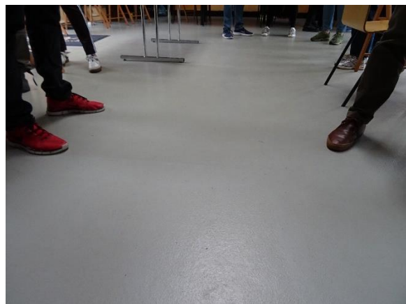
Gulve i epoxy, formidlingsrummet
