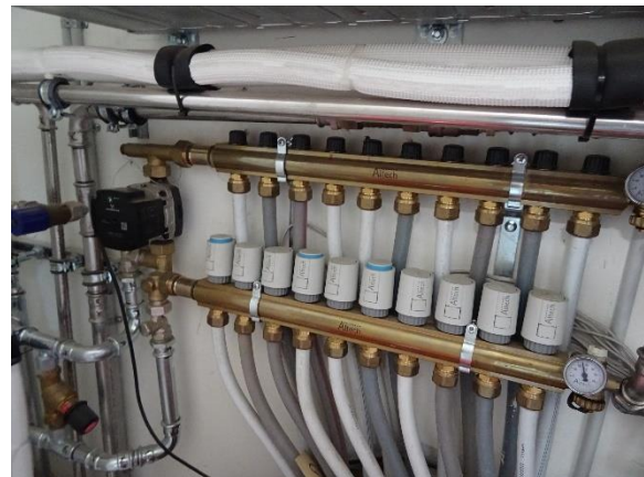
Gulvvarmeshunt formidlingsbygning
