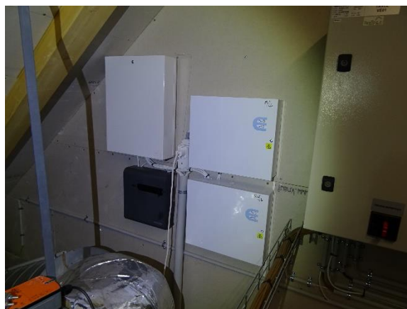
Indbrudsalarm central
