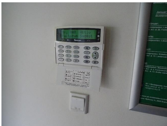
Indbrudsalarm kodetastatur
