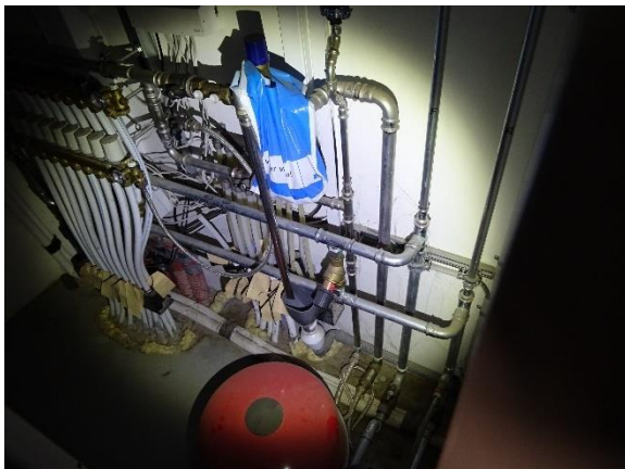
Gulvvarmeshunt administrationsbygning
