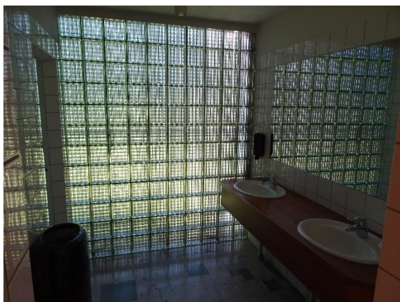
Ydervæg på toilet i glasbyggesten.
