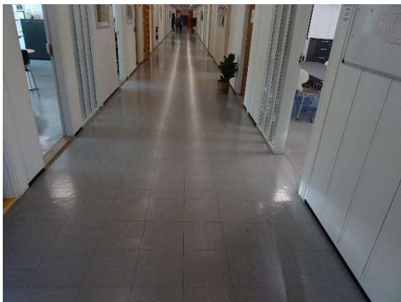
Oprindelige vinylfliser i gang og på kontorer
