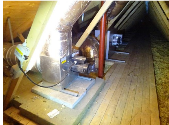
Ventilatorer i tagrum 1. sal. Nyere 2020 modeller.
