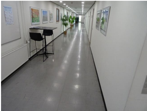
Kældergang omkring gang 7-8 med vinylfliser
