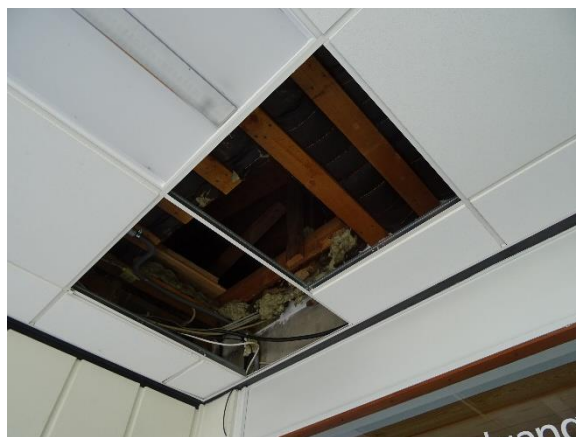
Åbning direkte til tagrum over loftplader
