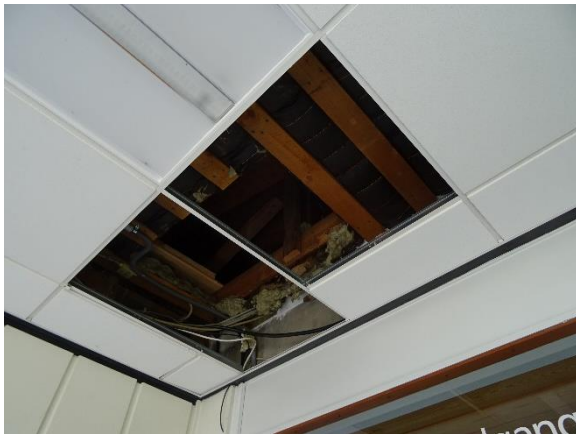
Åbning direkte til tagrum over loftplader
