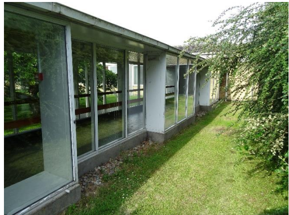
Forbindelsesgang i let konstruktion
