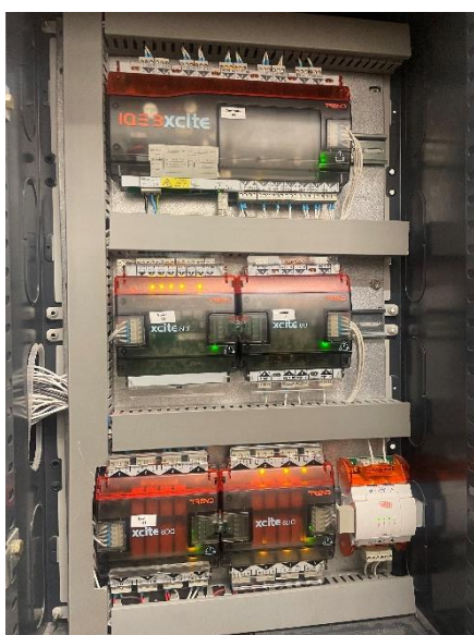
TREND IQE3 Xcite styrings system fra 2009
