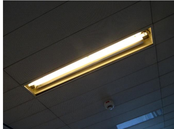
Loftsintegreret armatur i kontor, ikke skiftet
