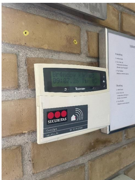
Texcom panel ved dørudgang i nordfacade
