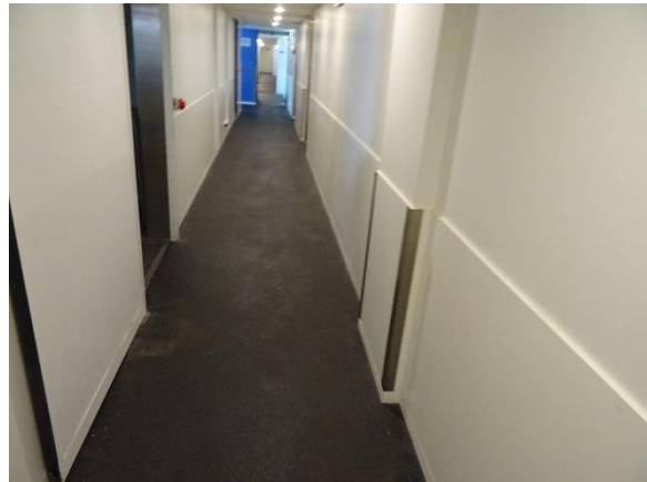
Kældergang ved kantinekøkken
