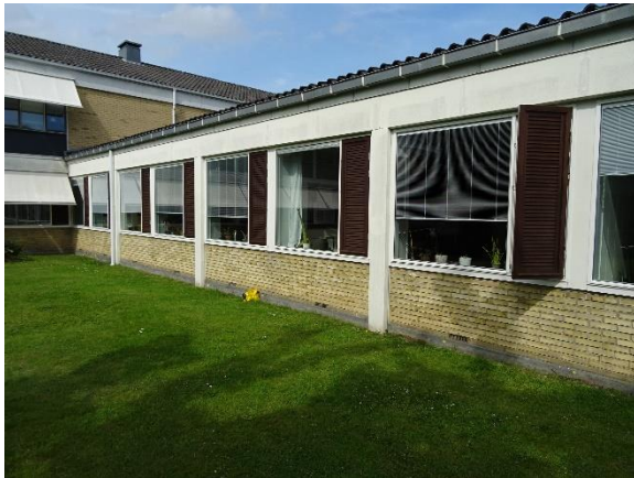
Typisk søjle/bjælke facade med muret brystning under vinduer
