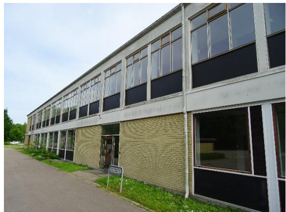
Facade mod nord med 1. sal fra 2001
