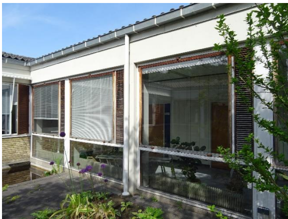
Oprindelige vinduer med rammer i teak
