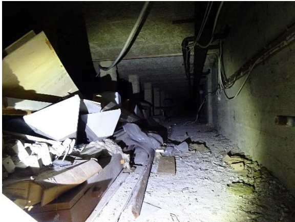
Rør i krybekælder
