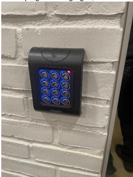
Kode tastatur til adgangskontrol
