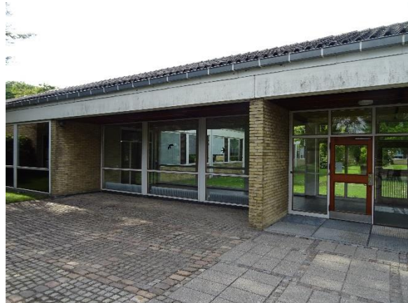
Forbindelsesgang i søjle/bjælkesystem
