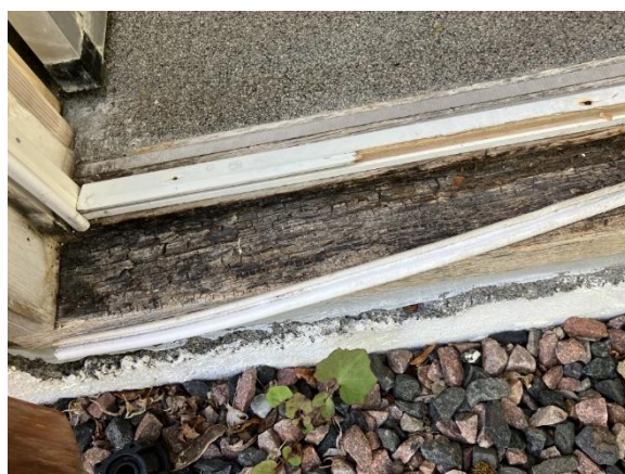
Råd i karm ind til produktionskøkken
