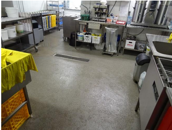
Produktionskøkken ved kantine
