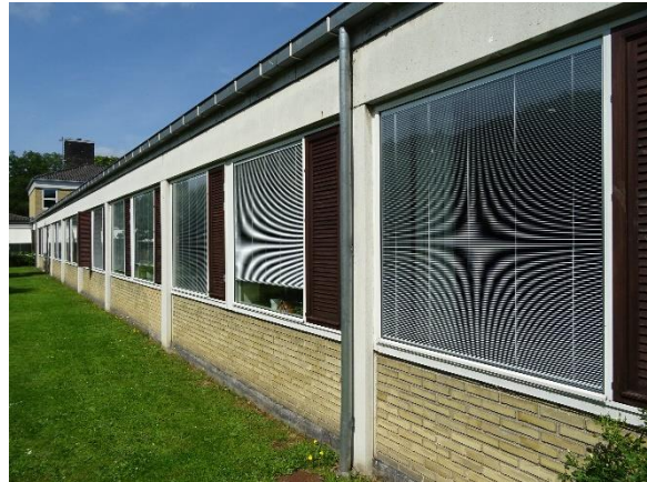
Vinduer fra 2010 med 2-lags energirude og persienser
