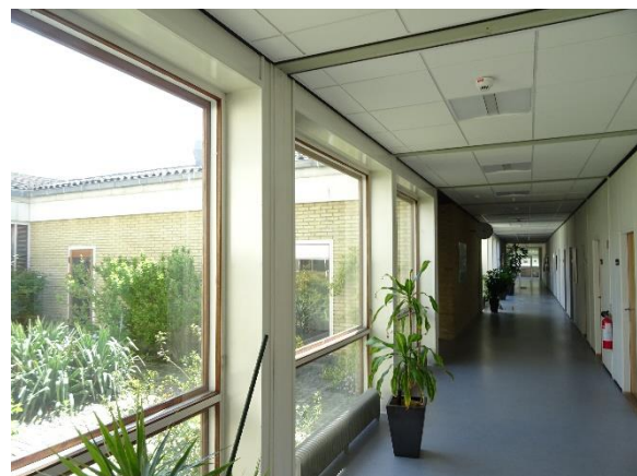
Koblede vinduer i gang
