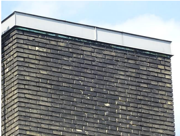
Skorstenspipe i murværk
