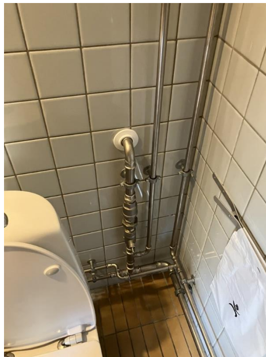
Rør udskiftet til rustfast stål
