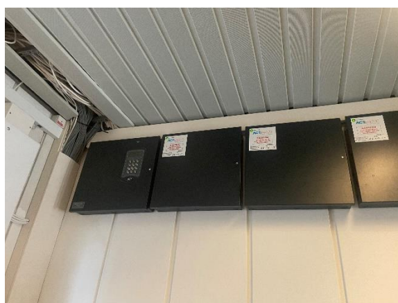
ABA detektor med fast forsyning, samt batteri backup
