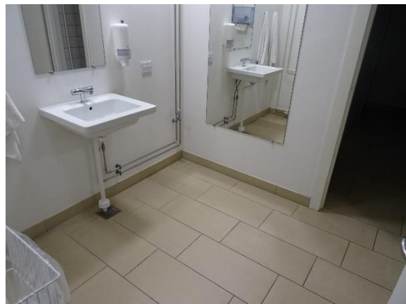
Omkledning i kælder
