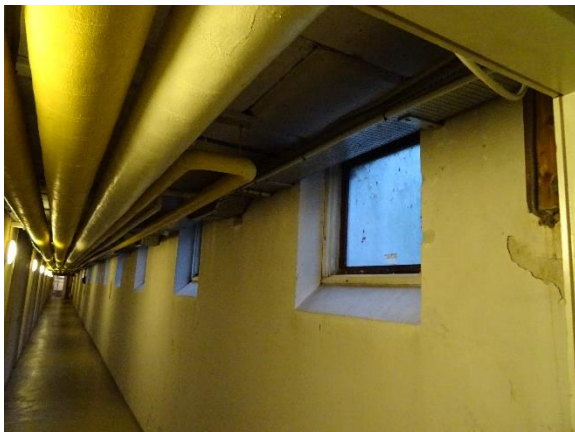
Kældergang mod nord med malet gulv
