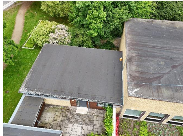
Tag på tilbygning ved byrådssal
