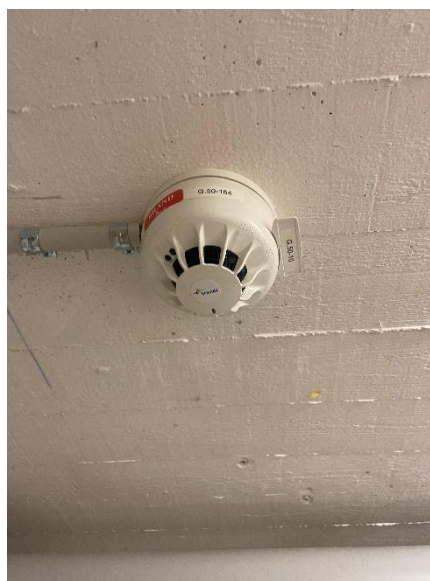
ABA detektor med fast forsyning, samt batteri backup
