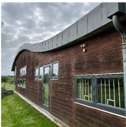
Buet tagkonstruktion med gummifolie
