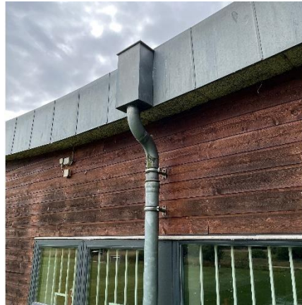
Nedløbsrør mod nord
