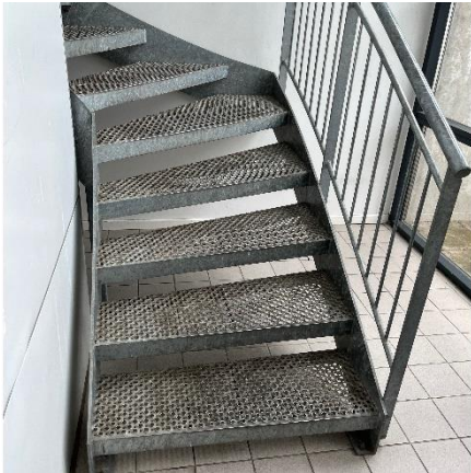
Ståltrappe i trapperum
