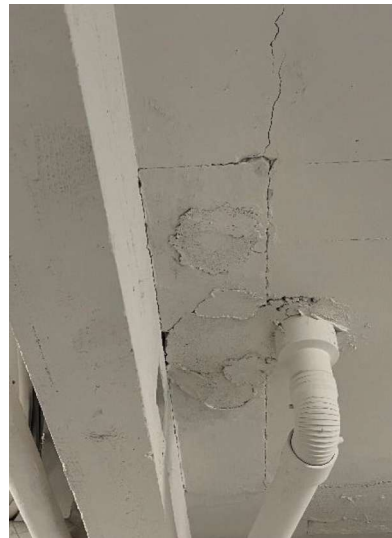
Dæk overkælder, bygning C
