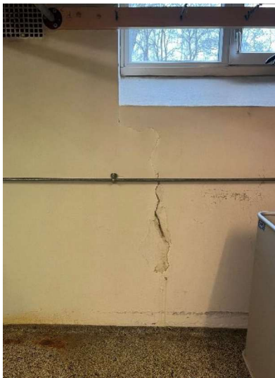
Kælderydervæg, bygning M
