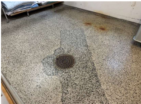
Kloakdæksel i kælder
