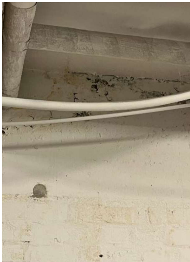
Ydervæg i gavl i kælder, bygning C
