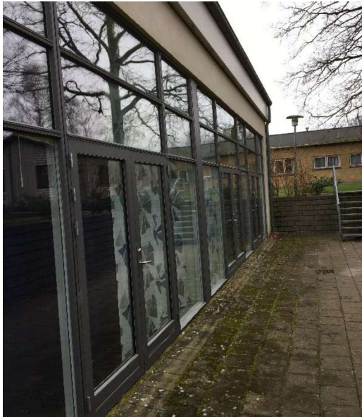
Vinduer i gavl, Møllesalen
