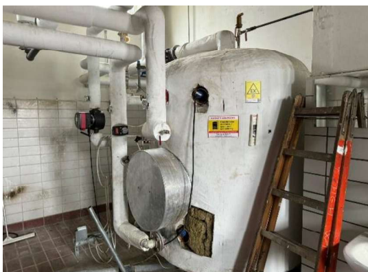
Varmtvandsbeholder fra 2002.
