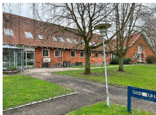
Ældre mastebelysning som bør udskiftes.
