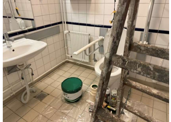
Radiator på badeværelse i bolig
