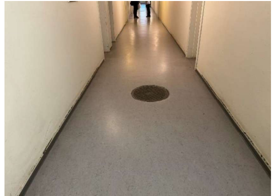
Kloakdæksel i gang
