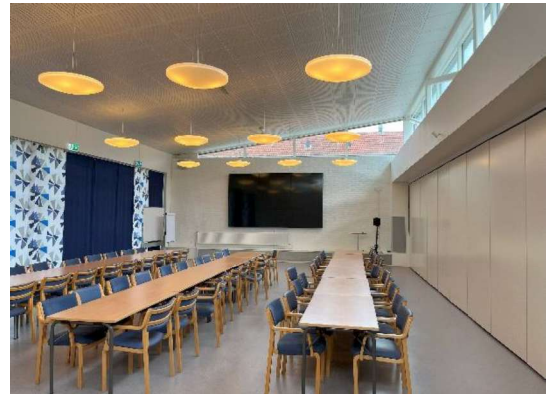
Belysningsarmaturer fra 2010 med E27 fatninger.
