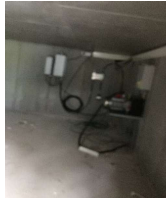
Kælderrum ved elevator
