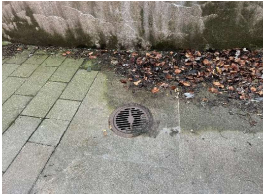
Afløbsrist ved trappenedgang
