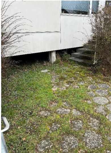
Gavl, bygning B
