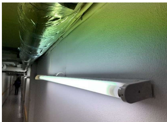
Gammelt lysrørs armatur, som skal udskiftes.
