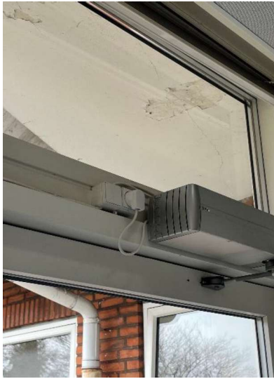
Underside etagedæk i mellembygning mellem bygning M og B
