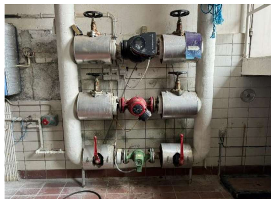
Cirkulationspumpe med tæring
