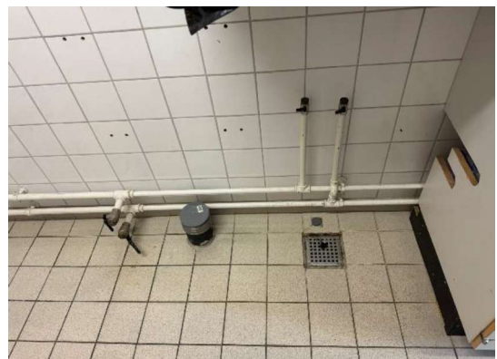
Afproppet rørføring i skyllerum.
