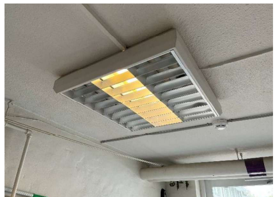
Gammelt lysrørs armatur, som skal udskiftes.
