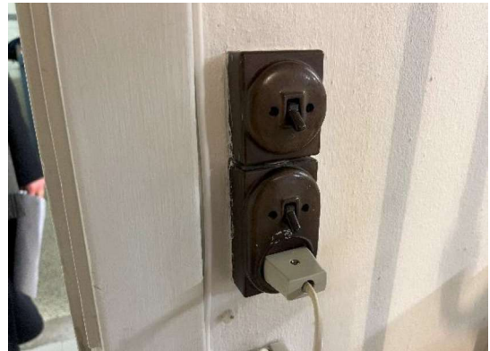
Gammelt tumbler afbrydermateriel fra 50'erne. Ulovligt at bruge i dag, medmindre man sikrer ned til 6A.
