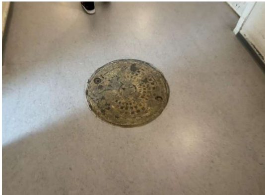
Kloakdæksel i kældergang.
