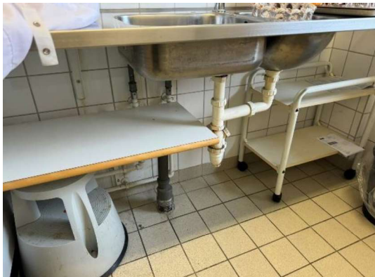
Afløb under vask udført i plast.
