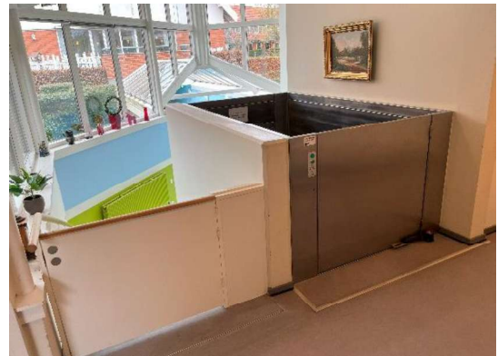
Elevator, i stueplan. Betontrappe ved siden af elevator.
