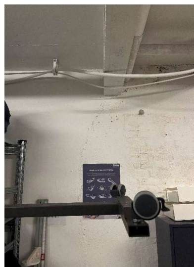
Ydervæg i gavl i kælder, bygning C
