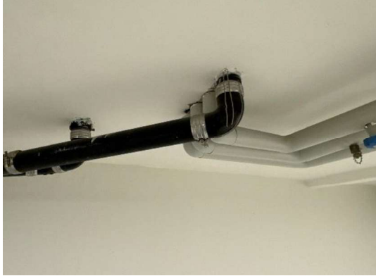
Afløbsledning i kælder
