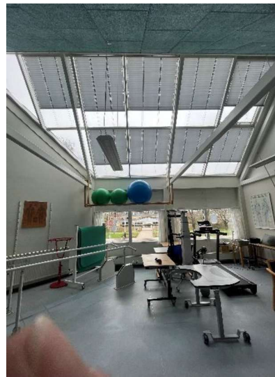
Stålramme i mellembygning mellem bygning M og C.
