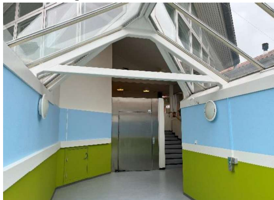
Sammenbygningen imellem bygning 1 og 2, med ældre lyskilder i belysningsarmaturerne.
