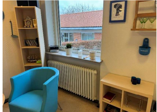
Original støbejerns radiator
