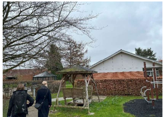
Gavl med fibercementplade
