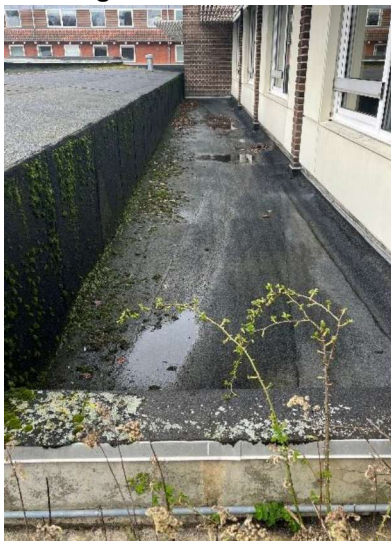
Tag mellem bygning C og Møllesalen
