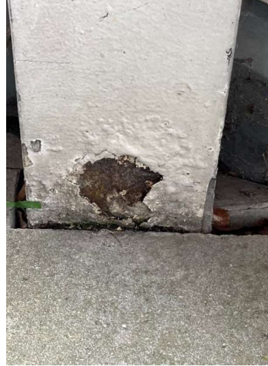
Stålsøjler på terrasse i mellembygning mellem bygning M og C. 1.sal
