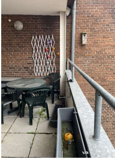
Terrasse i mellembygning mellem bygning M og C
