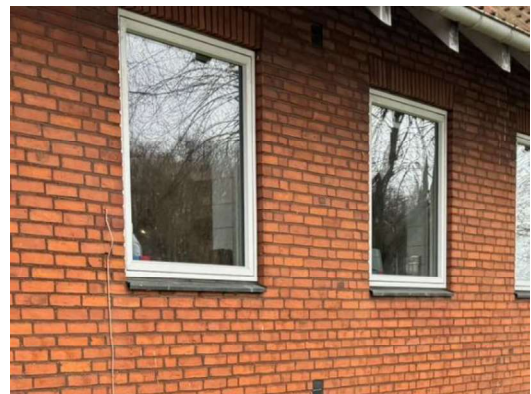
Vinduer i facade
