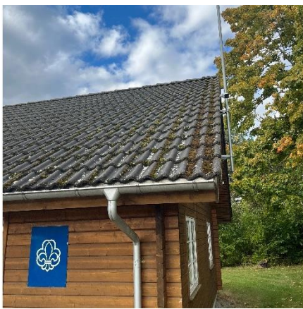
Tagkonstruktion med betontagsten
