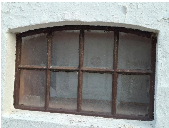
Støbejernsvindue i bygning 3
