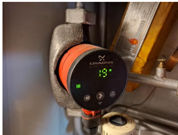
Varmefordelingspumpe bygning 3
