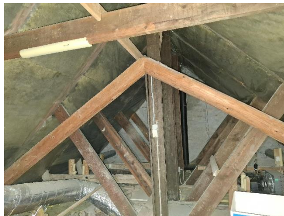
Loftrum tilbygning mod syd bygning 2
