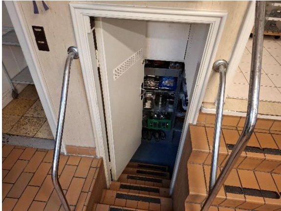
Kælderrum tilknyttet køkkenet.
