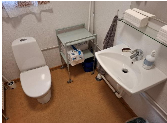
Toilet i bygning 3
