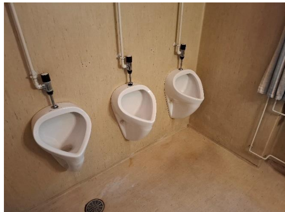
Pissoir i bygning 2
