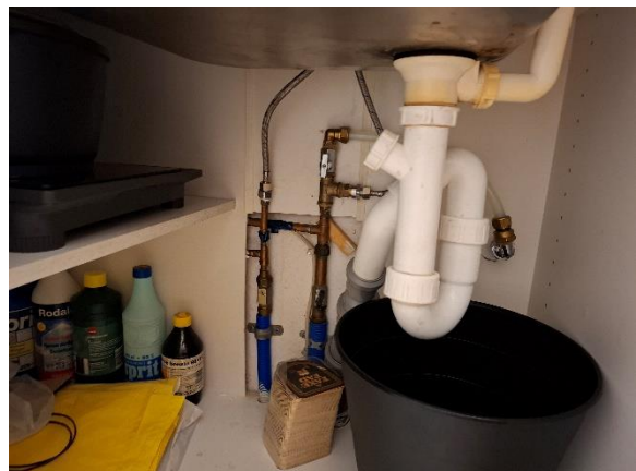
Afløb under køkkenvask i bygning 3
