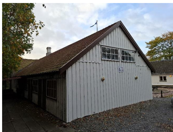
Træbeklædning mod nord, bræddebeklædning går helt ned til terræn
