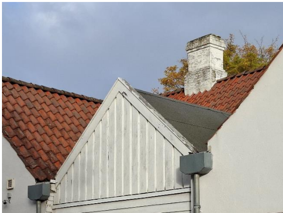
Mellembbygning mod syd med tagpap.
