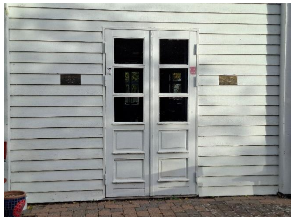
Dør i tilbygning mod syd
