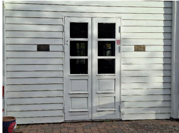
Dør i tilbygning mod syd
