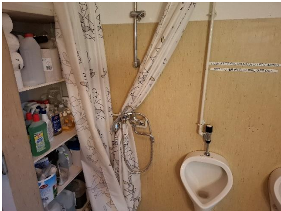
Bruseniche i bygning 2.
