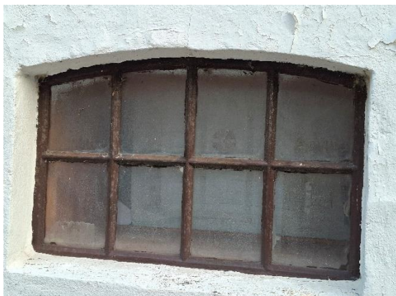
Støbejernsvindue i bygning 3
