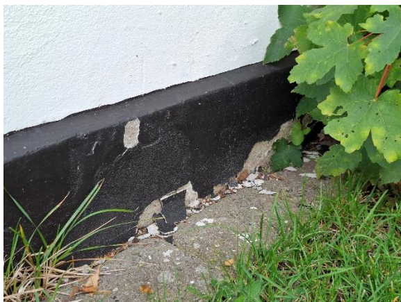
Afskalning på sokkel
