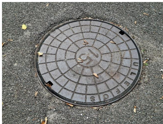
Støbejernsdæksel.
