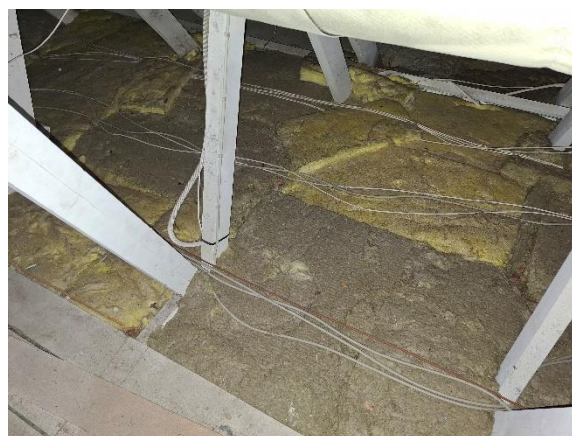
Mod udnyttet tagrum, 300 mm mellem spær
