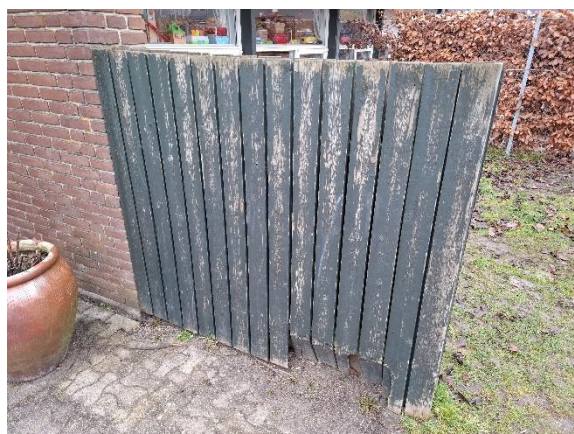
Læhegn med nedbrudt træværk.
