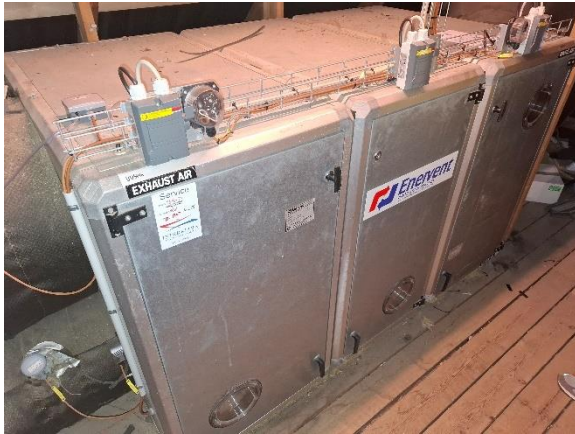
Aggregat Enervent LTR25 med rotorveksler
