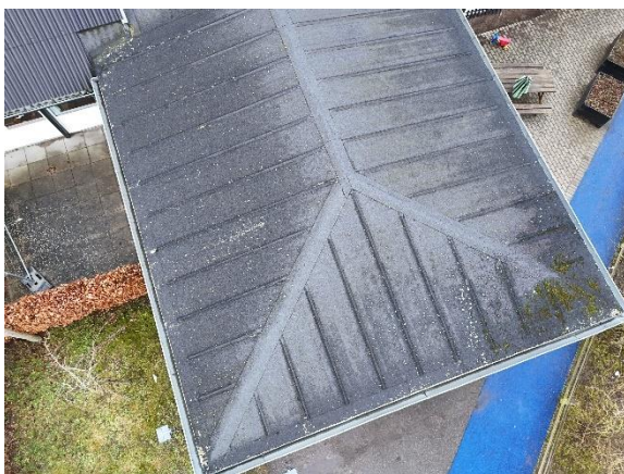
Tilbygning med pap med lister
