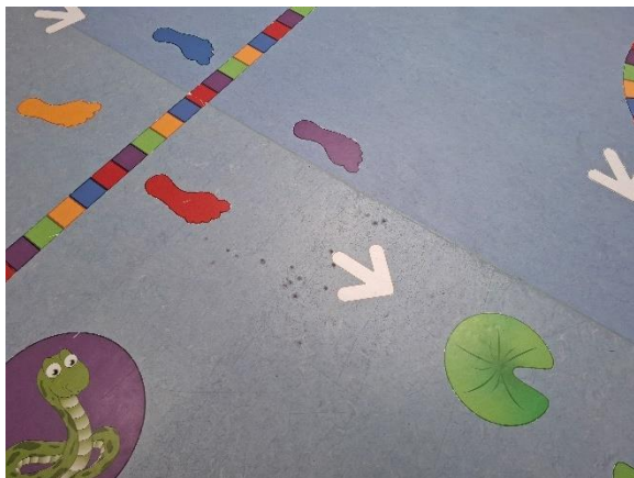
Overgang mellem ny og gammel linoleumsbelægning
