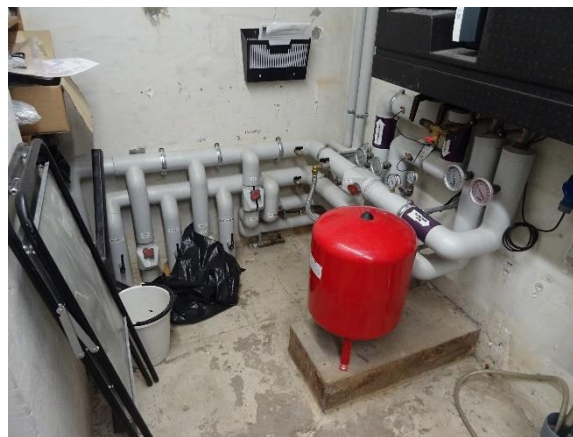
Fordelingsrør og ekspansionsbeholder
