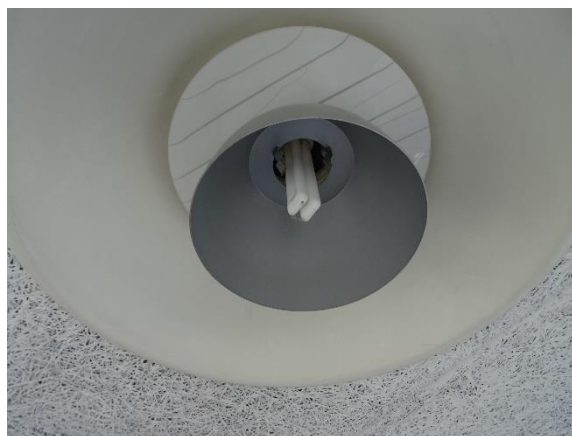
Pendel med kompaktlysstofrør.
