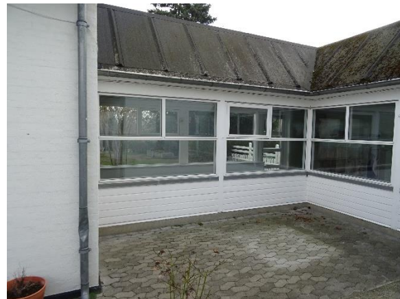
Forbindelsesgang i let konstruktion
