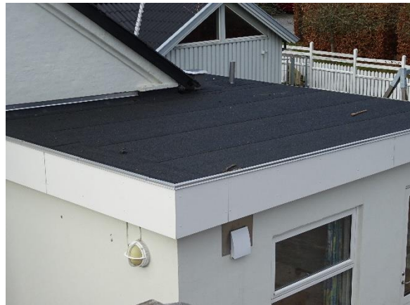
Tagpap på tilbygning nordøst
