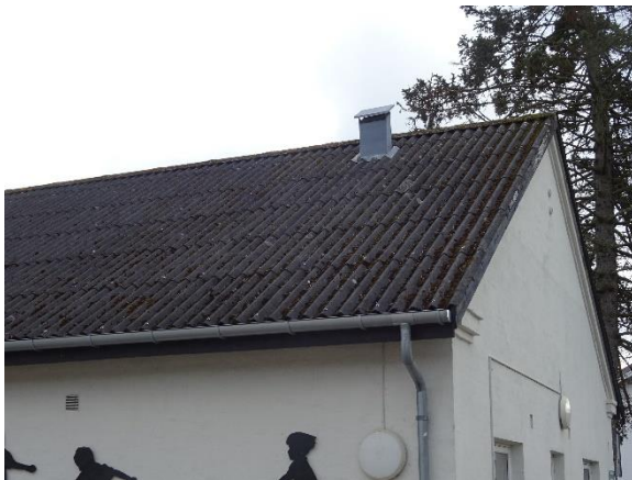
Eternittag sidebygning syd
