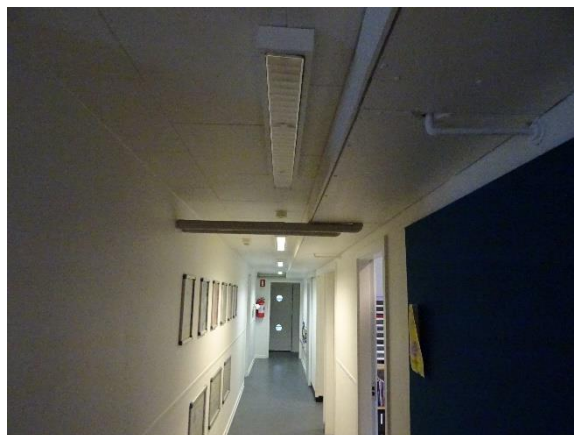
Rørkasse med afgreninger til tapsteder
