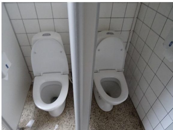
Børnetoiletter, nyere sanitet og ældre terrazzo gulv
