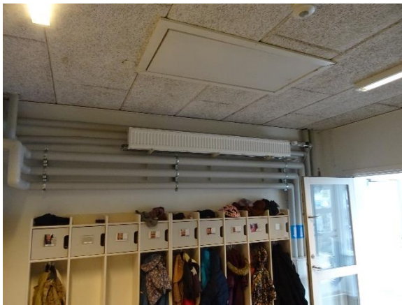
Rør overgang fra rørgrav til rørkasse under lofter i gang
