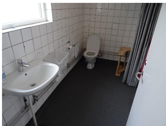
Personalettoilet, nyere vinyl på gulv
