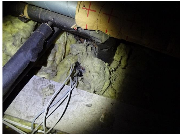
Varmerør på loft, nordfløj
