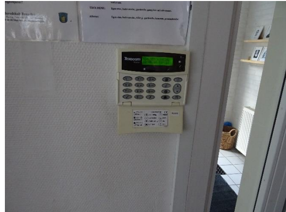
Kodetastatur for AIA indbrudsalarm
