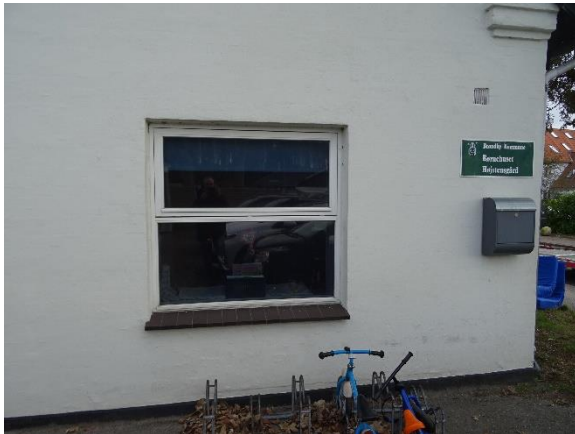
Trævindue med energirude i sidebygning syd
