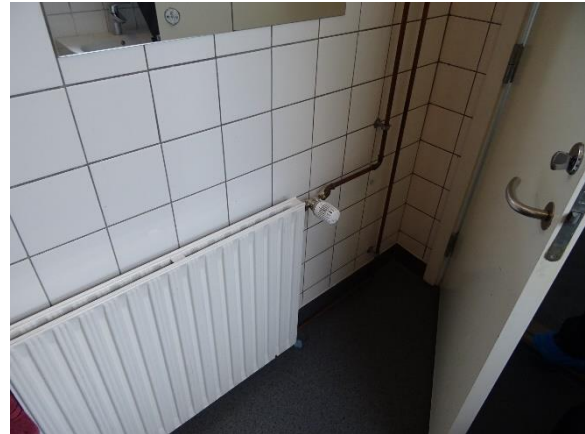
Radiator fra renovering i 1960'erne
