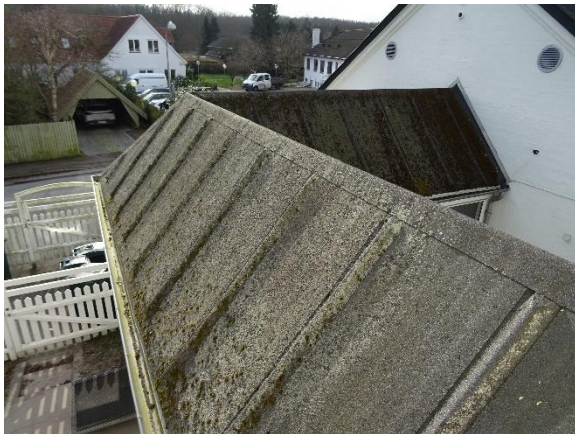
Tagpap med listedækning, forbindelsesgang
