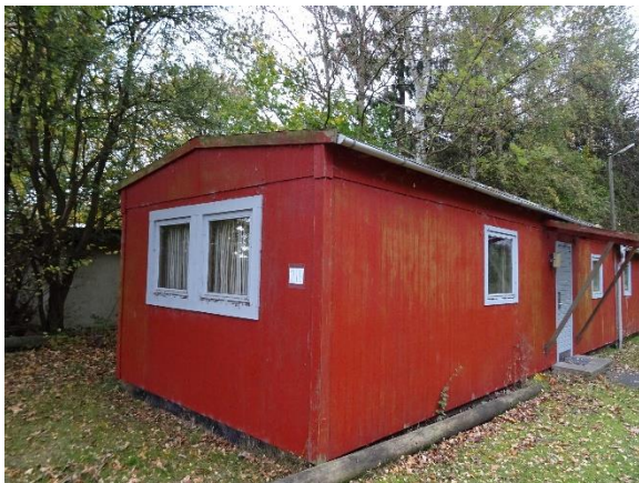
Trævinduer i pavillon, øst og nord
