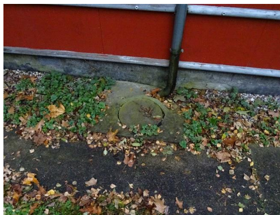
Fundament på spejderhytte
