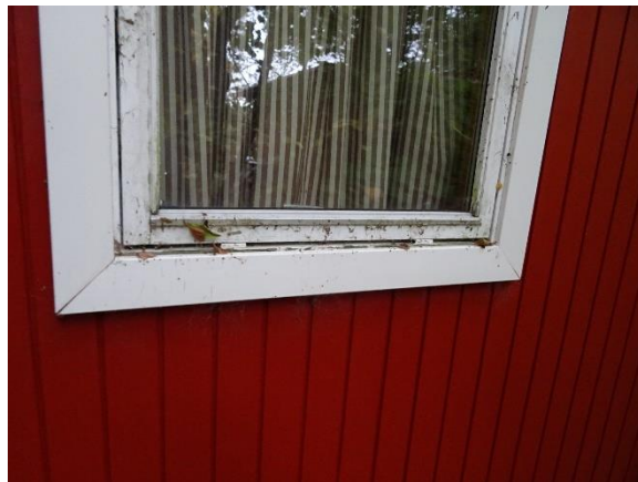
Trævindue og indfatning
