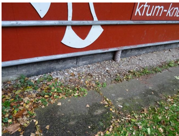
Fundament på spejderhytte
