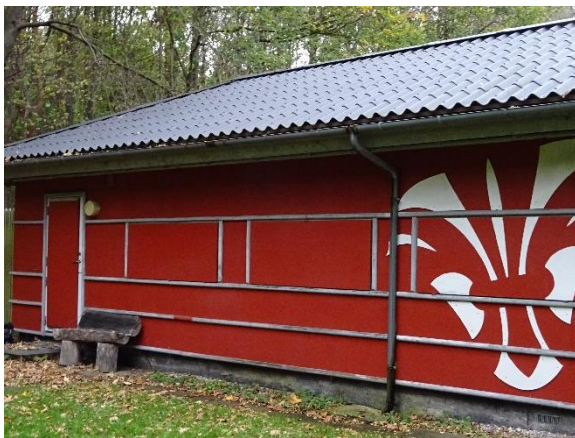
Vinduer afblændet med skodder
