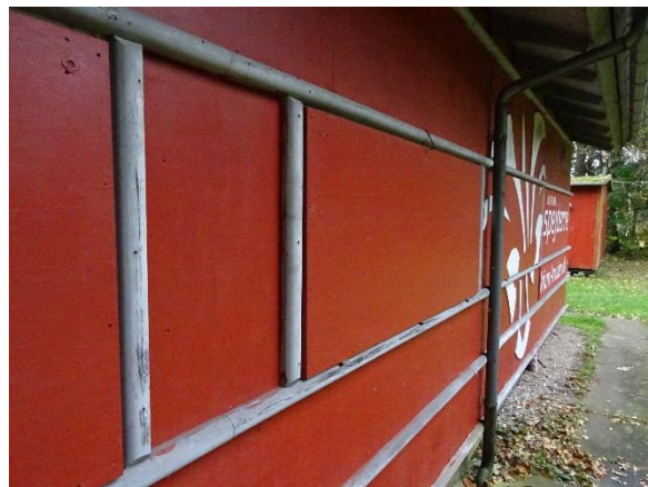
Vinduer afblændet med skodder
