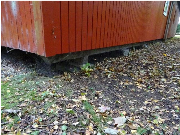
Fundament på pavillon
