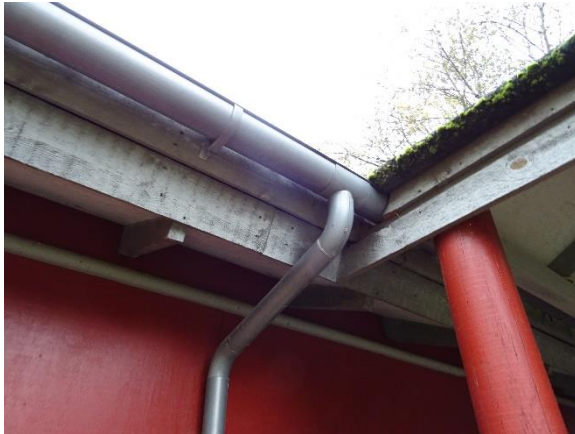
Tagrende og nedløb ved bislag
