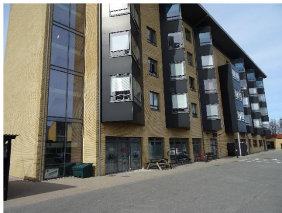
Facader nr. 32 iht. BR95 eller BR08, min. 125 mm murfilt og 150 mm i lette partier.
