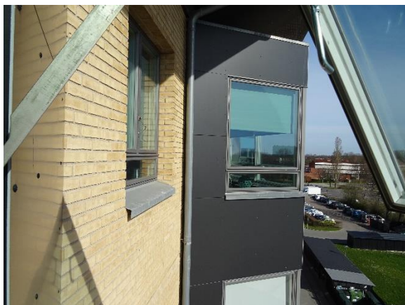
Trelags aluvinduer fra 2009 m. energiruder nr. 32
