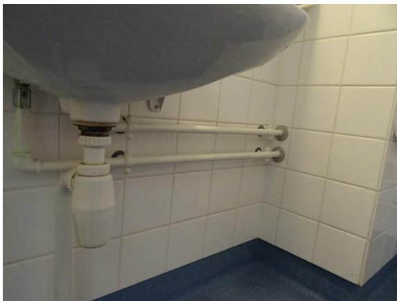
Vandinstallation på badeværelse, galvaniserede rør ud fra skakt
