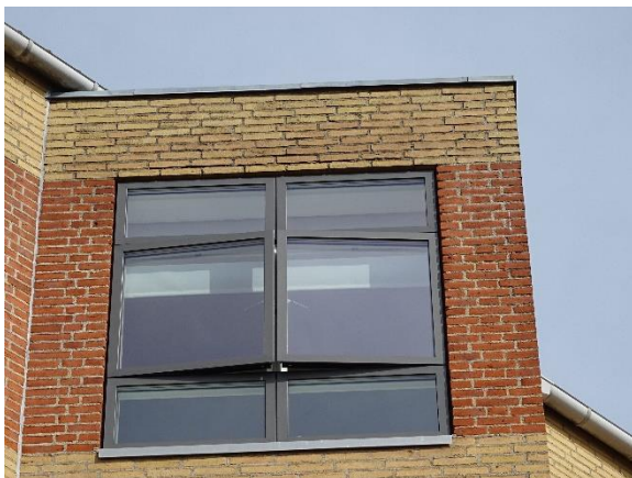
Trelags aluvinduer fra 2017 m. energiruder nr. 30
