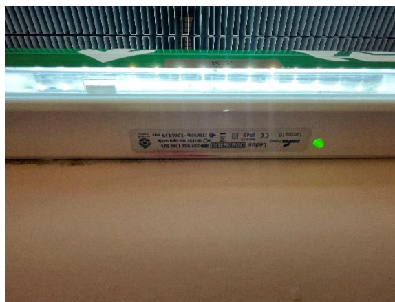
Eksempel på LED panikbelysning, generelt i nr. 30 og 32
