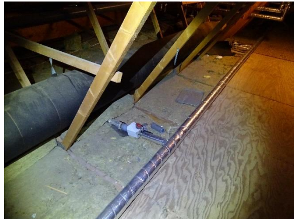
Varmefordeling på loft
