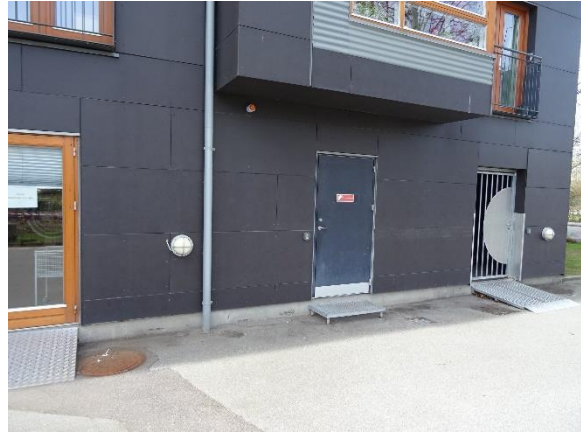
Nedløb og brønddæksel
