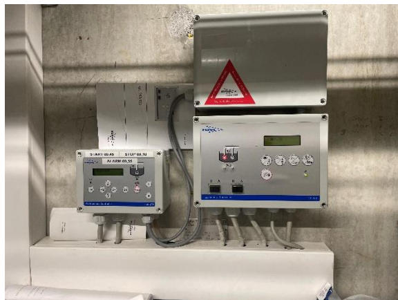
Pumpestyring for pumpebrønd i kælder ved vent. rum
