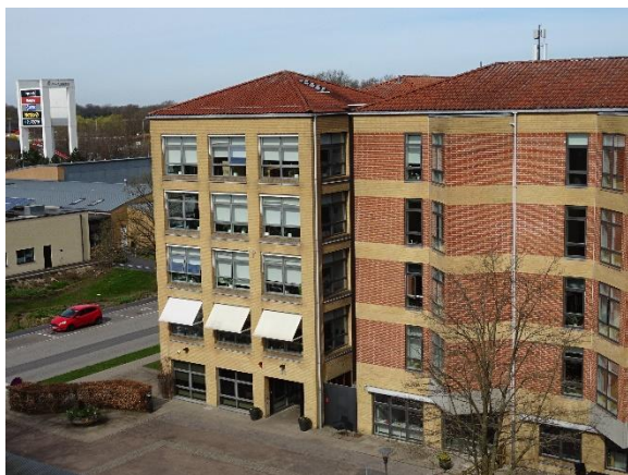
Facader nr. 30, 125 mm murfilt iht. BR82
