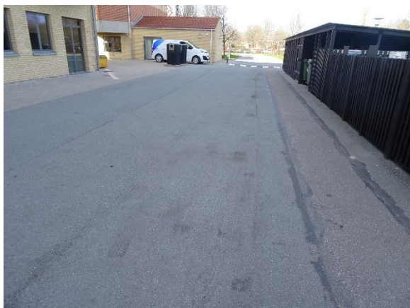
Asfalt kørevej for affaldsgård, etableret 2010
