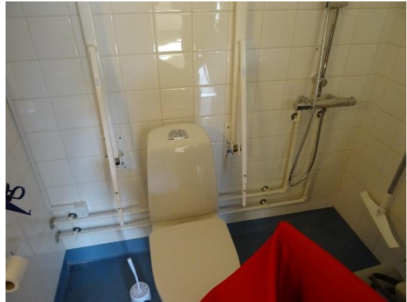
Toilet og bad, bolig i nr. 30
