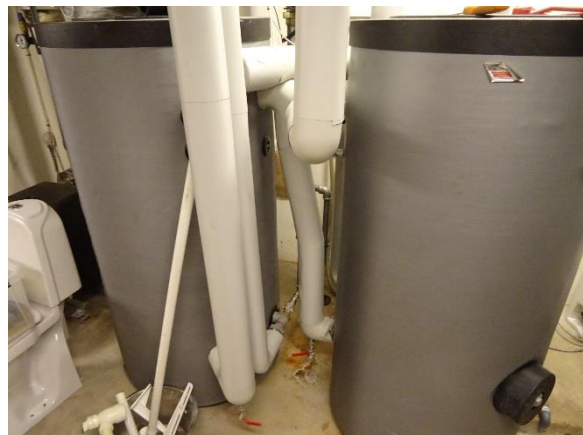
Varmtvandsbeholdere i nr. 30, serieforbundne
