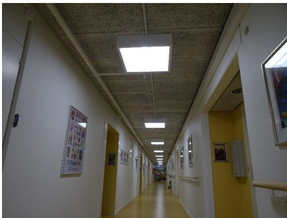
Løfter træbeton i nr. 30
