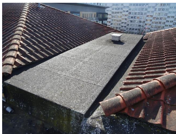
Tagpap på plinte mellem tegltage
