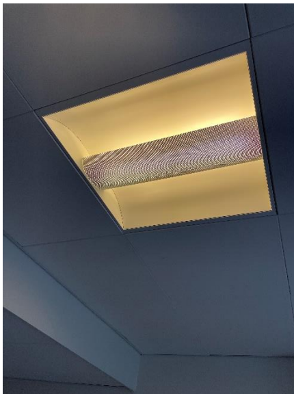
Glamox 55 W kompaktørørarmatur
