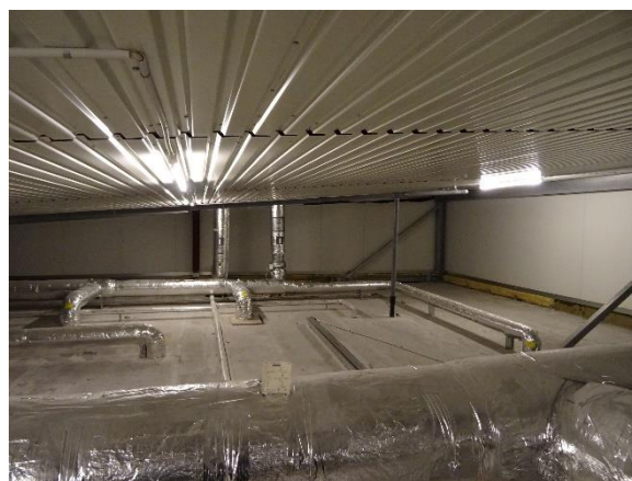
Tagrum nr. 32 under isoleringen
