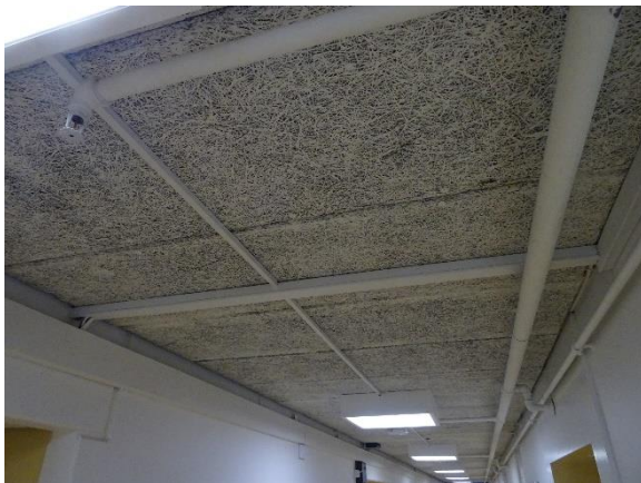
Træbeton med stødsamlinger i gang
