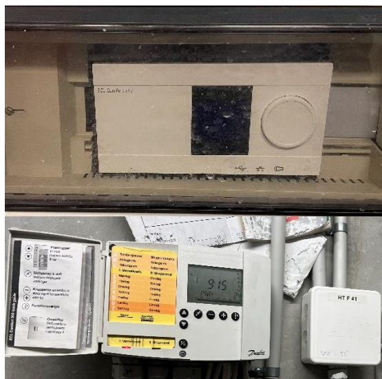
Opdater ECL Comfort varmestyring System kort ukendt Udfaset ECL Comfort varmestyring System kort C66 Komfort modul i tekniktavle
