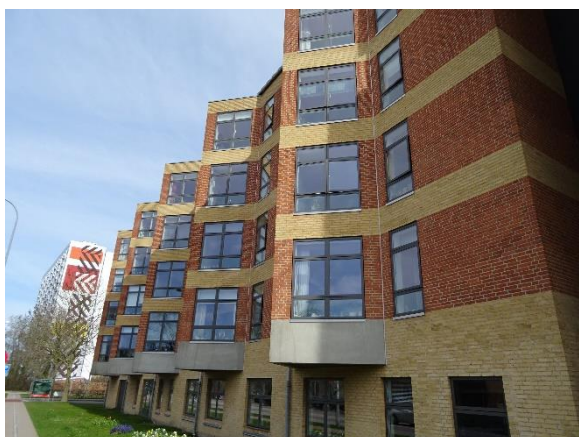
Træ/alu vinduer i bygning fra 1988
