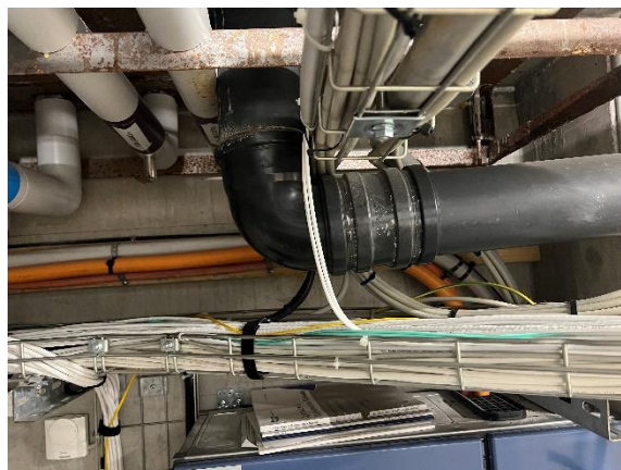
Installation gennemføring med bagfald kælder nr. 32
