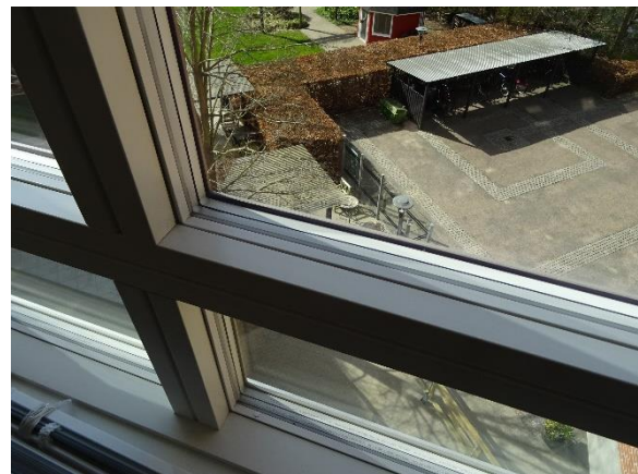
Trelags aluvinduer fra 2017 m. energiruder nr. 30
