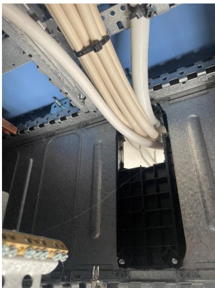
Membran for gennemføring i tavle er ikke forseglet korrekt i karate klubben
