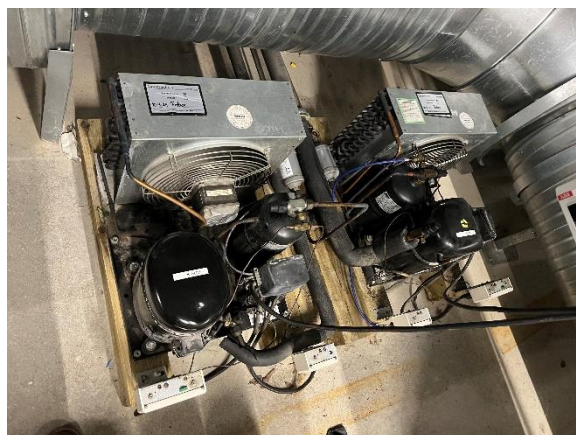
Kølekompressorer kølerum køkken
