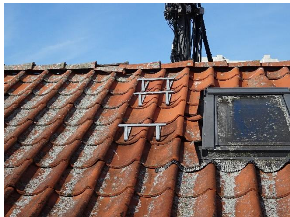
Ødelagte/forskudte tegl omkring tagvindue og rygning pga. mobilantenne
