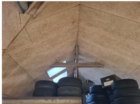
Bygning 1 – Lofter med træbeton
