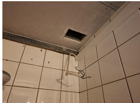
Aftrækskanal i bad forberedt til ventilator.
