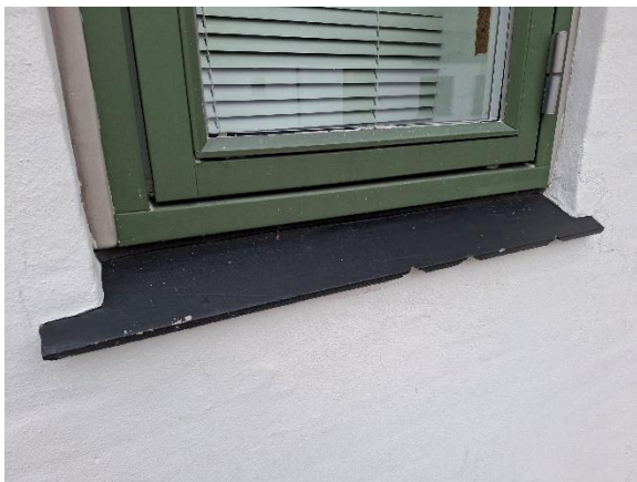
Bygning 1 – Sålbænke er med mindre skader enkelte steder.
