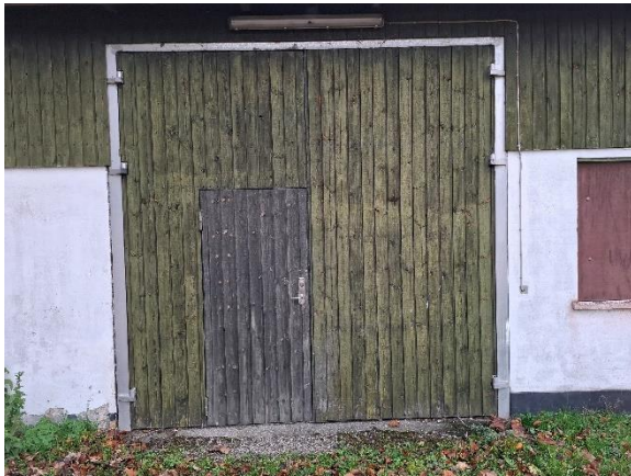
Bygning 2 – Port med dør
