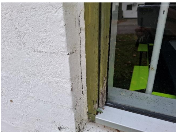
Bygning 1 – Sålbænke er med mindre skader enkelte steder.
