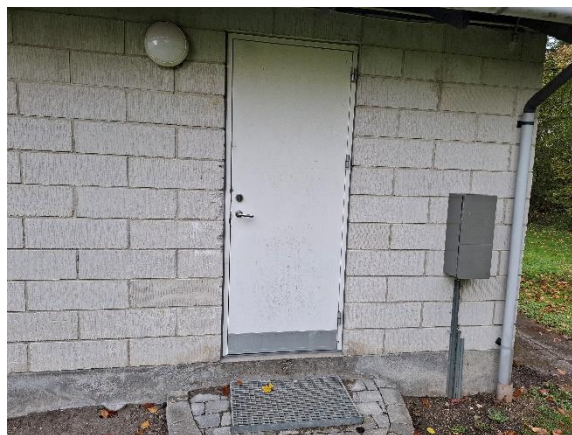
Bygning 3 – Nyere pladedør
