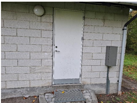
Bygning 3 – Nyere pladedør
