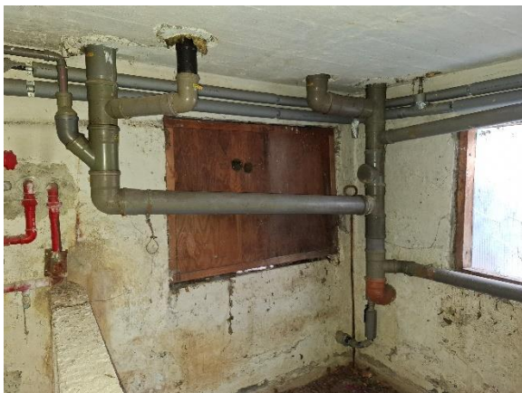
Afløbsrør i kælder
