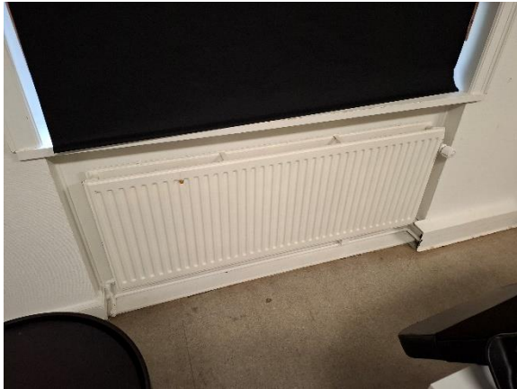
Radiator med termostatventil
