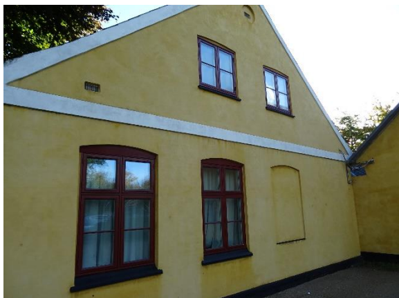
Vinduer i stuehus
