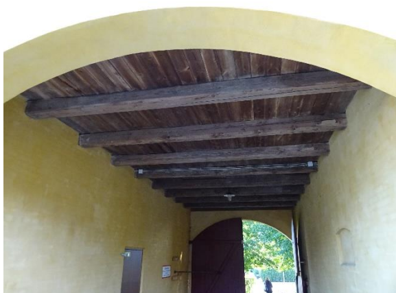
Bjælkeloft i port mod nord
