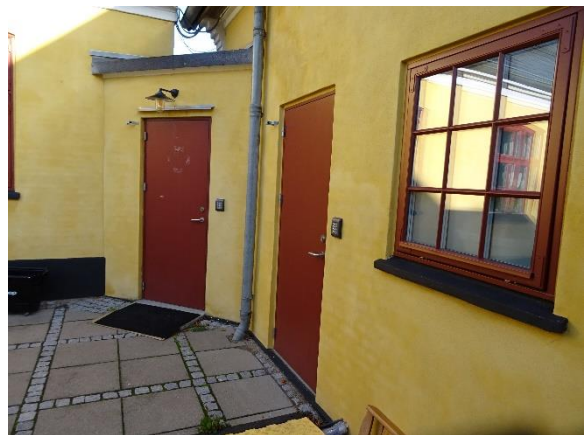
Pladedøre med isolering
