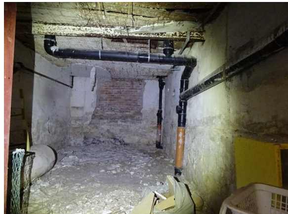
Kælder under hovedhus
