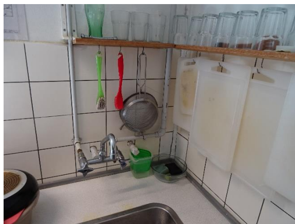
Vandtilgang i køkken til armatur
