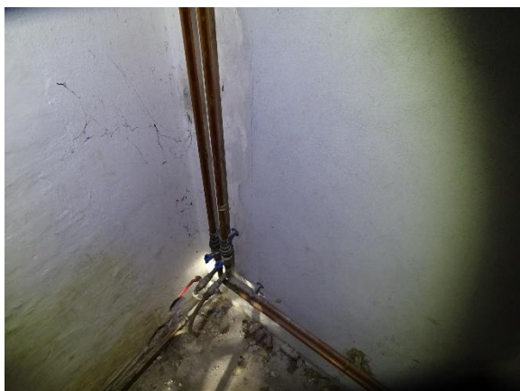
Uisolerede varmefordelingsrør
