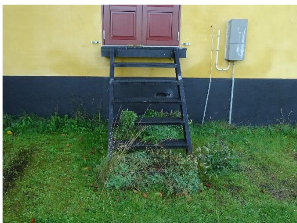
Udvendig trappe til trapperum
