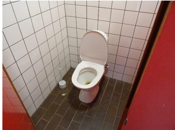
Ældre toilet med to skyl
