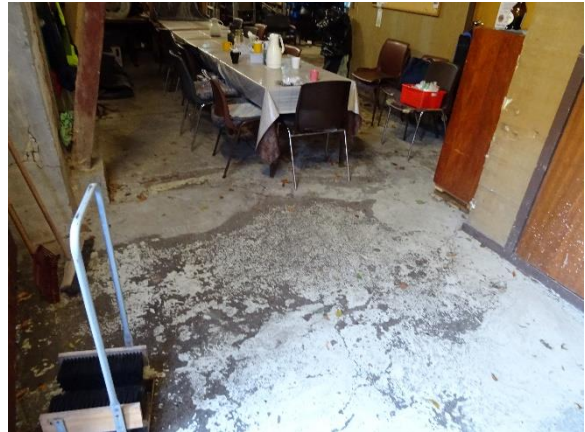
Gulv i lade i grovbeton
