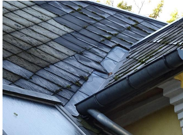
Diagonallagt eternitskifer omkring skotrende
