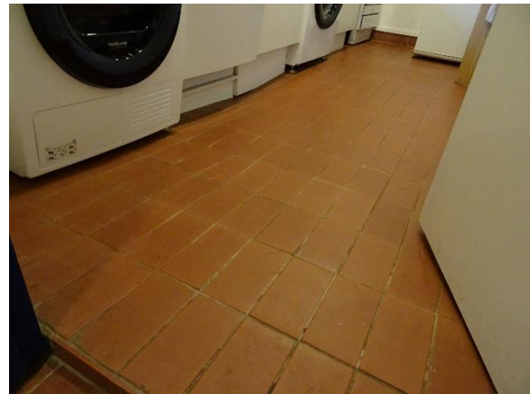
Opbuling af fliser i vaskerum
