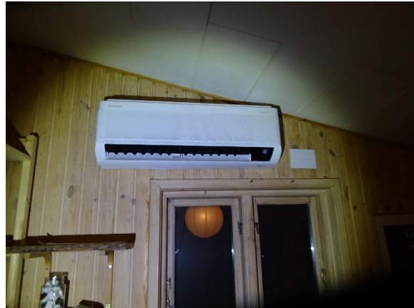
Varmepumpe indedel Fritidshuset
