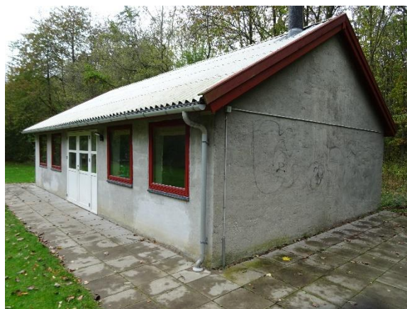
Facade og gavl mod øst
