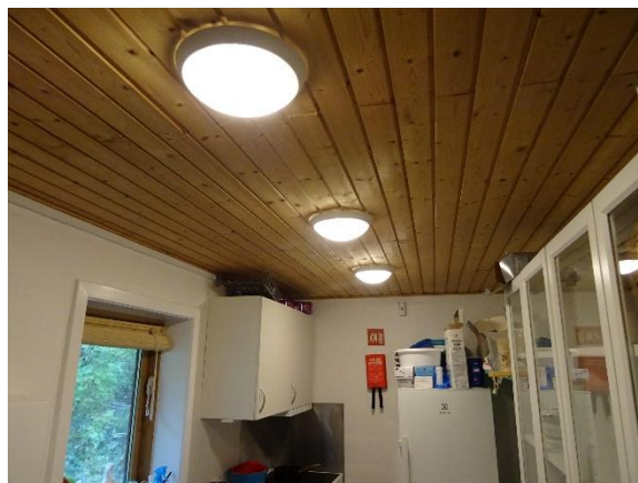
Loft i vaskerum, profilbrædder i hele bygningen
