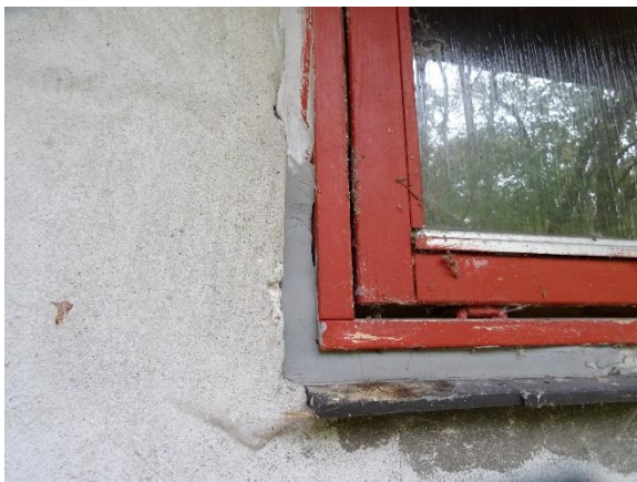
Elastisk fuge nedslidt / punktrepareret
