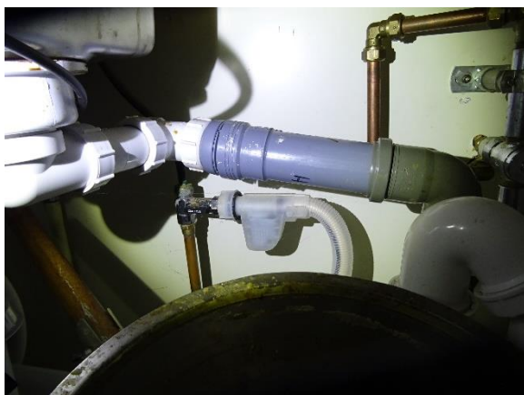
Afløbsrør under køkkenvask
