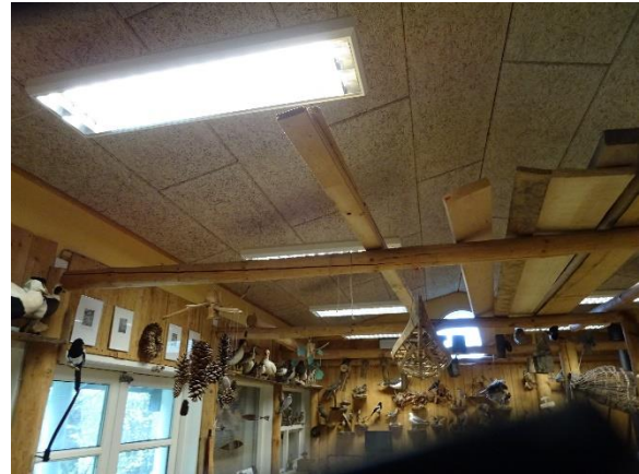
Loft i undervisning, træbeton
