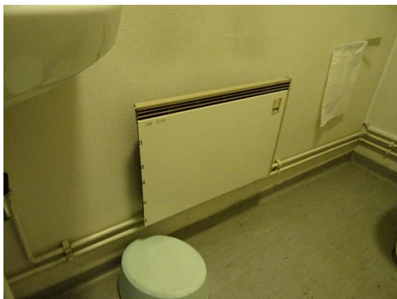
Vandrør i malet kobber
