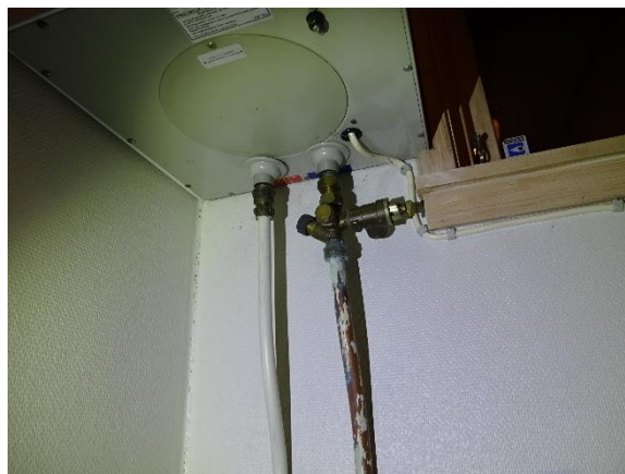
Tilgang og afgang fra varmtvandsbeholder i kobber
