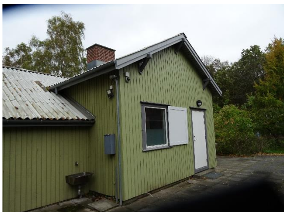
Nyere pladedør fra brandsikring i 2022
