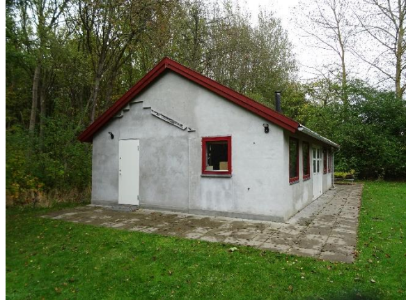
Indgangsdør, ny hvor bygning har været indtil 2016
