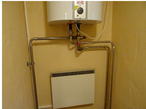
Elvandvarmer med tilførsel og afgang i rustfrit stål
