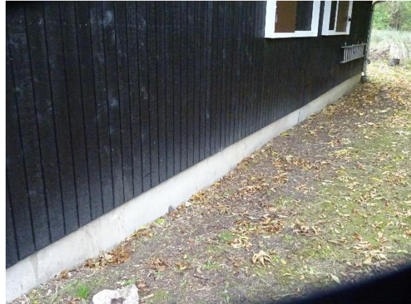
Sokkel i eternitplade mod øst
