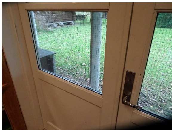
Terrassedør, rude fra 2003
