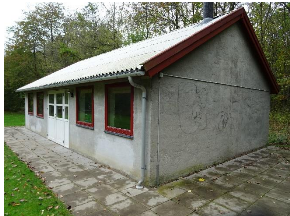
Flise lagt i 2016
