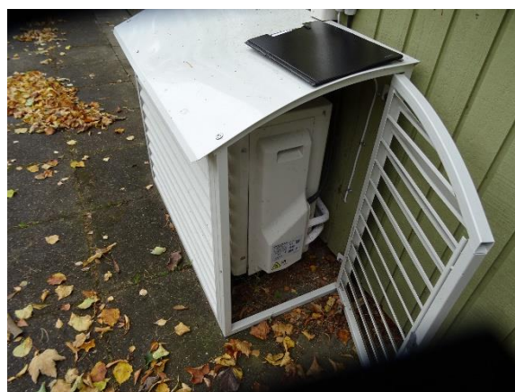
Varmepumpe fra 2025 nordfacade
