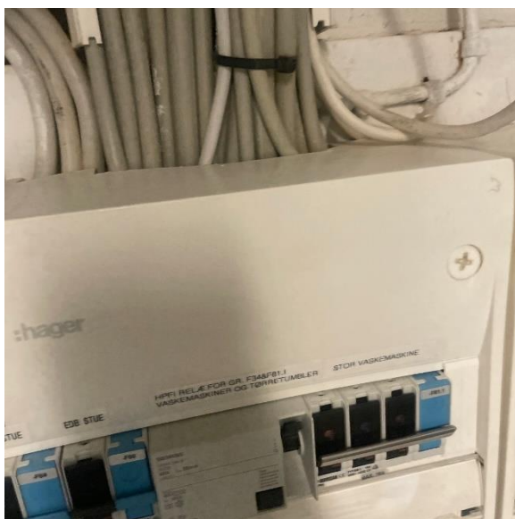
For stor gennemføring i sektionstavle
