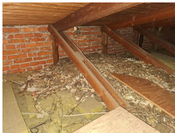
Loftrum bygning C
