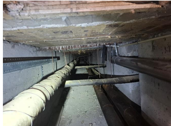
Dæk over krybekælder bygning C
