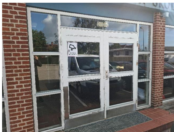
Udvendig dør i bygning F
