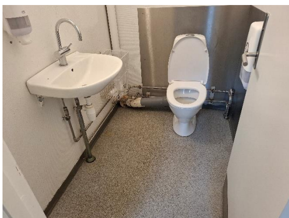
Nyere toilet med 2 skyl samt 1-grebs armatur.
