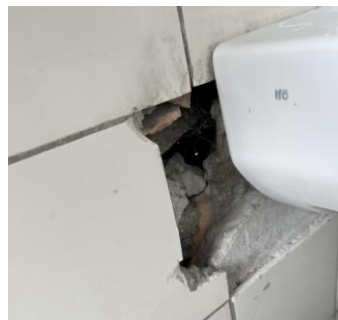
Personale toilet hul på væg ved vægmonteret vask
