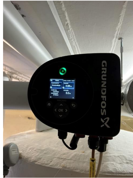
Brugsvand cirkulationspumpe
