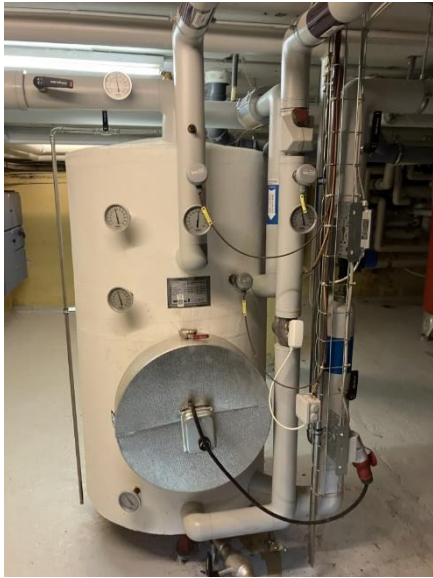
Varmtvandsbeholder
