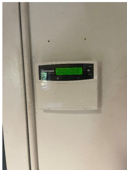
Dør alarm ved hovedindgang til indskoling fabrikant Texecom
