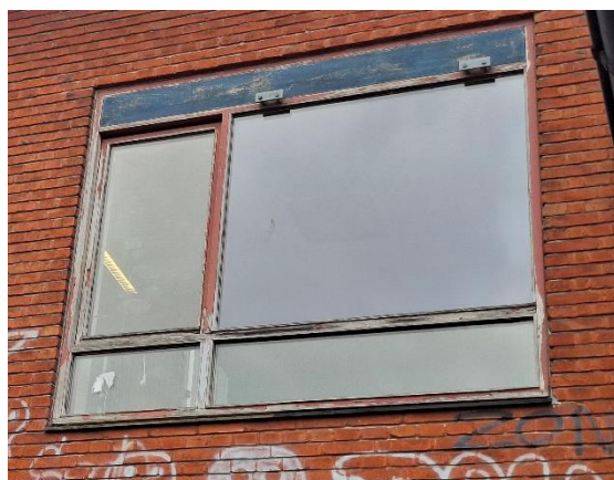
Vindue i bygning C mod nord
