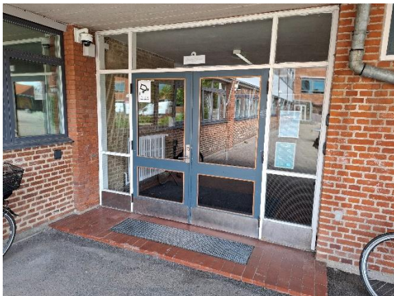
Oprindelige indgangspartier i træ med netarmeret glas er slidt men funktionsdygtige.
