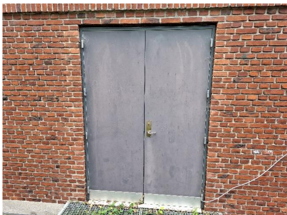
Pladedør til multisalenen i bygning D
