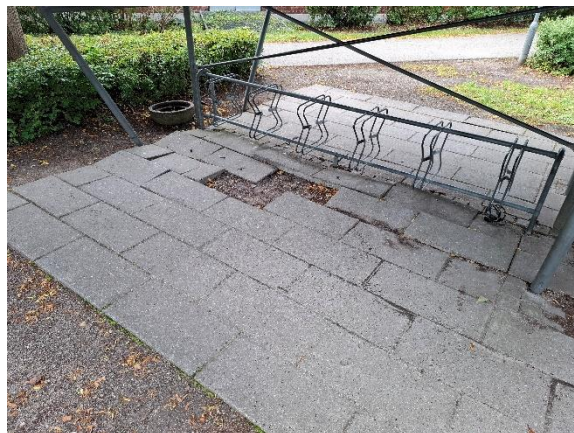
Flisebelægninger og afløbsbrønd fra cykeloverdækninger
