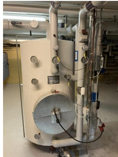
Varmtvandsbeholder
