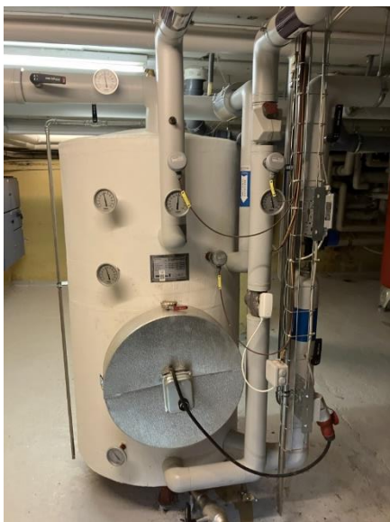
Varmtvandsbeholder
