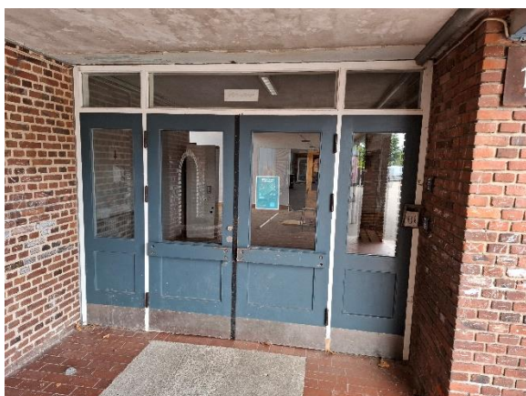
Oprindelig dør i bygning C
