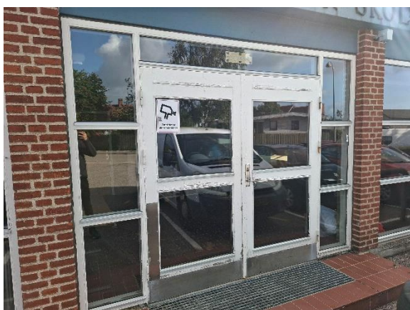
Trædør i bygning F mod vest fra 2010
