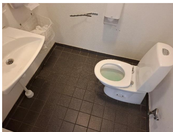
Nyere toilet med 2 skyl
