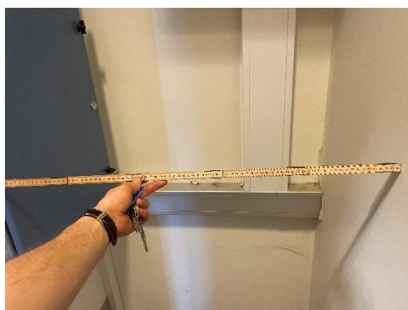
For lille afstand til tavleåbning i sektionstavle
