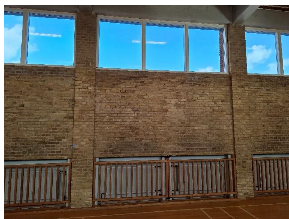
Ydervæg i sportshal i bygning F
