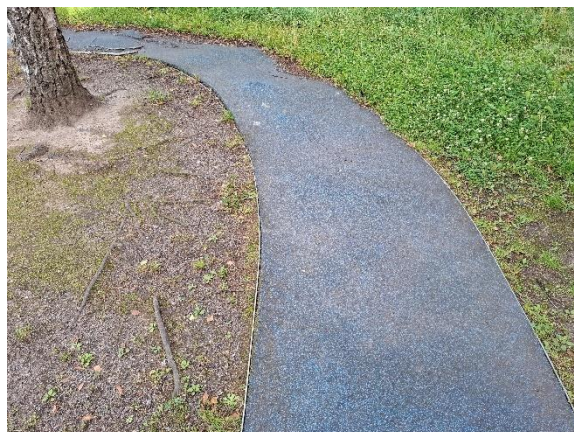
Skridsikkert underlag med buler pga. rødder fra træ
